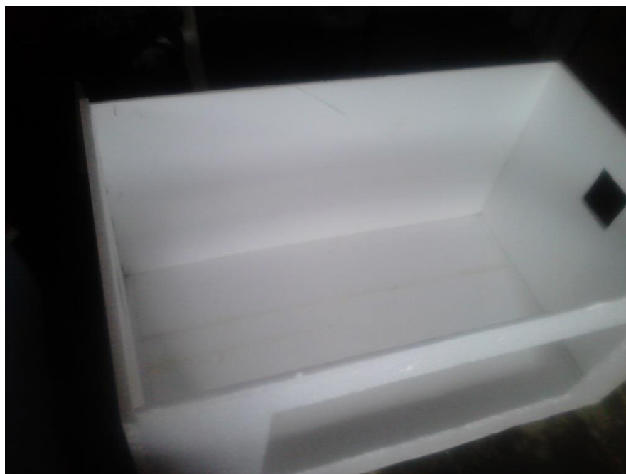
Figura 9. Vista interna de la recámara del sistema HVAC aspecto inicial
