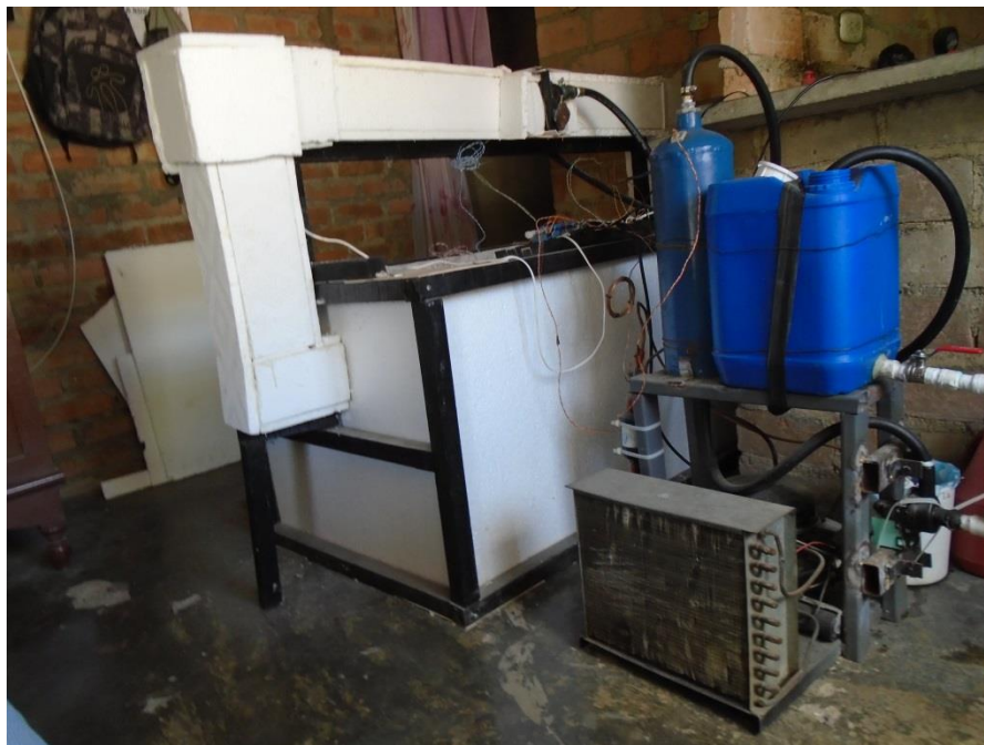
Figura 13. Sistema HVAC (planta piloto)
