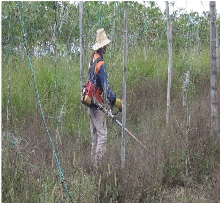
Fotografía 11. Limpieza del terreno
