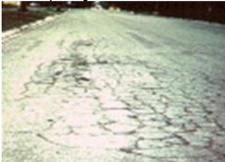
**Figura 7. Propagación del fisuramiento a través de la capa asfáltica.**
