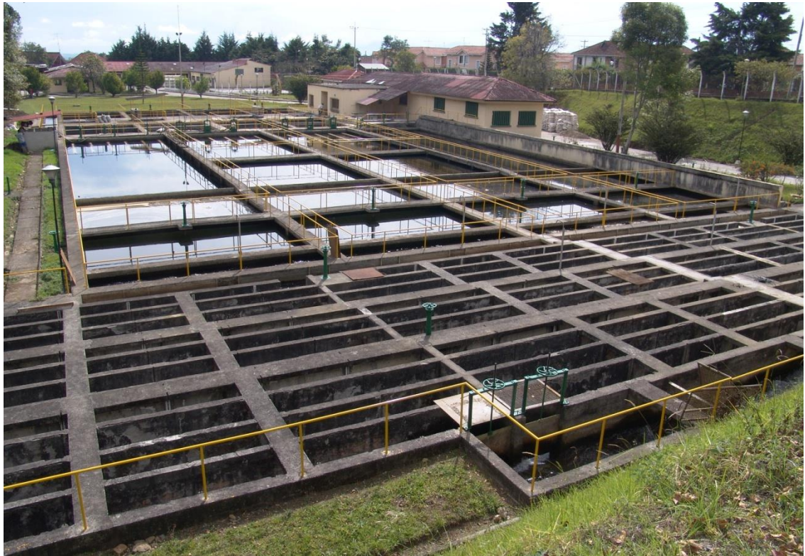
Figura 2. Planta de Tratamiento El Tablazo
