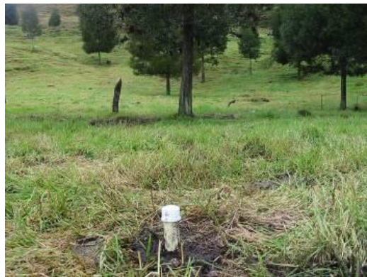
Figura 10. Instalación de Piezómetros
