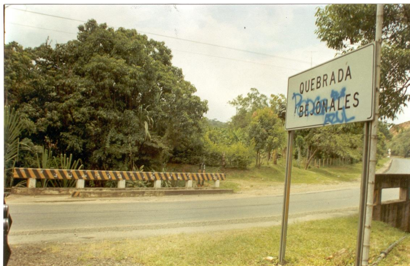
Figura 6. Puente sobre la quebrada Abejonales vía Popayán - Cali.
