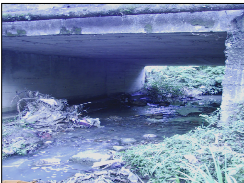
Foto 3. Estación la Arboleda, a la altura del puente del barrio la Arboleda
