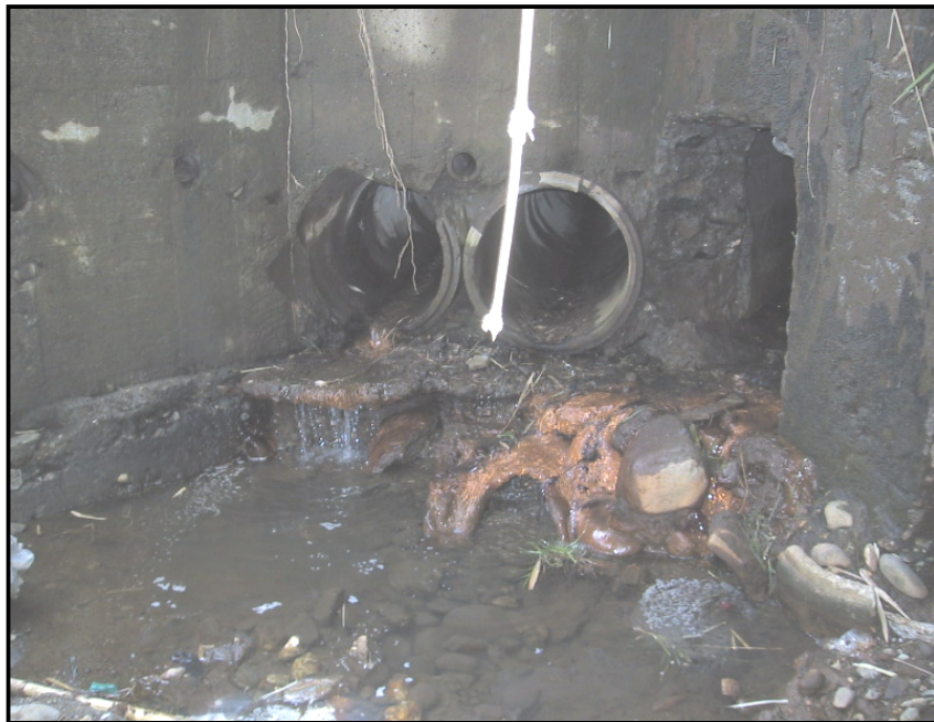
Foto 2. Desagües de aguas lluvias y residuales en la estación Mallorca
