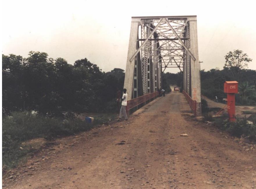
Figura 4. Puente La Balsa, municipio de Buenos Aires.
