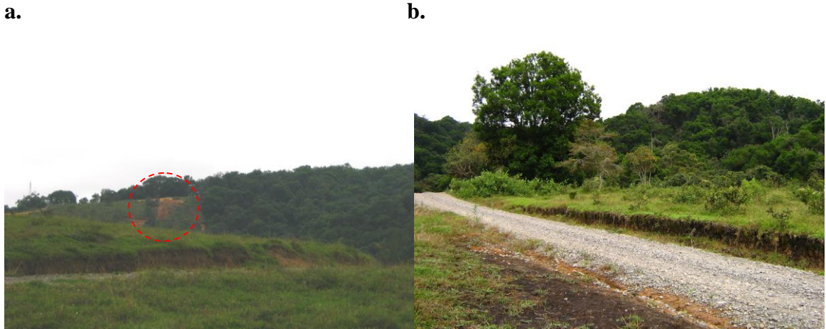
Figura 21. (a) Corte realizado a parte del bosque Las Guacas para la construcción del nuevo acueducto de Popayán (b) carretera construida hasta la planta de tratamiento del acueducto.
