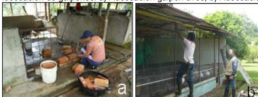
Figura 13. Adecuación de galpones. a) Adecuación galpón aves; b) Adecuación vivares
