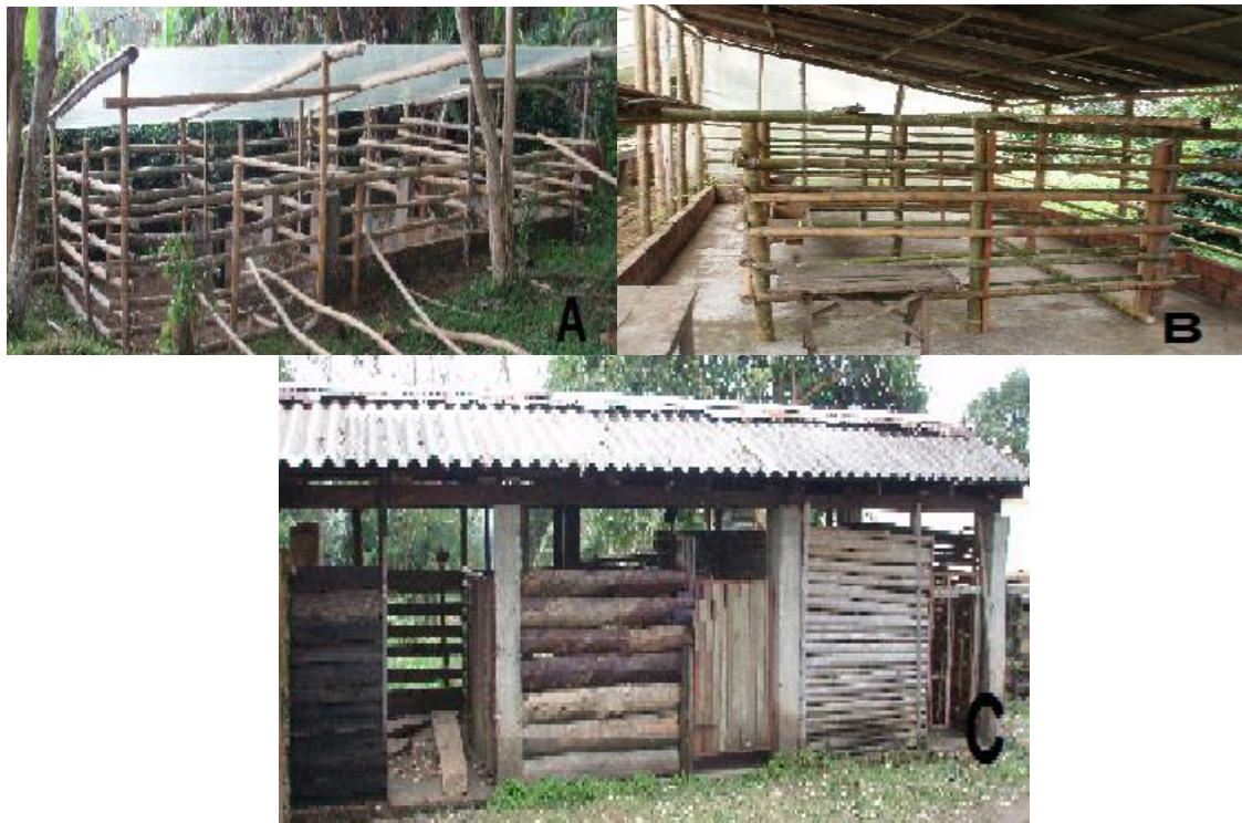
Figura 4. Establos luego de la adecuación. (A) Establo 1, (B) Establo 2 y (C) Establo 3
