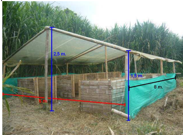
Figura 3. Cubierta tipo invernadero
