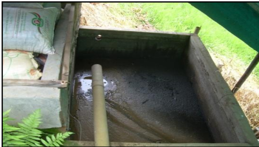
Figura 14. Tanque recolector El Madrigal
