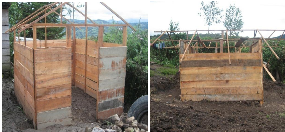
Figura 17. Construcción del galpón de cuyes, vereda Tambillo de Bravos municipio de Linares
