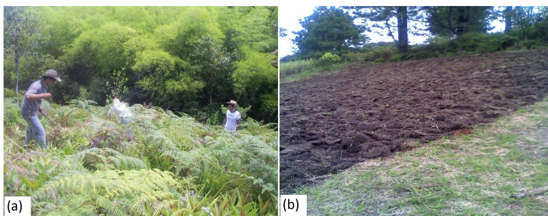
Figura 7. Adecuación del terreno (a) limpieza y (b) nivelación
