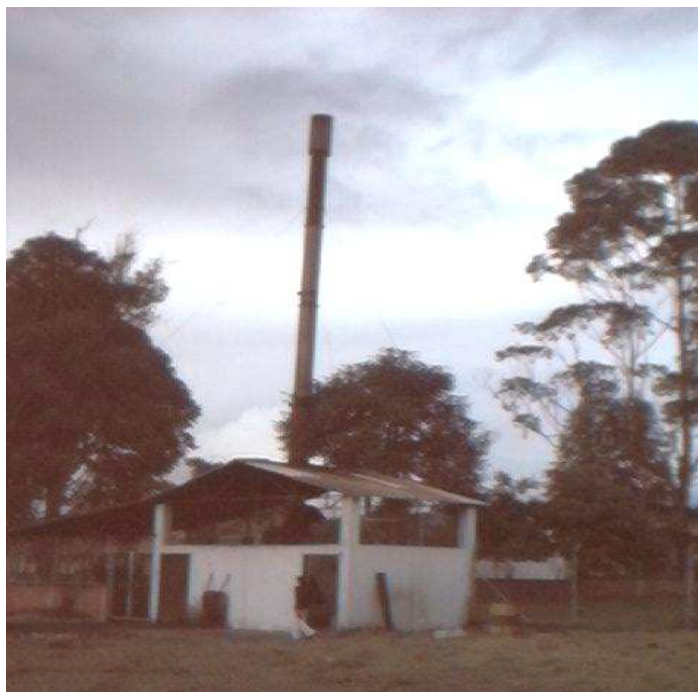
Figura 5. Vista externa de la chimenea del incinerador.
