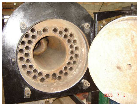
Figura 7. Vista de la tubería interna de la caldera tipo pirotubular
