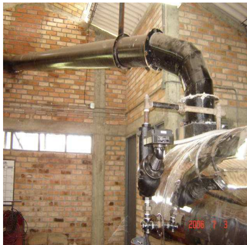
Figura 94. Fotografía de la Chimenea.
