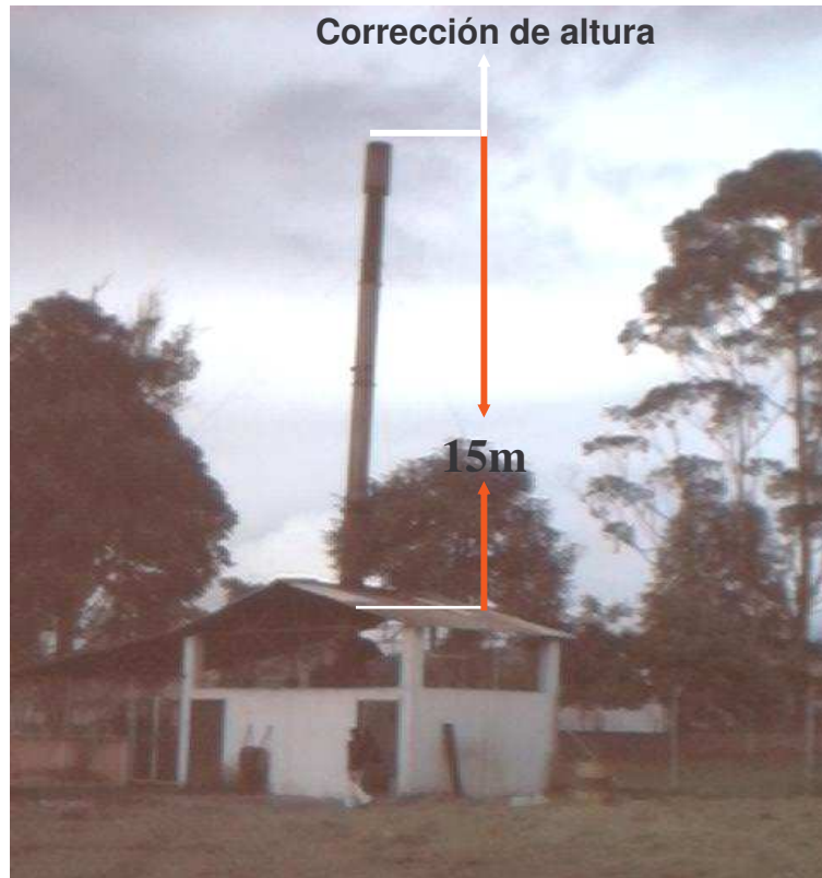
Figura 55. Incremento de la altura chimenea
