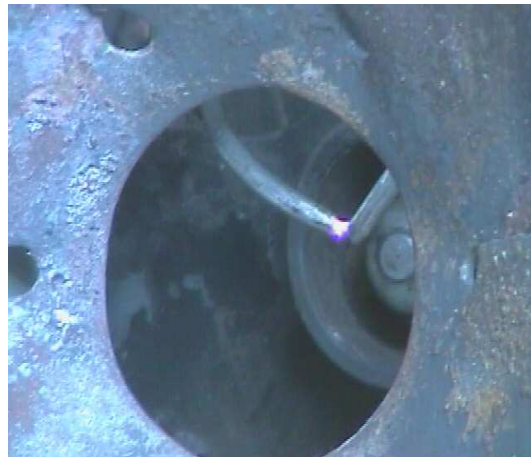
Figura 41. Arco eléctrico en el quemador
