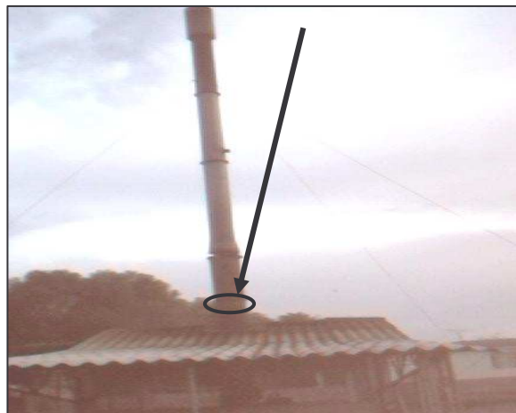
Figura 53. Fugas al final del refractario de la chimenea.
