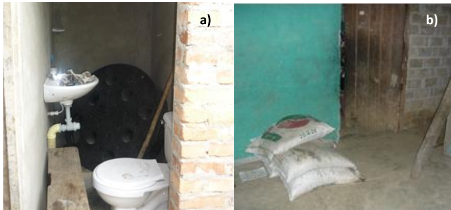
Figura 7. Utilización de diversos sitios como bodega de almacenamiento. a) Baño; b) Pasillo
