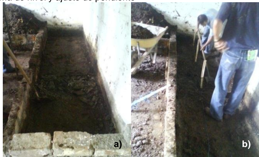
Figura13. Adecuación de la cama de acuerdo al diseño en la IEAP: a) Limpieza de la cama y b) toma de nivel y ajuste de pendiente
