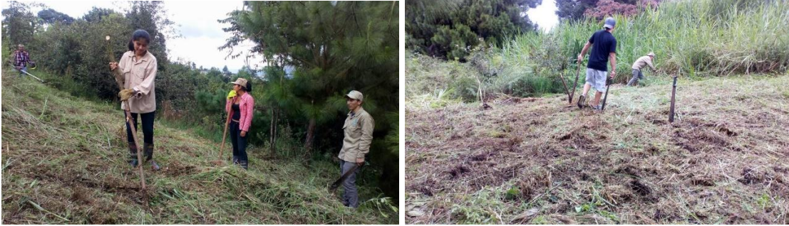
Figura 4. Limpieza del terreno
