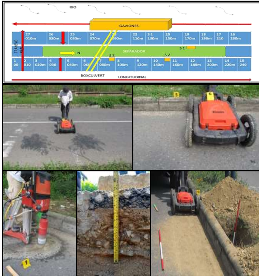
Ilustración 4.17. Intervención inicial en pavimento flexible
