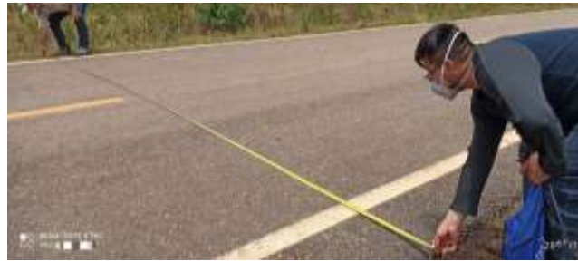
Ilustración 4.3. Chequeo del ancho del pavimento.
