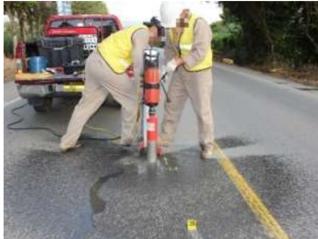
Ilustración 4.13. Extracción de núcleos de pavimento para chequeo de espesor.
