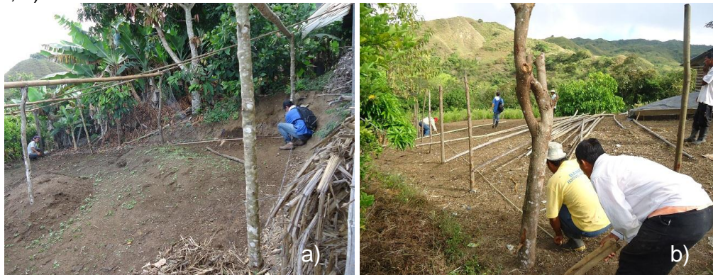
Figura 6. Proceso de escuadro de lote para construcción de vivero de cacao. a) Vereda La Monjita; b) Vereda Potreritos
