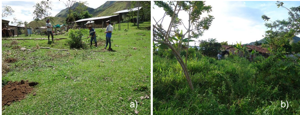
Figura 5. Selección de lote adecuado para realizar la construcción del vivero de cacao. a) Vereda La Monjita; b) Vereda Los Llanos
