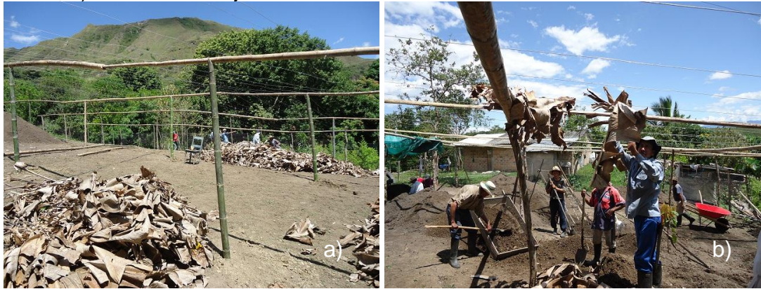
Figura 17. Proceso de Construcción de la estructura del vivero de cacao. a) Vereda Potreritos; b) Vereda La Monjita
