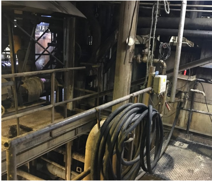
Figura 3.7: PHmetro jugo encalado, área sulfitación Fuente: Elaboración Propia.
