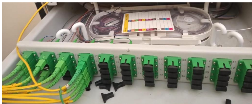
Figura 3.9 Bandeja de organización del ODF
