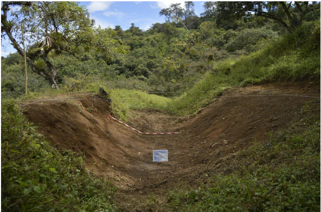
Fotografía 29: Descapote, trinchera 2. Autoría personal.
