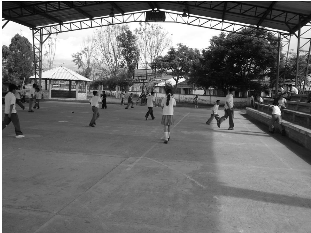
Fotografía N° 2 Cancha Múltiple Cubierta de la Institución
