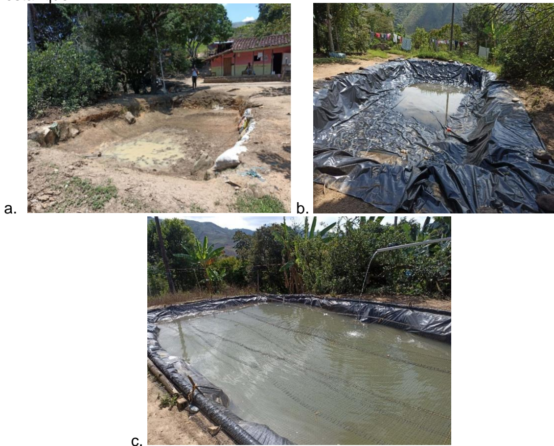
Figura 9. Construcción del estanque. A) excavación b) impermeabilización c) llenado del estanque
