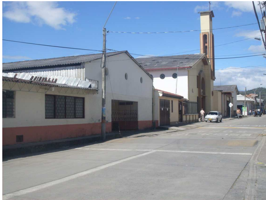
Fotografía # 1. Calle del Barrio San Camilo, junto a La Institucion Tecnico Industrial “Sede San Camilo”
