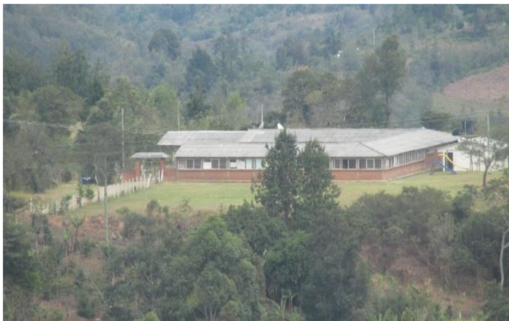
Fotografía 1. Panorámica de la Institución Educativa Palacé
