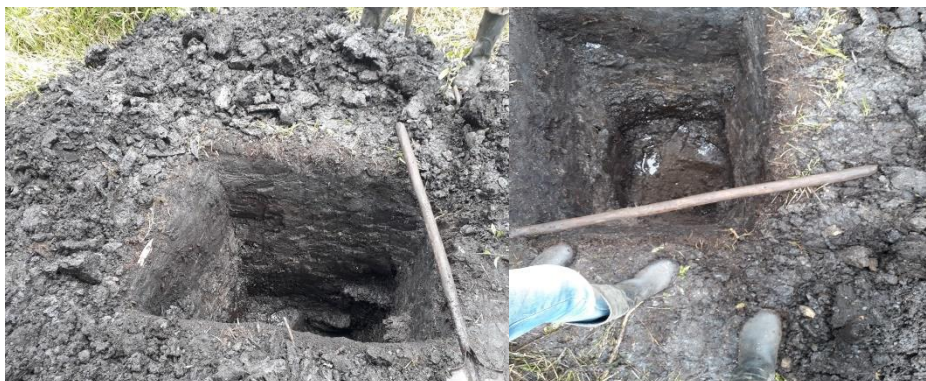
Ilustración 23 Estado Natural mezclas asfálticas
