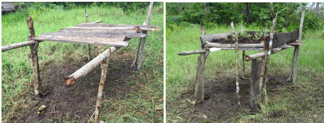
Imagen 44 y 45. Construcción Azotea (Tipo 2). Vereda Chamoncito – Guapi. E. Hernández, 2016.
