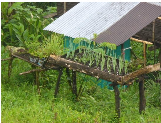
Imagen 33. Azotea Comunidad Eperara. Dpto. del Cauca.
