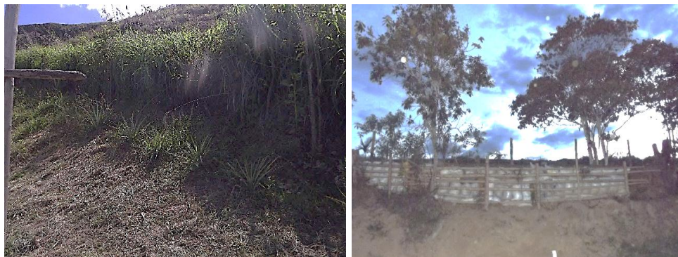
Figura 49. Establecimiento de barreras vivas retenedoras de suelo y trinchos para evitar y controlar erosión
