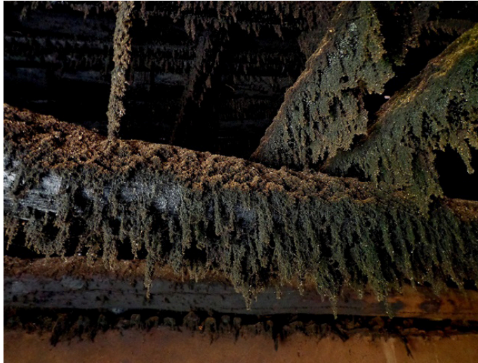
Fig. 27. Hollín impregnado en el techo de la casa. Foto José Manuel Muelas Tombé. 2018.
