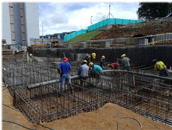
Imagen 26. Vaciado de concreto losa inferior de cimentación N0.0
