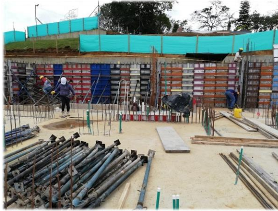
Imagen 30. Encofrado del muro de contención.
