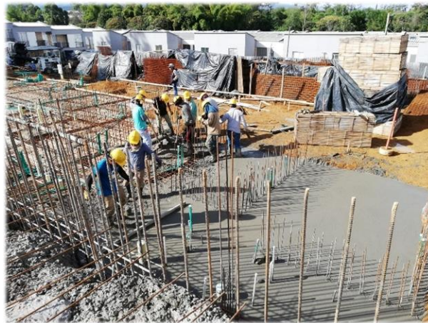
Imagen 28. Vaciado de concreto - finalización cimentación N0.0
