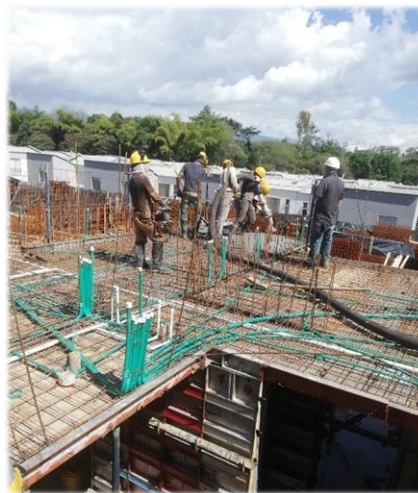
Imagen 36. Vaciado de concreto en apartamento.
