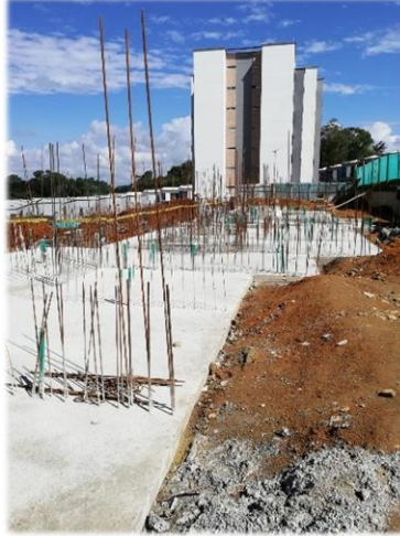
Imagen 29. Losa de cimentación N.2.60 terminada
