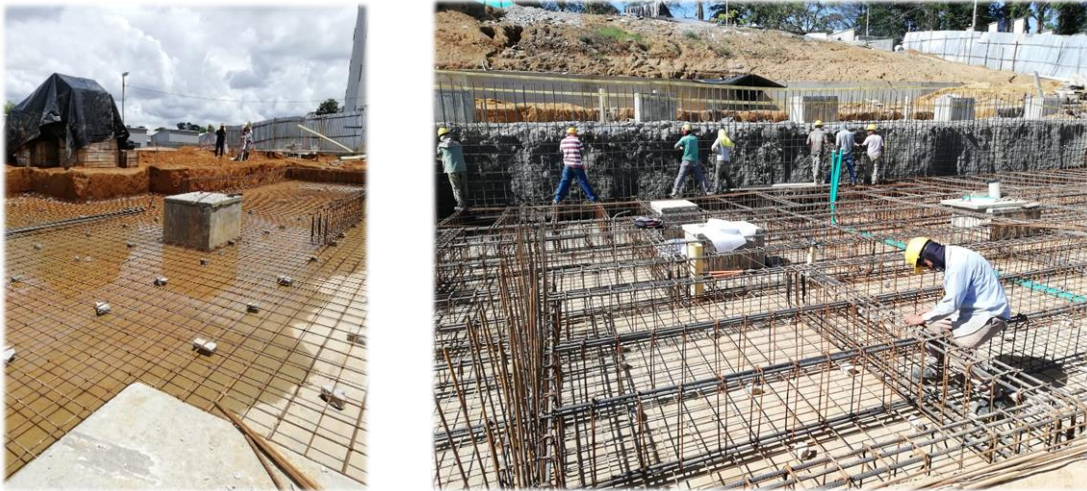
Imagen 24. Armado de la cimentación N 0.0
