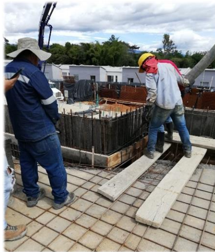
Imagen 31. Vaciado de concreto en muro de contención.
