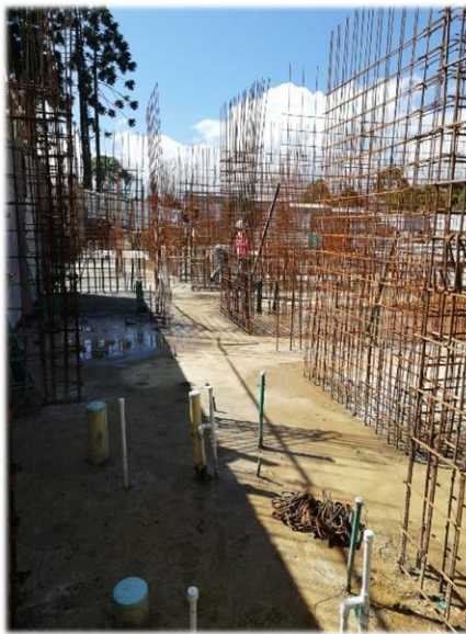
Imagen 33. Acero instalado en muros estructurales.
