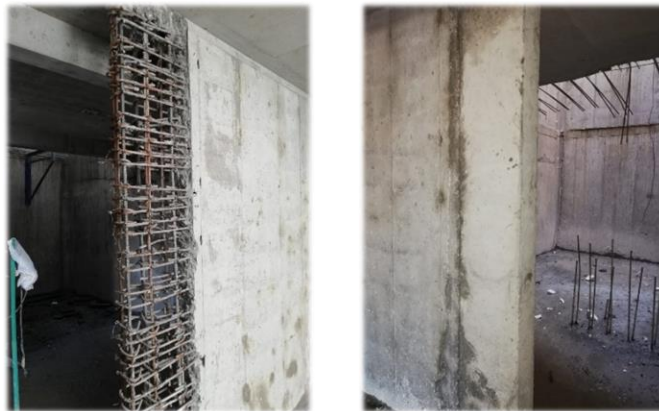
Imagen 38. Reparación elemento de borde.
