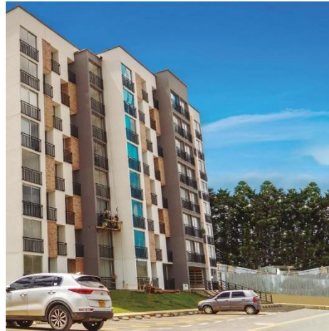
Imagen 5. Fachada torre construida.
