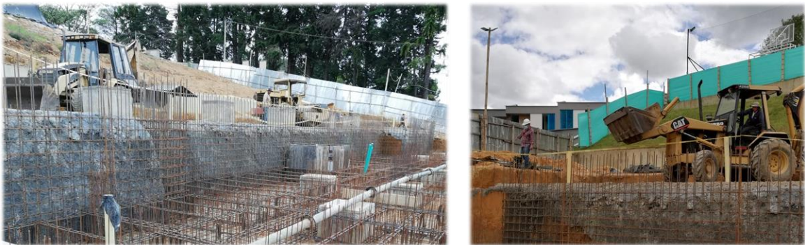
Imagen 25. Mejoramiento del suelo N 2.60
