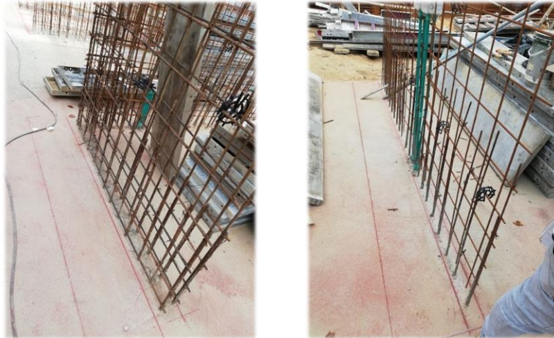
Imagen 32. Cimbra de muros estructurales.
