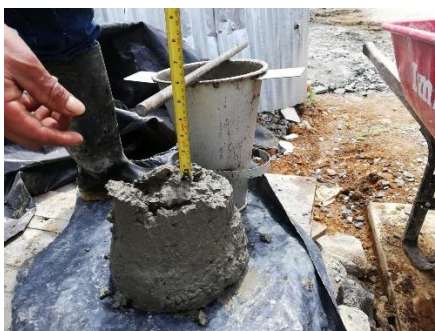
Imagen 39. Ensayo de asentamiento del concreto.
