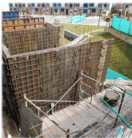
Imagen 34. Instalación de corbatas en formaleta de muro.
