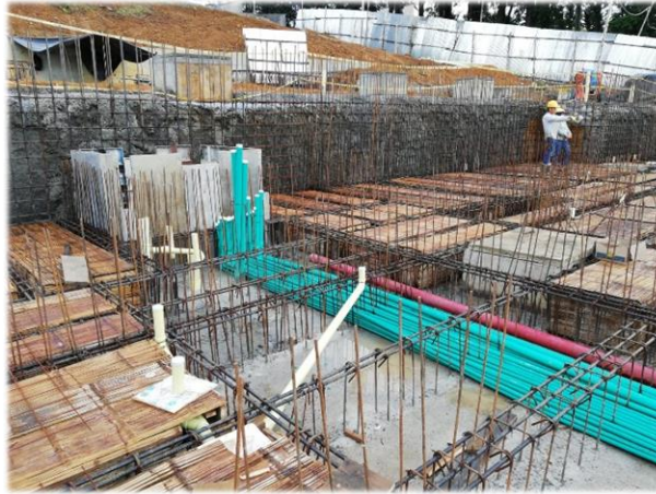
Imagen 27. Instalación de tubería y casetones
