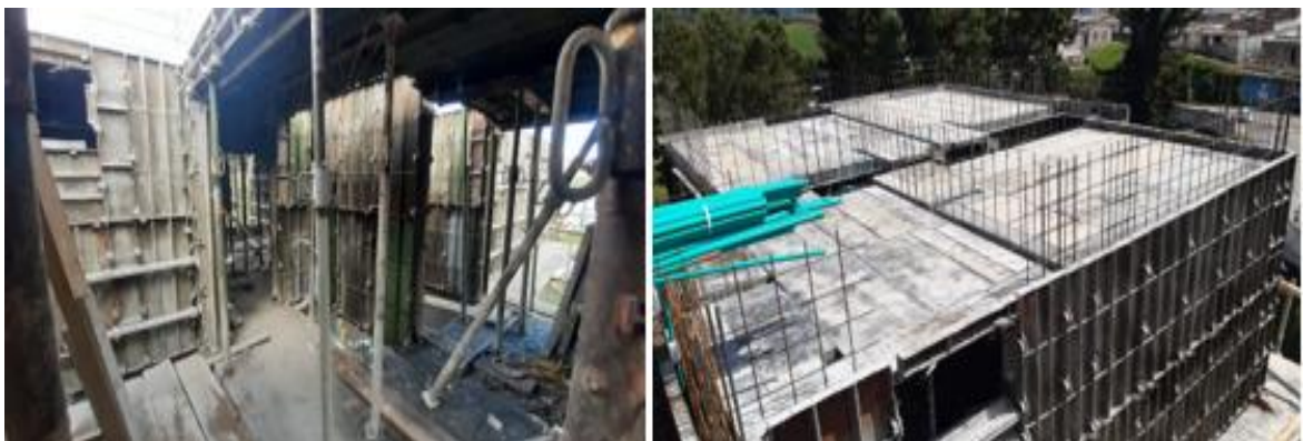
Figura 36. Formaleta Metálica por Fundición.
