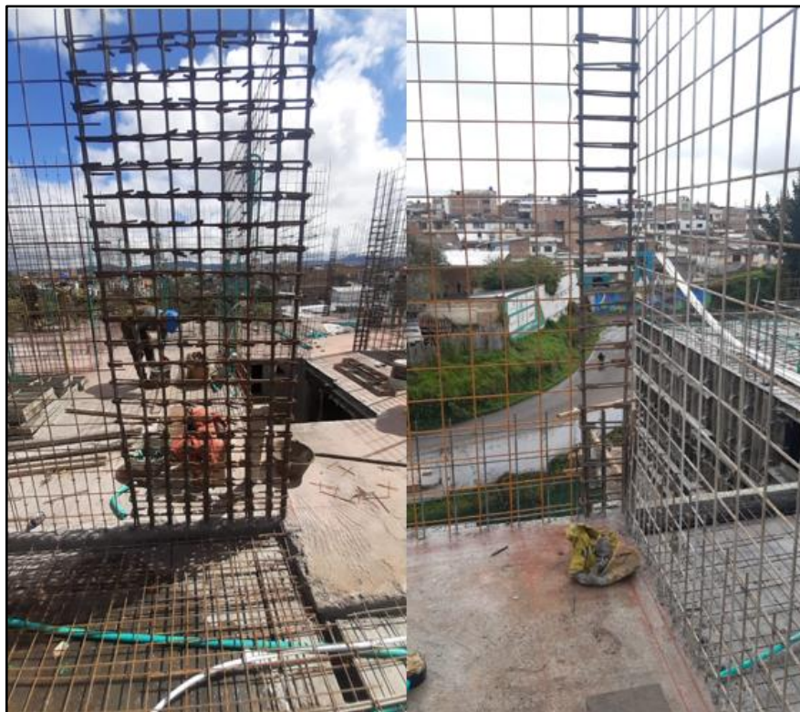
Figura 25. Elemento de Borde Muro 47 y Muro 13
