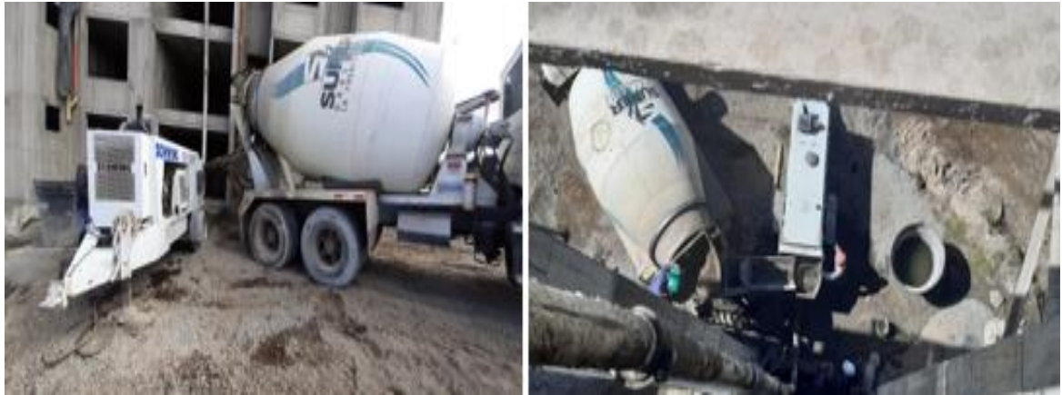
Figura 38. Llegada de Concreto Premezclado.
