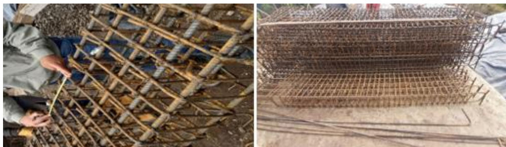
Figura 65. Armado Catillos Columnas
