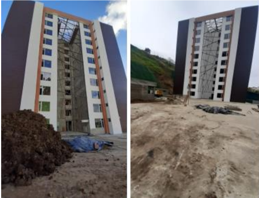
Figura 44. Avance Registrado en Torre 1 (Acabados)
