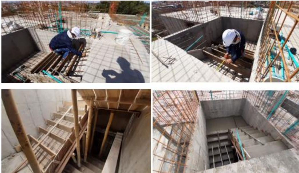
Figura 35. Detalle Armado y Formaleta Gradería.
