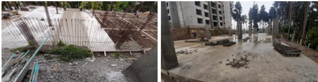
Figura 68. Ultimas Revisiones Sótano
