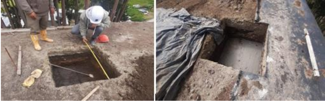
Figura 63. Inicio de Zapatas
