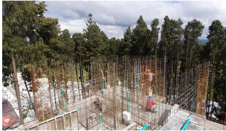
Figura 10. Malla Electrosoldada Muros 0.10m
