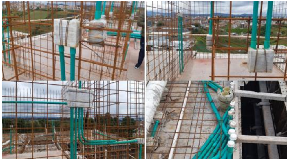
Figura 26. Cajillas y Conductos Muros
