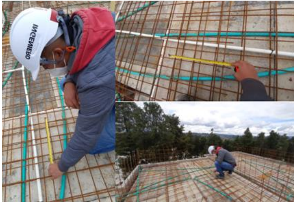
Figura 32. Traslapeo Mallas de Losa
