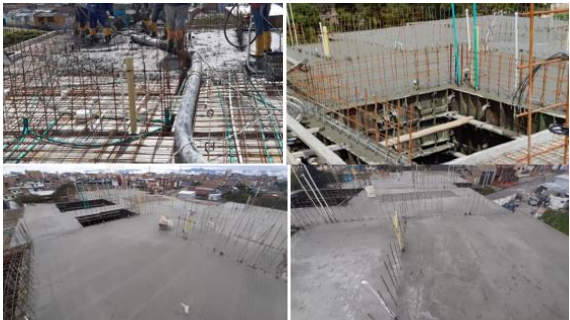
Figura 39. Fundición Losa Y Muros
