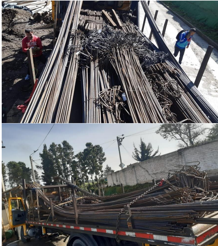
Figura 62. Acero Para Sótano
