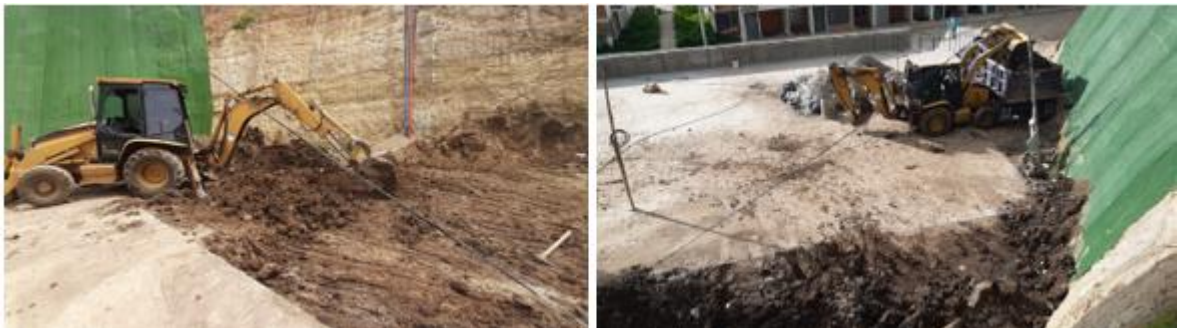
Figura 42. Retroexcavadora Desalojo de Material
