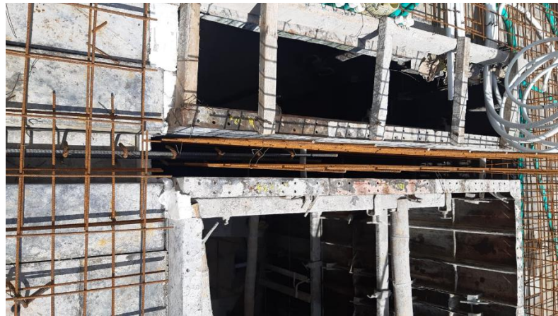
Figura 8. Muro Espesor 0.15m
