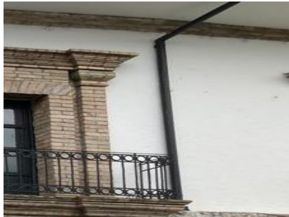
Ilustración 50 Pintura de canales y bajantes - Fuente: propia
