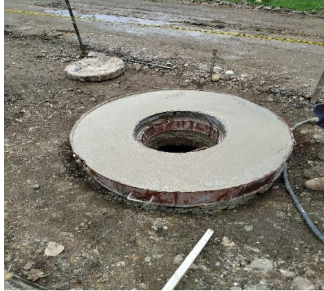
Ilustración 69 Brocal en concreto 28 Mpa - Fuente: propia
