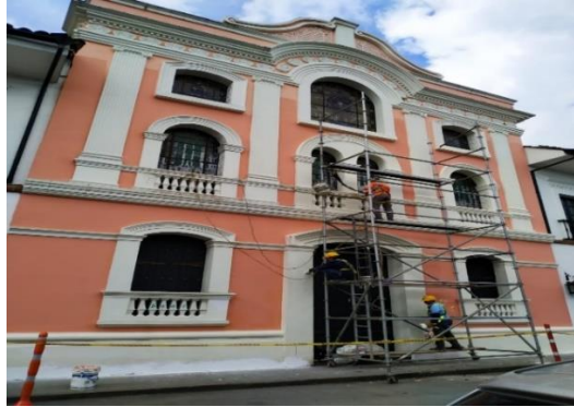
Ilustración 44 Pintura en Koraza - Fuente: propia
