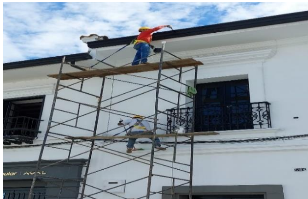
Ilustración 49 Pintura de canales - Fuente: propia
