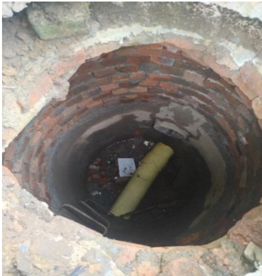
Ilustración 93 Cámara de inspección en ladrillo - Fuente: propia
