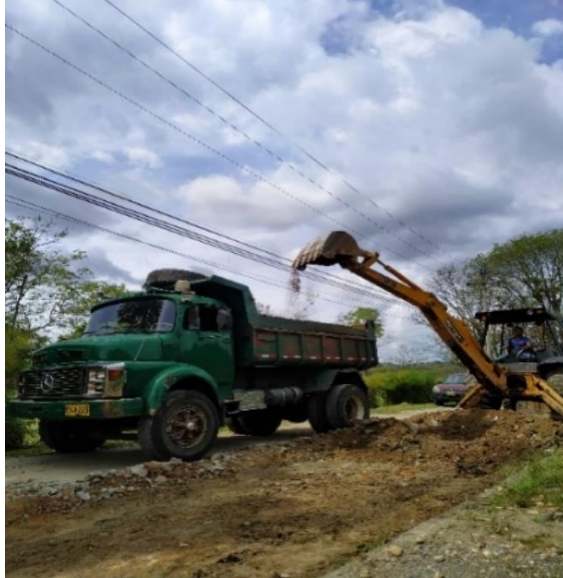
Ilustración 67 Cargue y transporte material - Fuente: propia
