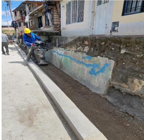
Ilustración 91 Relleno para estructuras con recebo - Fuente: propia
