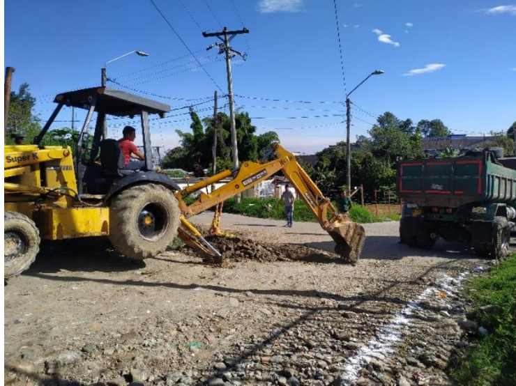
Ilustración 71 Excavación con retroexcavadora - Fuente: propia
