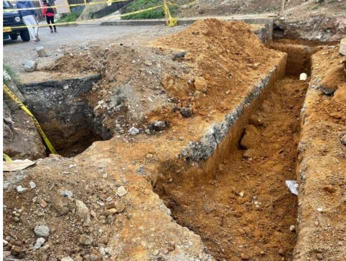
Ilustración 75 Excavaciones varias - Fuente: propia
