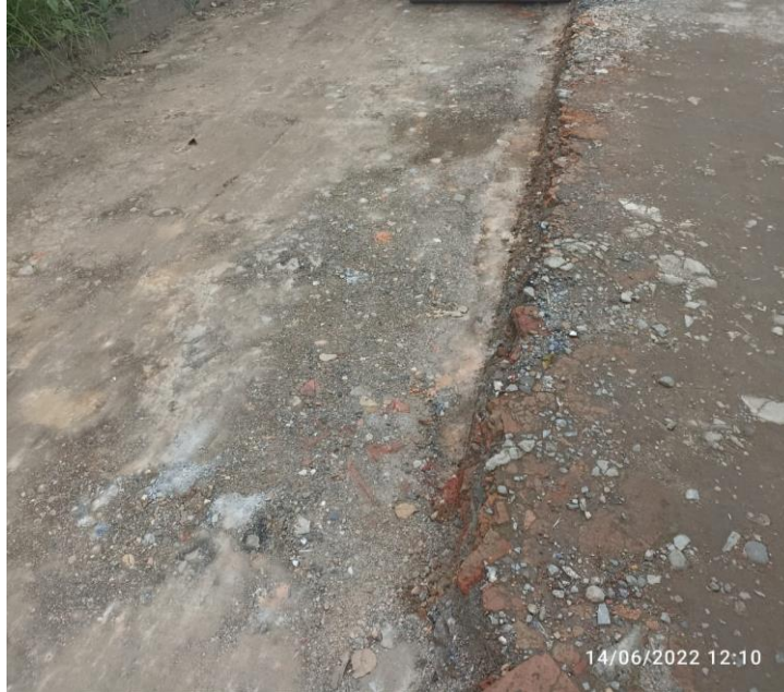
Ilustración 65 Conformación de la calzada existente - Fuente: propia
