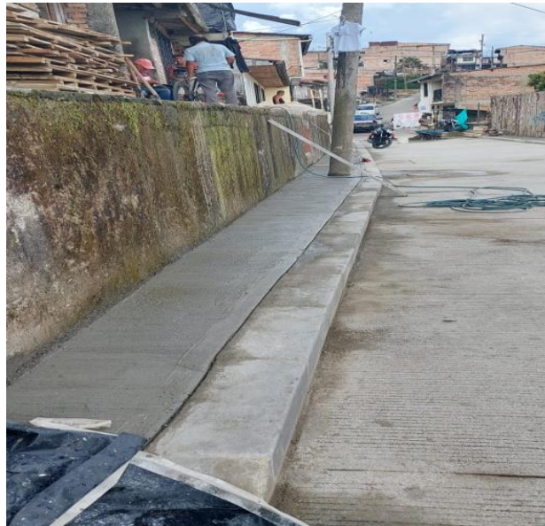
Ilustración 92 Andenes en concreto 21 Mpa - Fuente: propia
