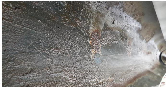
Ilustración 55 Limpieza de canales - Fuente: propia
