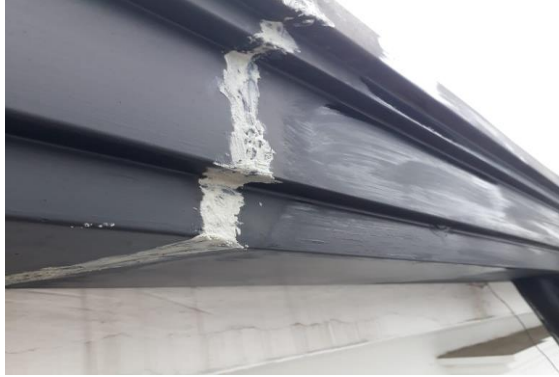
Ilustración 48 Arreglo canales y bajantes - Fuente: propia
