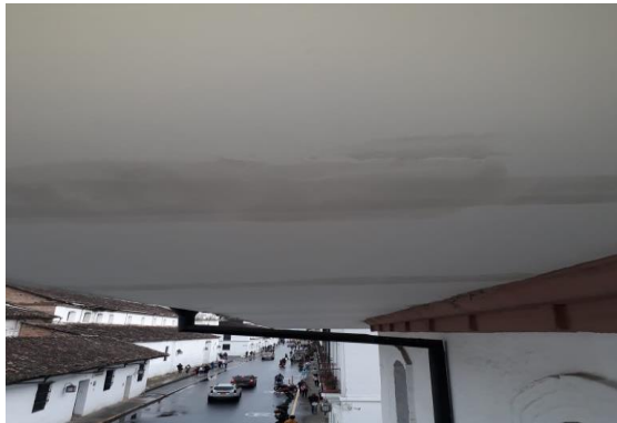
Ilustración 52 Repello malla venada - Fuente: propia
