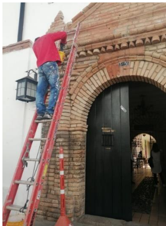
Ilustración 53 Protección acrílica para portales en piedra - Fuente: propia
