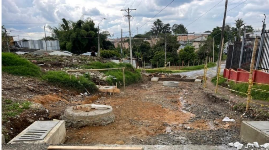
Ilustración 73 Conformación de la calzada existente - Fuente: propia
