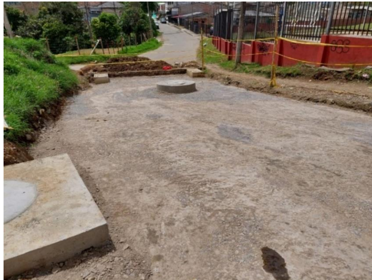
Ilustración 74 Subbase granular clase A - Fuente: propia
