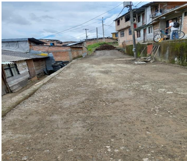
Ilustración 86 Subbase granular - Fuente: propia
