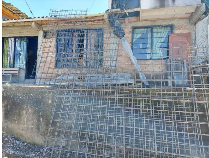
Ilustración 87 Acero de refuerzo fy 420 Mpa - Fuente: propia
