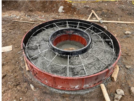
Ilustración 81 Brocal en concreto 28 Mpa - Fuente: propia
