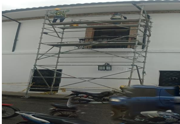
Ilustración 46 Pintura de aleros - Fuente: propia
