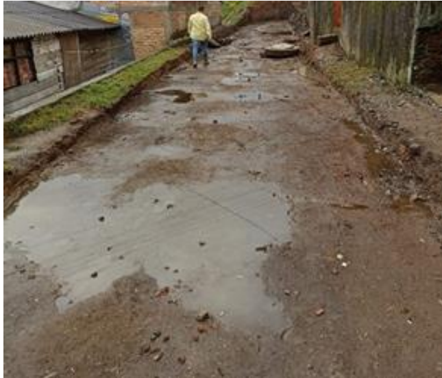
Ilustración 83 Excavación - Fuente: propia
