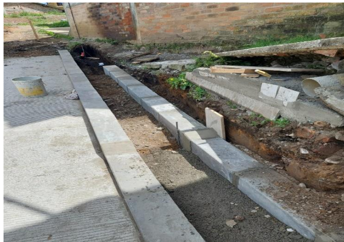
Ilustración 90 Bordillo de piezas prefabricadas - Fuente: propia
