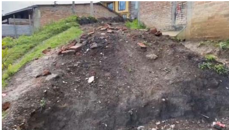
Ilustración 84 Zona de disposición de sobrantes - Fuente: propia
