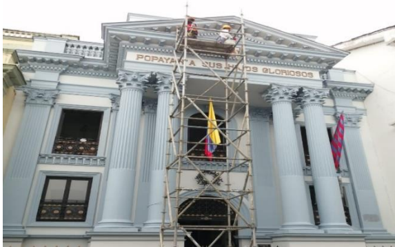
Ilustración 45 Pintura en Koraza - Fuente: propia
