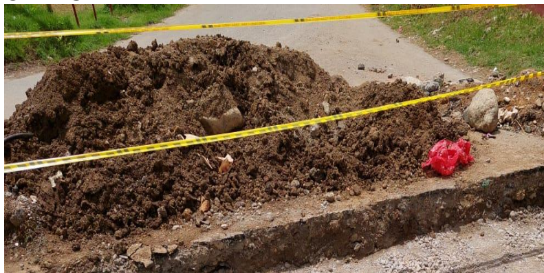
Ilustración 72 Zona de disposición de sobrantes - Fuente: propia
