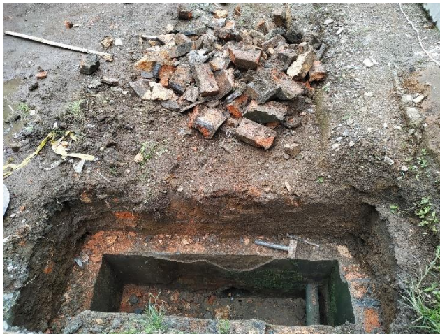
Ilustración 94 Sumidero en ladrillo - Fuente: propia
