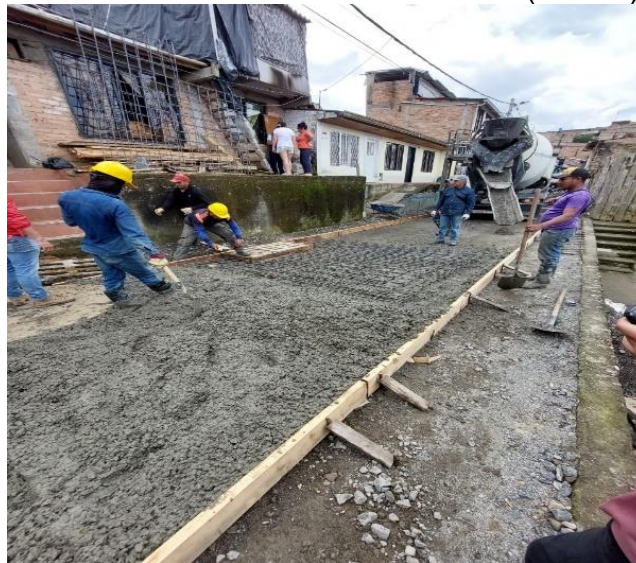
Ilustración 88 Pavimento de concreto hidráulico - Fuente: propia
