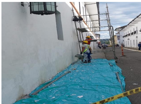
Ilustración 43 Rasqueteo de muros - Fuente: propia
