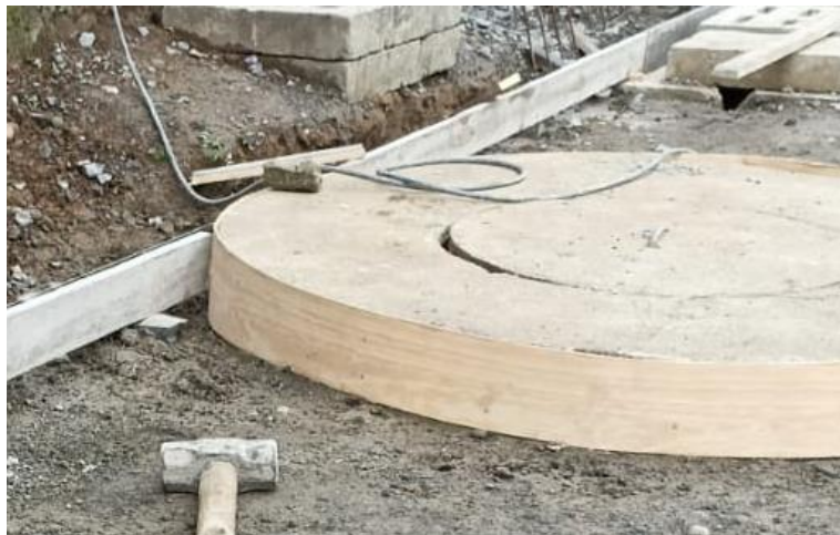
Ilustración 96 Brocal cámara de inspección - Fuente: propia
