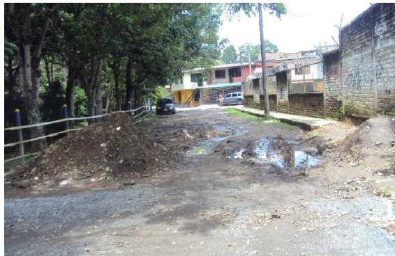
Ilustración 26 Barrio Santa Helena - Fuente: SECOP II
