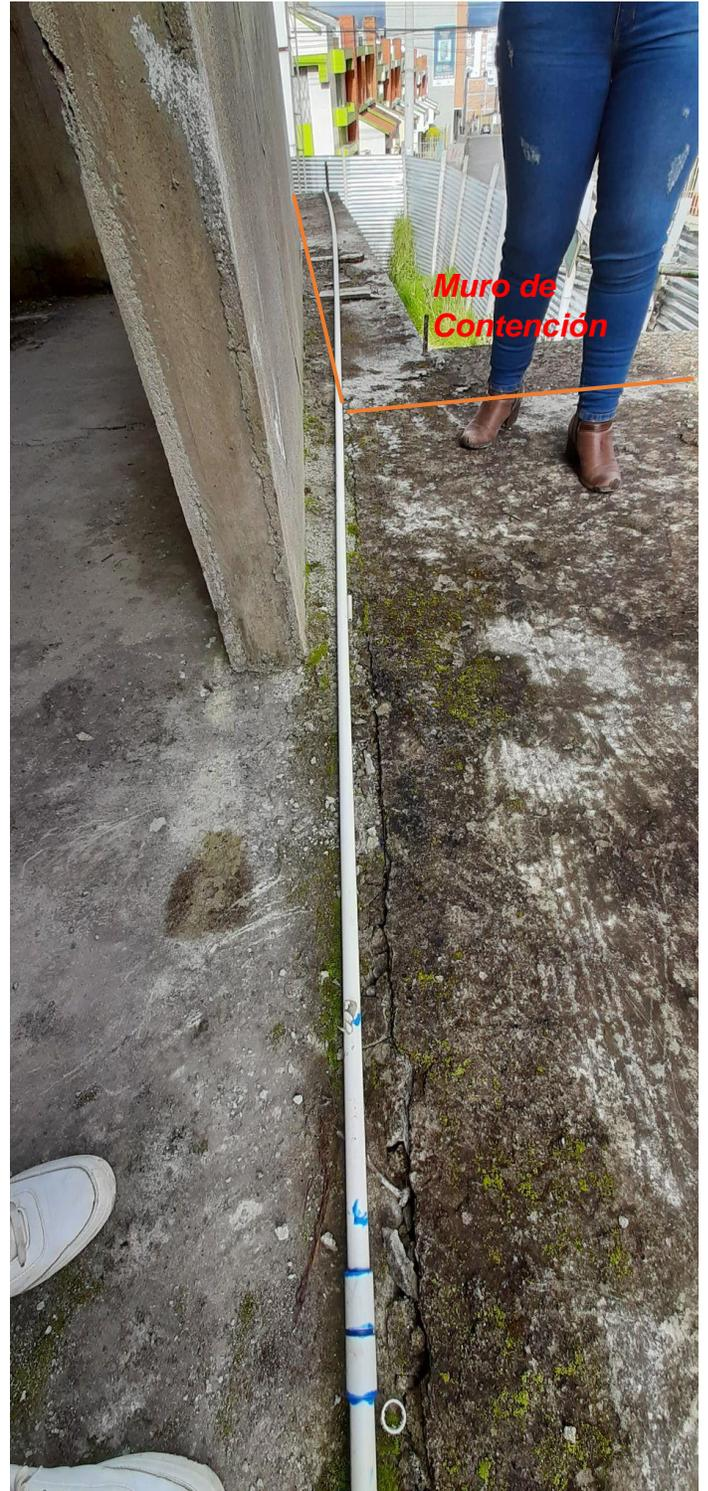
FOTO 8 FISURAS EN LOS MUROS Y LA LOSA DE PISO
