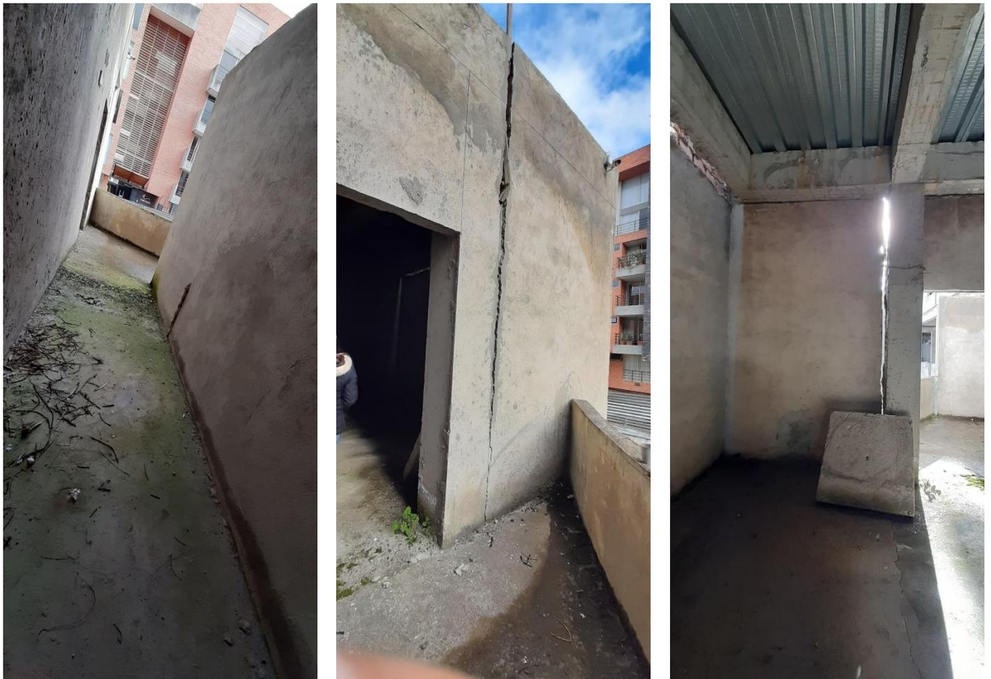
**FOTO 5 MUROS EN AUDITORIO CON UNA ROTACIÓN EXCESIVA**
