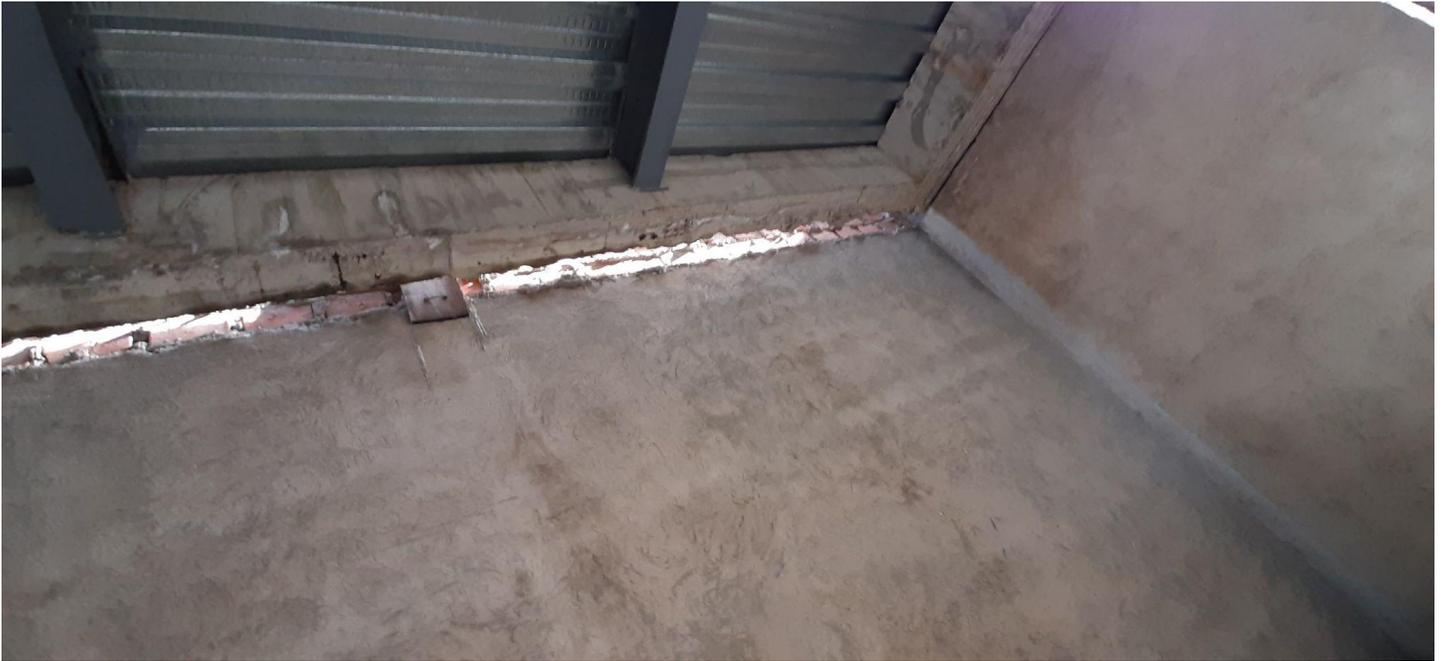
FOTO 6 EN ESTE MURO PUEDE VERSE QUE NO HAY INTEGRIDAD CON LA ESTRUCTURA
