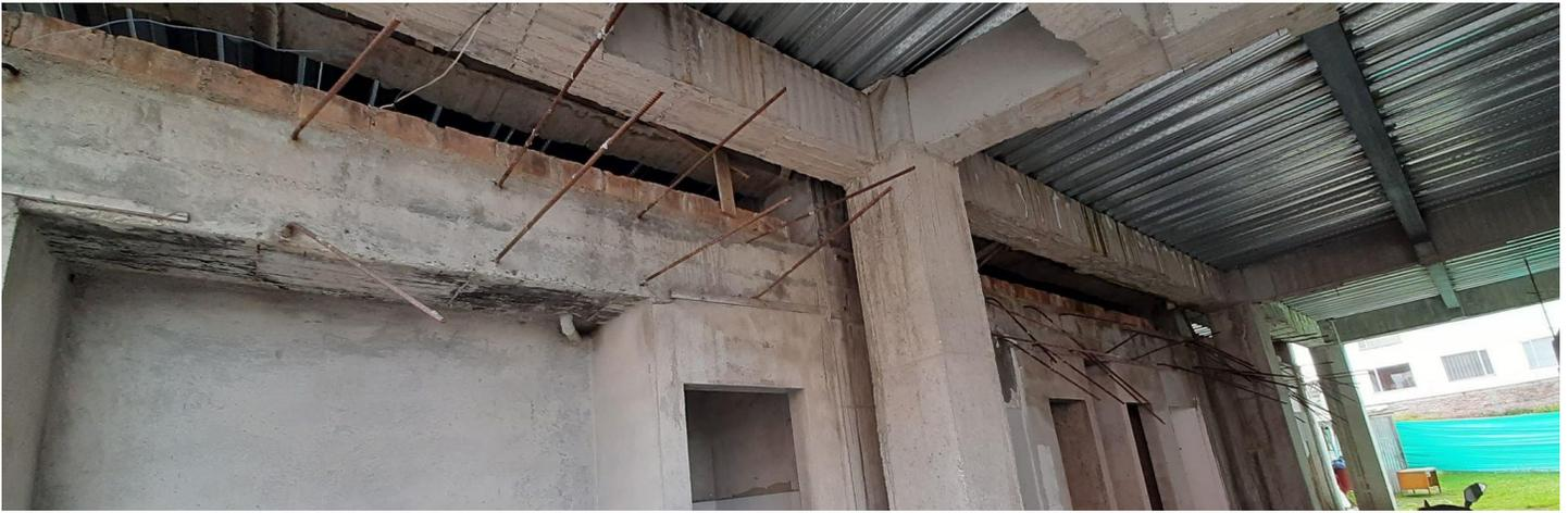
**FOTO 2 SE PUEDE EVIDENCIAR QUE LA VIGA QUE AMARRA EL MURO ES OTRA QUE LA QUE SOPORTA LA LOSA**
