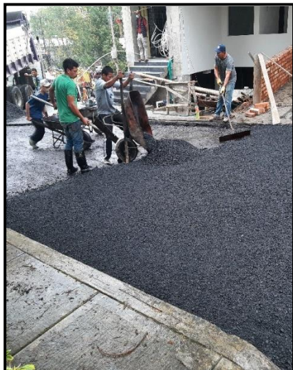
Imagen 85 Colocación de mezcla asfáltica con buggy
