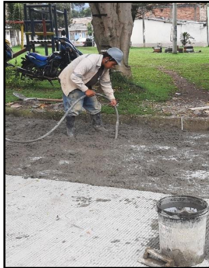
Imagen 52 Vibrado segundo carril
