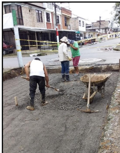
Imagen 11 Arreglo y tratamiento de subbase
