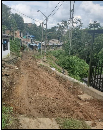
Imagen 56 Proceso de excavación completado
