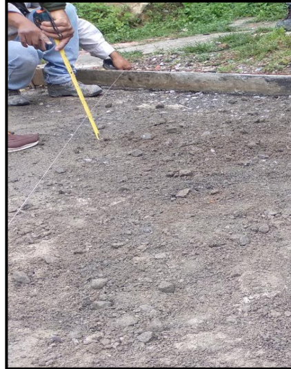
Imagen 67 Verificación de niveles en formaleta
