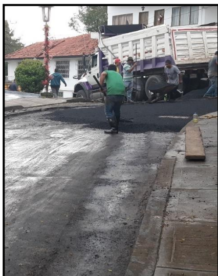
Imagen 87 Distribución de material área 2 y 3
