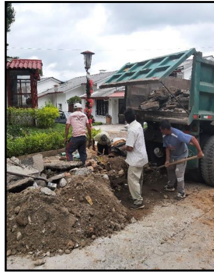
Imagen 97 Recogida de escombros.
