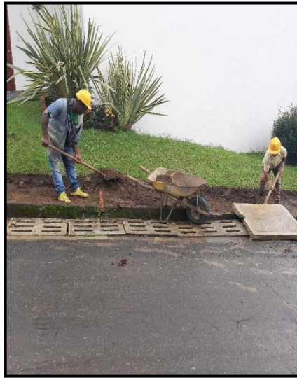
Imagen 96 Excavación manual utilizando pala
