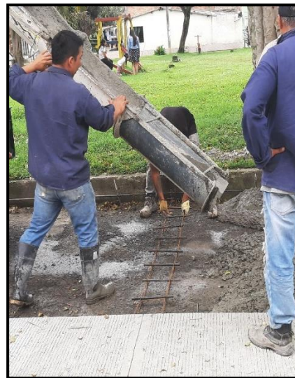
Imagen 48 Disposición de canastillas
