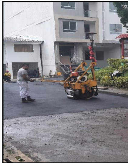
Imagen 90 Compactación mezcla asfáltica área 2 y 3
