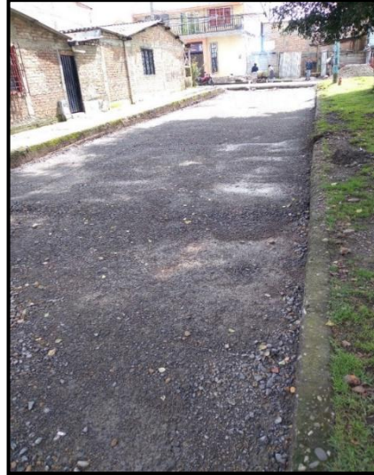
Imagen 37 Disposición del material de subbase
