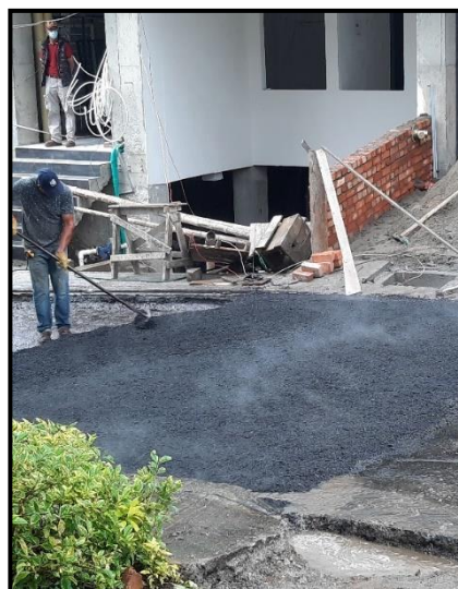
Imagen 83 Distribución de material de mezcla asfáltica
