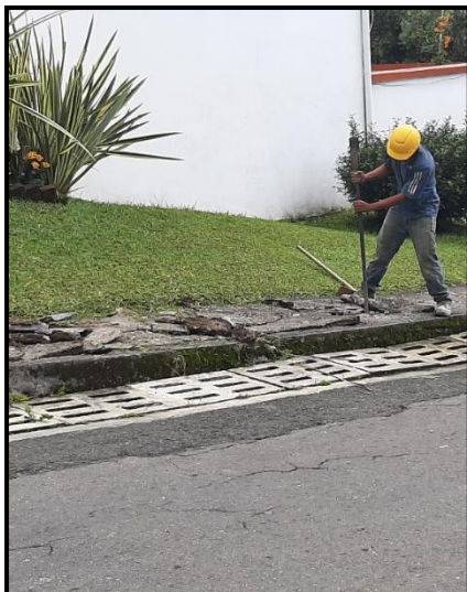
Imagen 94 Utilización de barra para descapote
