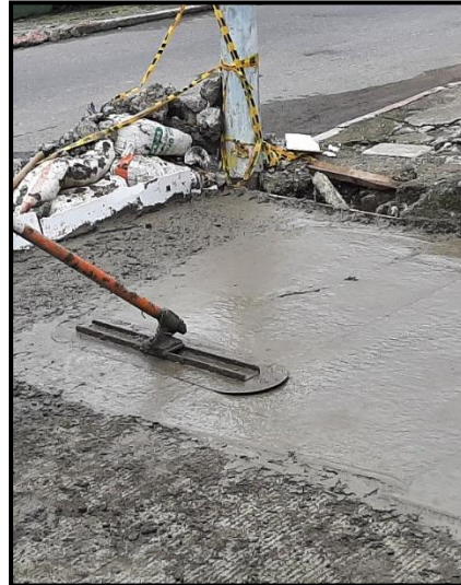
Imagen 28 Floteado de la losa
