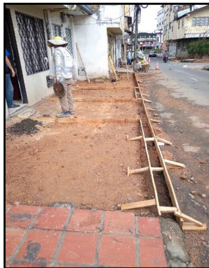
Imagen 103 Instalación de formaleta. Barrio Belalcázar
