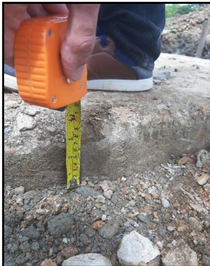
Imagen 73 Cumplimiento medida con espesor de placa
