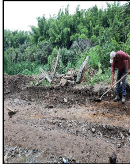
Imagen 57 Perfilación y adecuación subrasante
