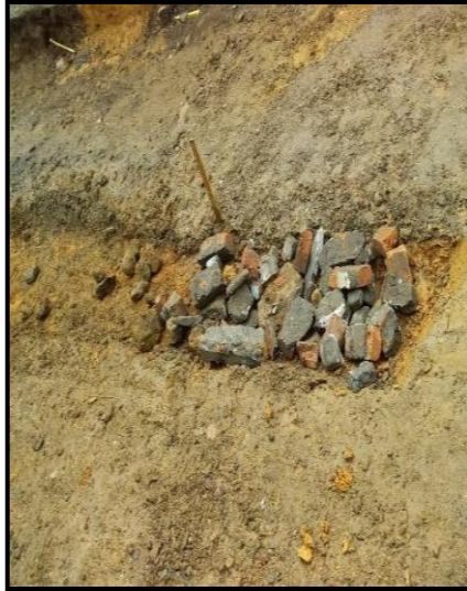
Imagen 8 Colocación de material para mejora de subrasante
