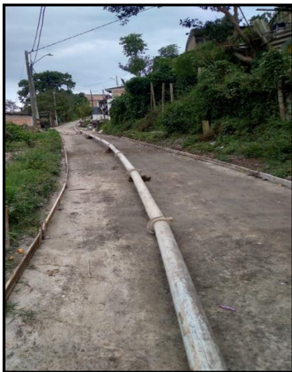
Imagen 75 Tubería metálica para fundición
