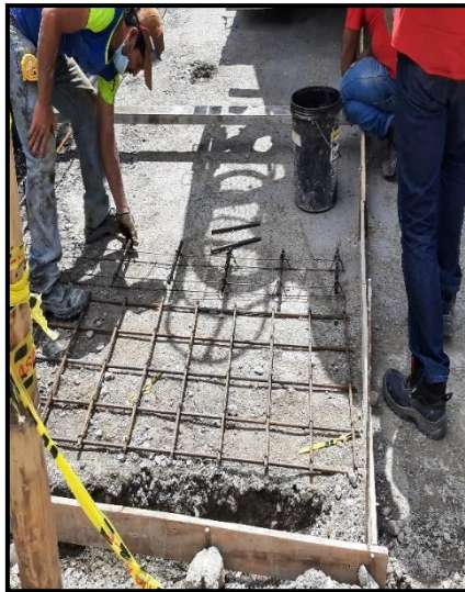
Imagen 21 Colocación de canastillas y dovelas
