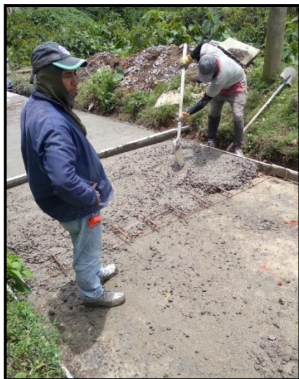
Imagen 79 Instalación de canastillas y dovelas
