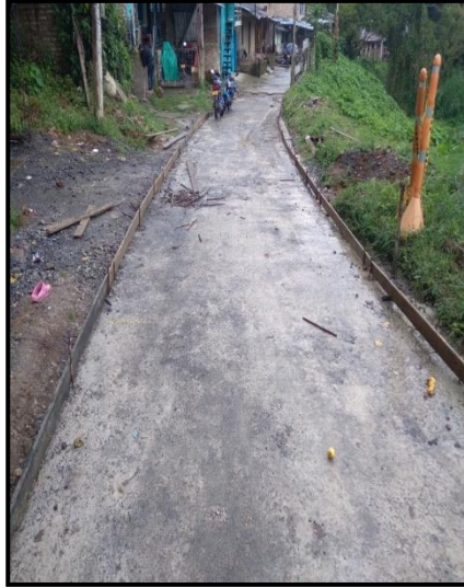
Imagen 66 Colocación de formaleta
