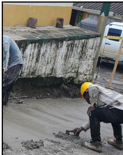
Imagen 29 Terminado de la losa
