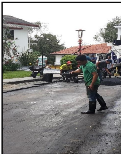
Imagen 84 Aplicación del riego de imprimación
