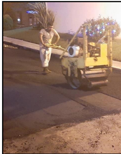
Imagen 91 Compactación mezcla asfáltica área 4
