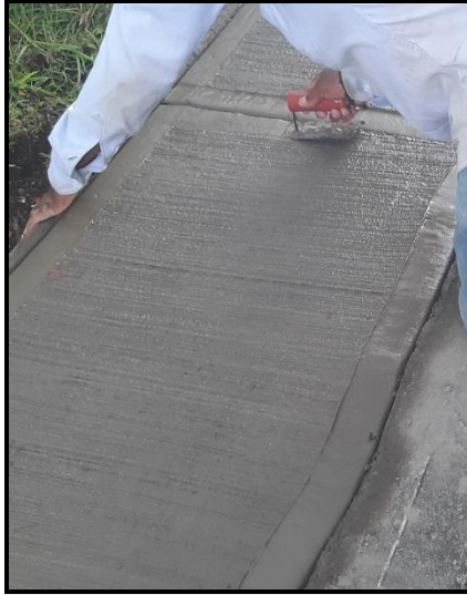
Imagen 112 Realización de juntas
