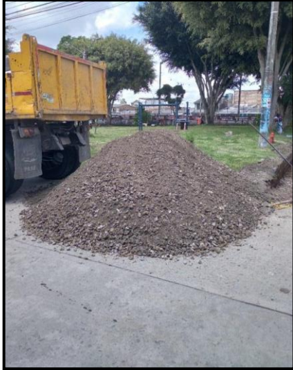
Imagen 36 Descarga de material subbase
