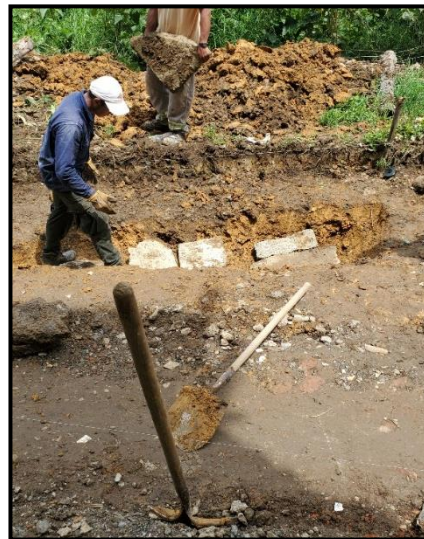
Imagen 59 Placas de concreto para estabilización
