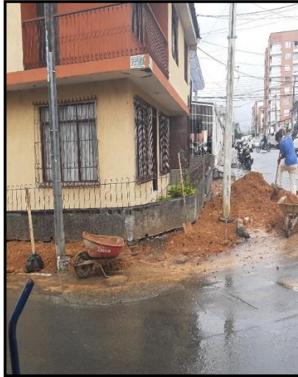
Imagen 98 Adequación de material roca muerta. Barrio Belalcázar
