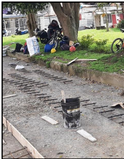
Imagen 47 Canastillas y dovelas
