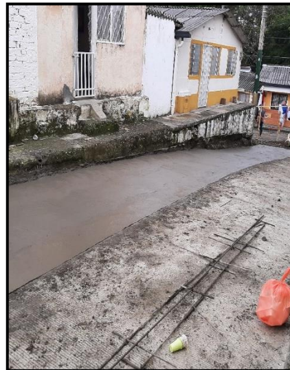
Imagen 26 Terminado segundo carril
