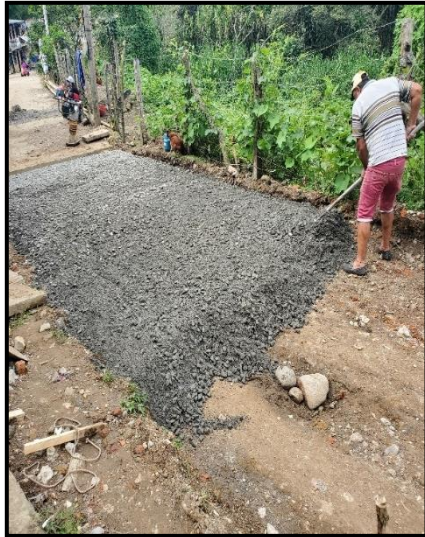
Imagen 62 Adecuación del material de subbase
