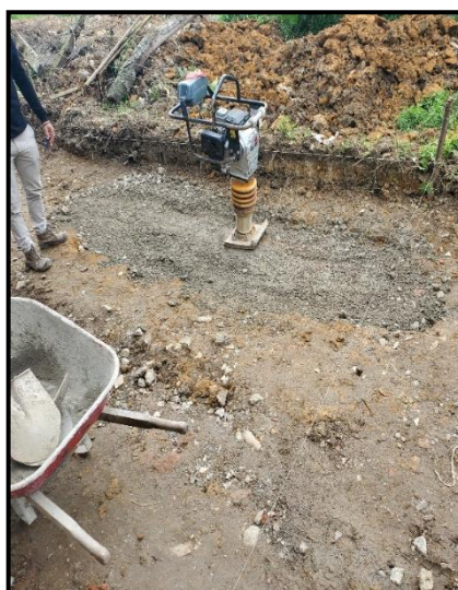
Imagen 61 Compactación de material estabilizante
