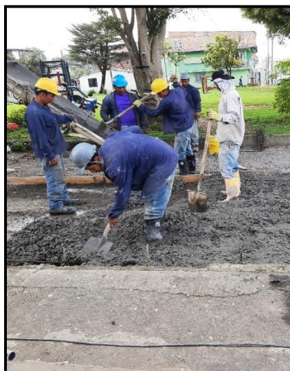
Imagen 49 Fundición primer carril
