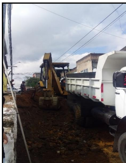
Imagen 5 Retiro de escombros
