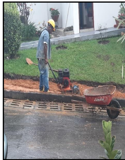
Imagen 101 Compactación de roca muerta. Urbanización Loma Linda
