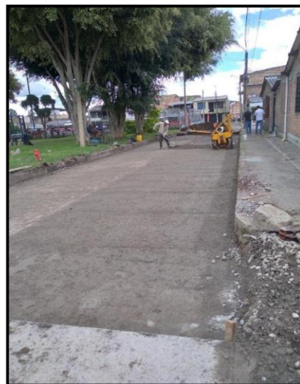
Imagen 39 Arreglos de la subbase
