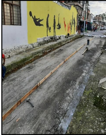
Imagen 14 Instalación de formaleta
