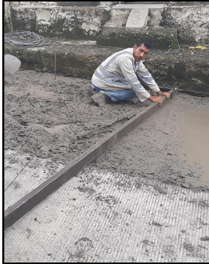
Imagen 27 Utilización de codal para terminado
