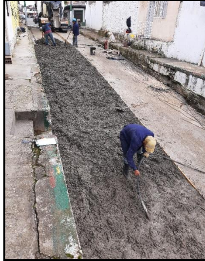
Imagen 24 Vibrado del concreto
