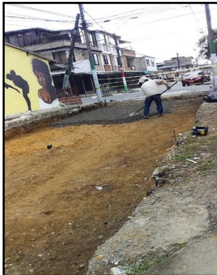
Imagen 10 Disposición material de subbase
