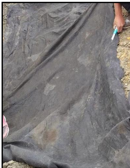
Imagen 7 Geotextil de protección
