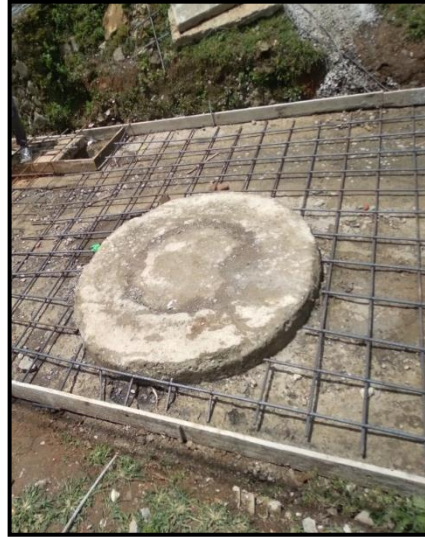
Imagen 70 Rejilla de refuerzo - recámara
