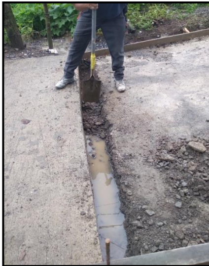
Imagen 68 Excavación de viga de refuerzo
