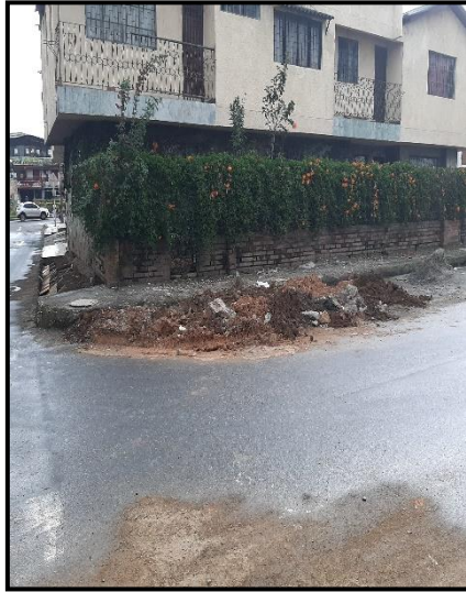
Imagen 92 Demolición y excavación de material ya existente. Barrio Belalcázar
