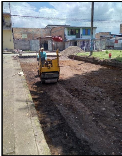
Imagen 34 Perfilación y nivelación de la subrasante
