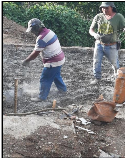
Imagen 64 Esparcimiento de cemento en subbase
