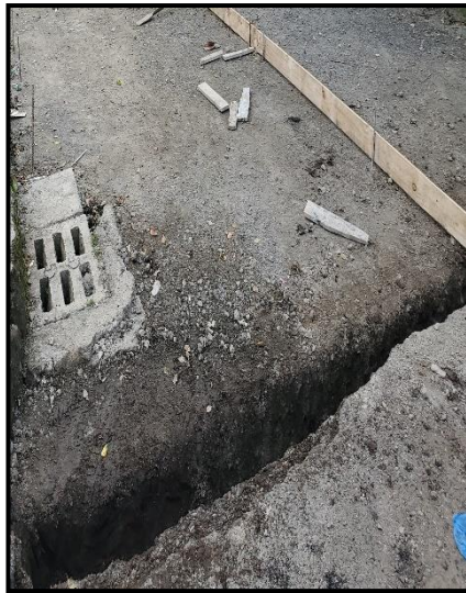
Imagen 42 Viga hacia la calle 62AN
