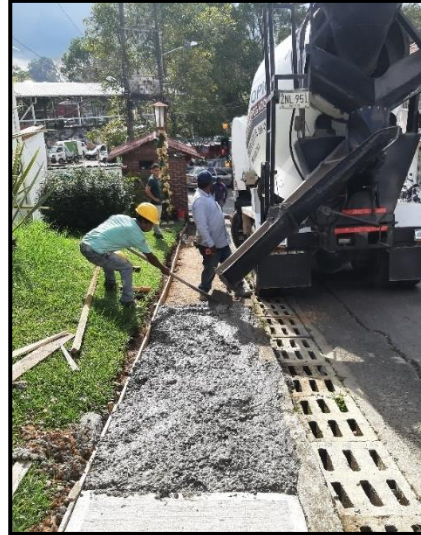
Imagen 105 Proceso de fundición. Urbanización Loma Linda
