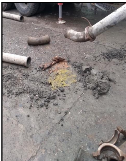
Imagen 77 Taponamiento de la tubería
