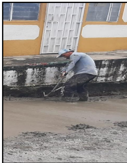
Imagen 18 Retiro de cimbra
