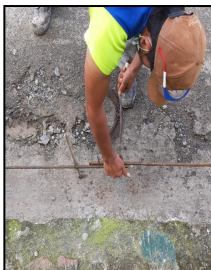
Imagen 17 Proceso de amarre de cimbra
