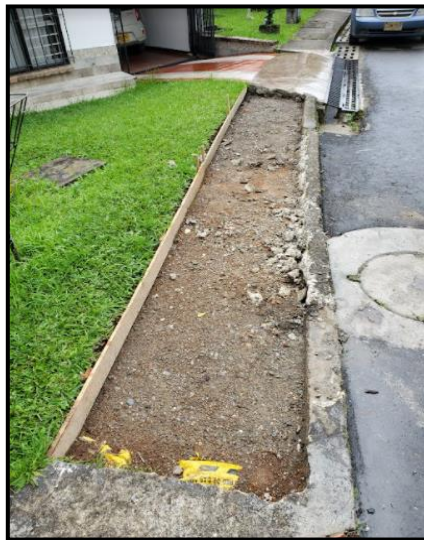
Imagen 102 Instalación de formaleta. Urbanización Loma Linda
