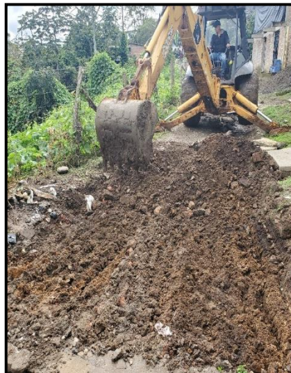
Imagen 54 Excavación de la explanación con retroexcavadora
