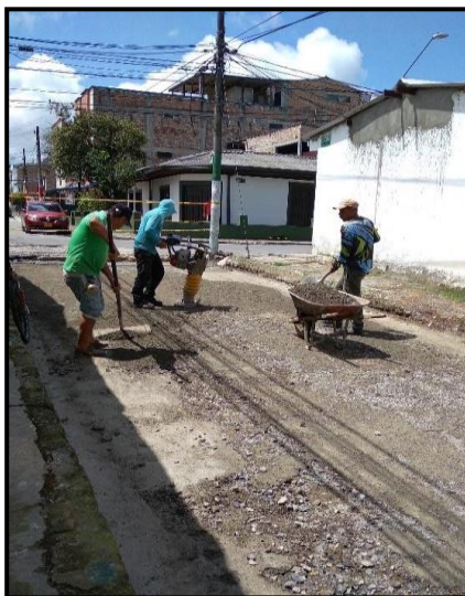
Imagen 12 Compactación de subbase con saltarín
