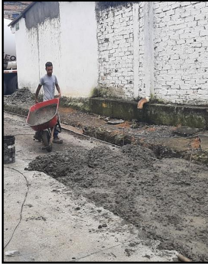
Imagen 23 Fundición segundo carril por medio de buggy
