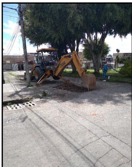
Imagen 32 Excavación de la explanación
