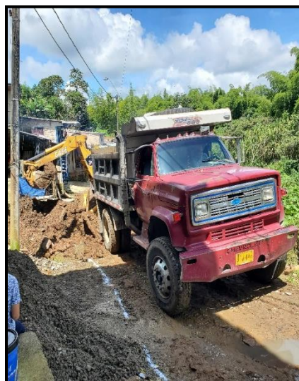
Imagen 55 Carga y retiro de escombros
