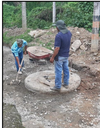
Imagen 74 Nivelación para dar cumplimiento a las medidas indicadas
