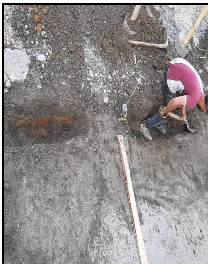
Imagen 19 Excavación de vigas
