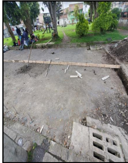
Imagen 41 Nivelación de la subbase para cumplimiento de altura de formaleta
