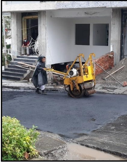
Imagen 89 Compactación mezcla asfáltica área 1
