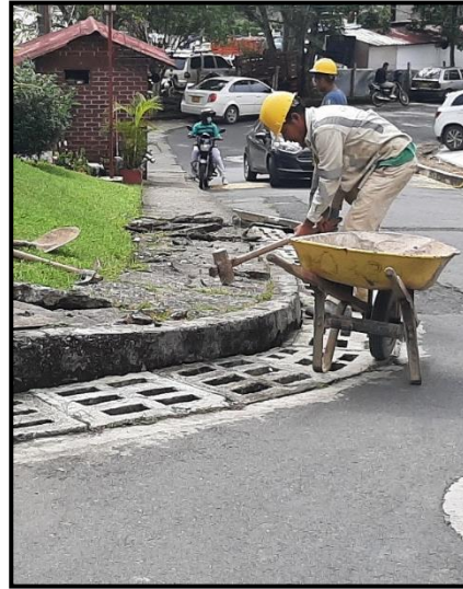
Imagen 93 Demolición de anden con martillo
