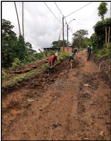
Imagen 58 Excavación de fallos en subrasante
