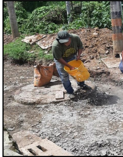
Imagen 63 Riego de agua en subbase
