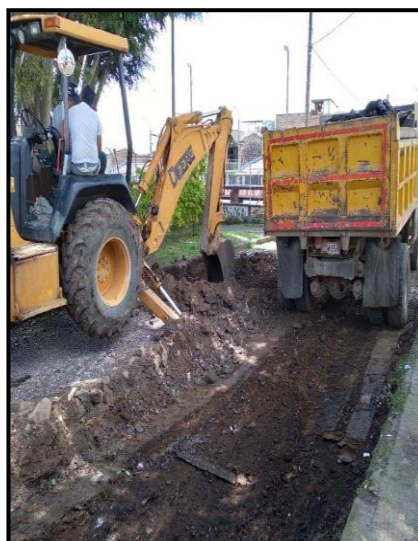
Imagen 33 Cargue de escombros
