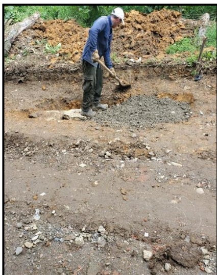
Imagen 60 Colocación de material estabilizante
