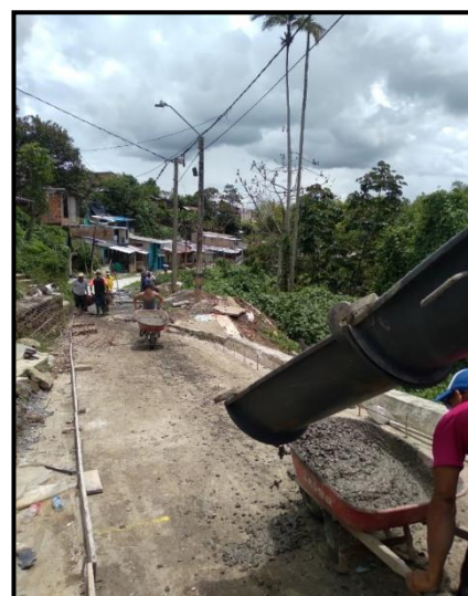
Imagen 78 Fundición con ayuda de buggy
