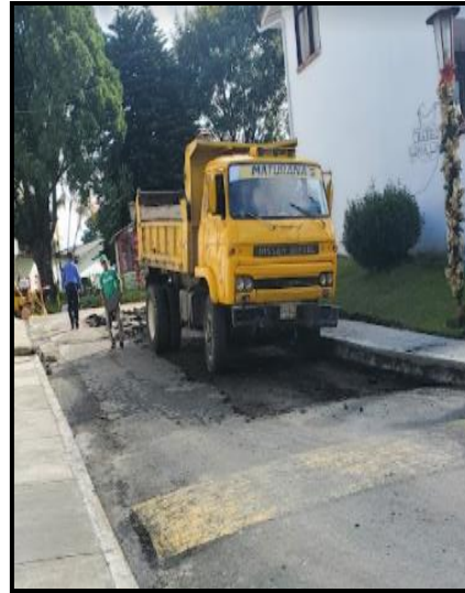
Imagen 82 Cargue de material excavado
