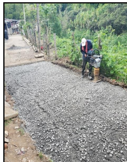
Imagen 65 Compactación de subbase
