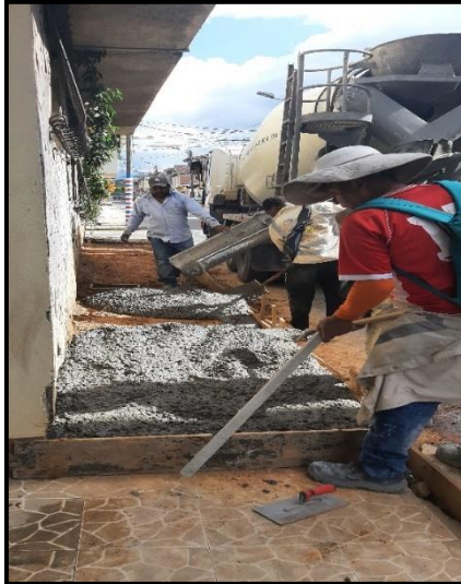
Imagen 104 Proceso de fundición. Barrio Belalcázar
