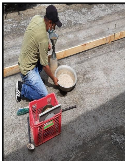
Imagen 13 Ensayo cono de arena
