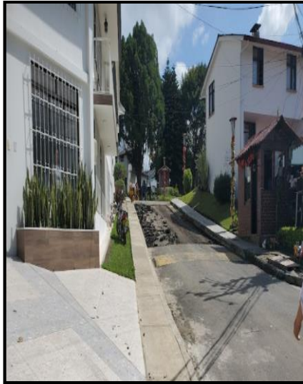
Imagen 81 Demolición de la carpeta asfáltica
