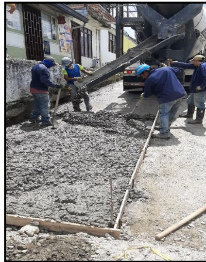
Imagen 22 Fundición primer carril con mixer
