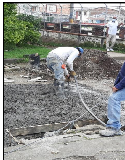
Imagen 50 Vibrado primer carril
