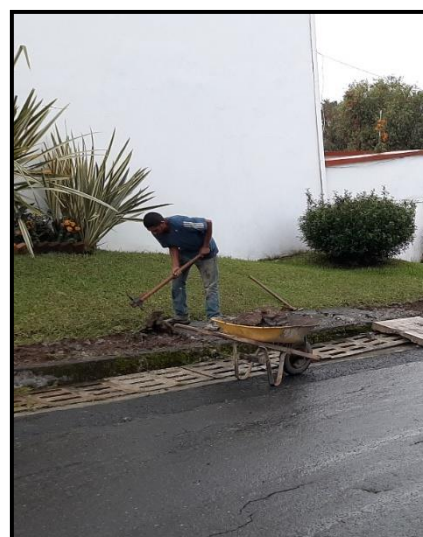
Imagen 95 Utilización de la pica
