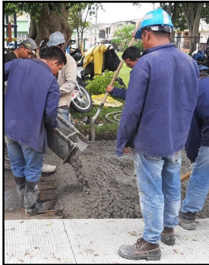
Imagen 51 Fundición segundo carril
