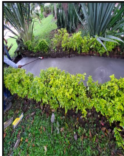
Imagen 110 Detalle de sendero. Urbanización Loma Linda
