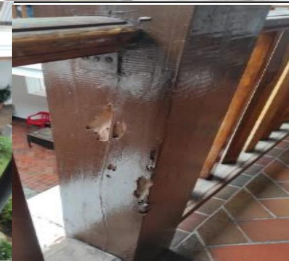
De igual manera los elemetos tipo vigas y columnas en material madera se encuentran afectados por insectos y plagas que afectan el funcionamiento de los mismos
