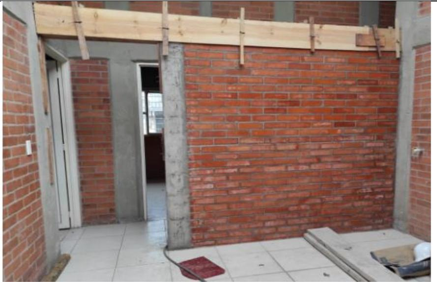
*Figura 22. Construcción de muro divisorio con elementos de confinamiento*
