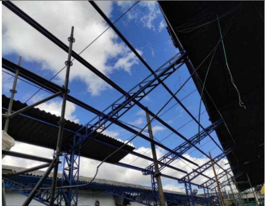
*Figura 13. Instalación de tejas de fibrocemento sobre estructura metálica*
