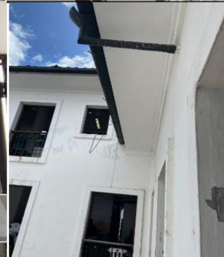
Se evidencia gran humedad en el muro de la oficina de la secretaria de salud, posiblemente se deba a filtraciones ocasionadas por el bajante que se encuentra justo al respaldo de dicho muro, por tanto es necesario la revision del sistema de drenaje de aguas lluvias y posteriormente el resane del muro en cuestion.
