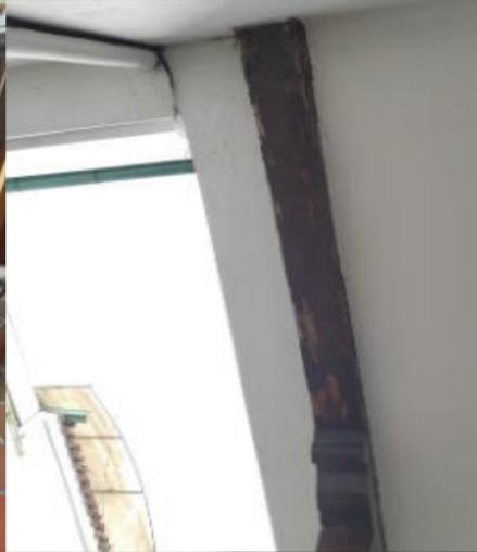
De igual manera los elemetos tipo vigas y columnas en material madera se encuentran afectados por insectos y plagas que afectan el funcionamiento de los mismos
