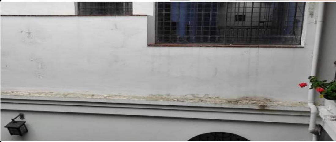
Se requiere la limpieza, pintura e impermeabilizacion del muro y la cornisa, ubicados en el segundo piso del patio 1.
