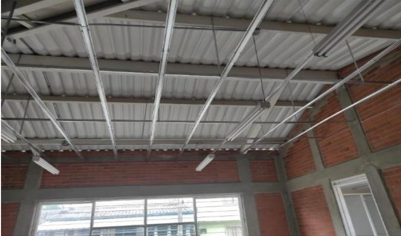
*Figura 20. Entramado metálico para instalación de cielo raso en PVC*
