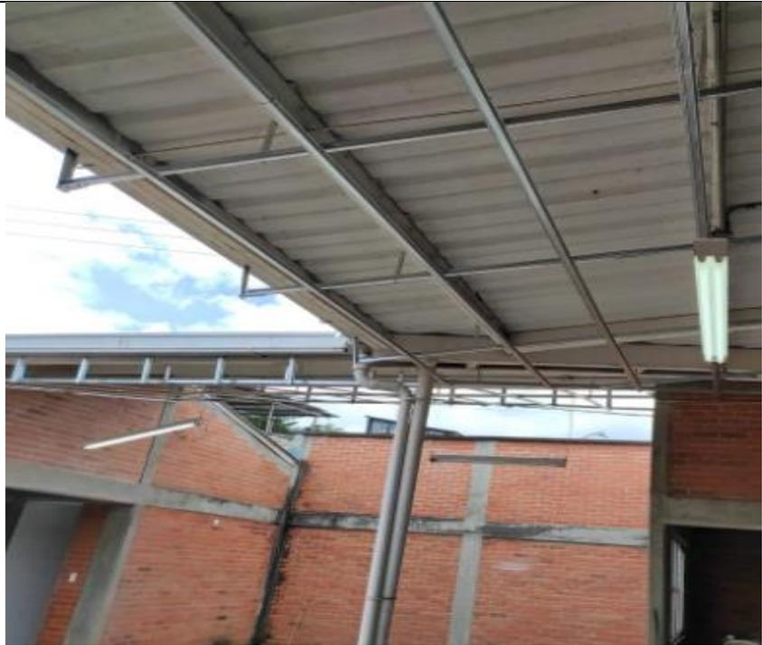
*Figura 23. Entramado metálico para instalación de cielo raso en PVC, Con acople para canal y bajante*
