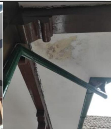
Se evidencia humedad en parte de cielo raso, exactamente en la zona donde se ubica la limahoya, de igual manera es necesario llevar a cabo una limpieza y reparacion de bajantes de aguas lluvias
