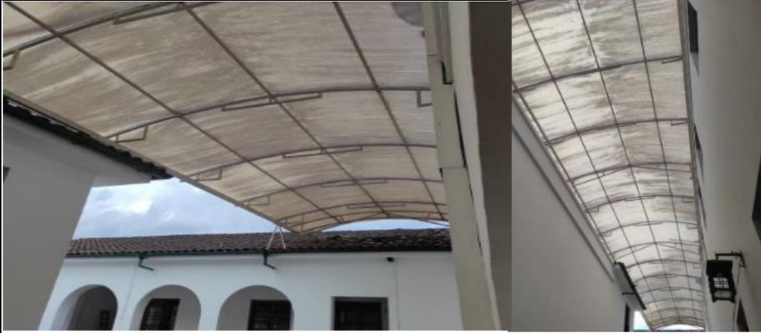
Se debe suministrar las tejas o las secciones que se encuentren afectadas y elementos faltantes para el normal funcionamiento de la cubierta, es necesario que se tenga especial cuidado con el remplazo de los elementos afectados, por tanto se debera tomar las medidas pertinentes para no afectar al personal que transita por lugar, asi como las instalaciones cercanas
