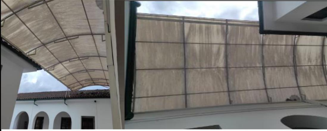
Se evidencia alto contenido de suciedad en la cubierta de policarbonato que se encuentra ubicada en el pasillo del auditorio el CAM, por lo cual es necesario realizar un recorrido de cubierta con personal tecnico calificado, de igual manera se requiere la limpieza de dicha cubierta, con el sistema de hidrolavado de agua a presion.
