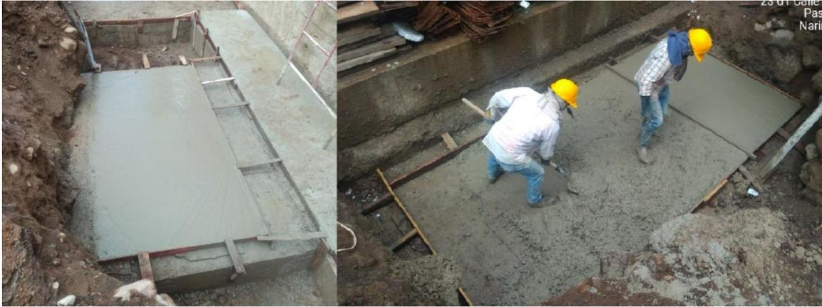
Fotografía 23. fundición de solados de limpieza (fuente: elaboración propia)
