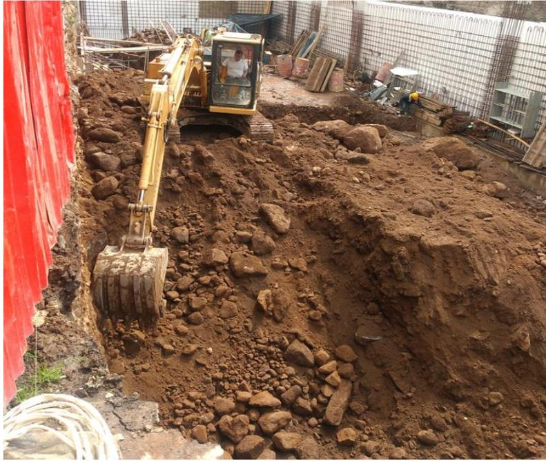
Fotografía 5. Maquina realizando excavación para soltar material (fuente: elaboracion propia)
