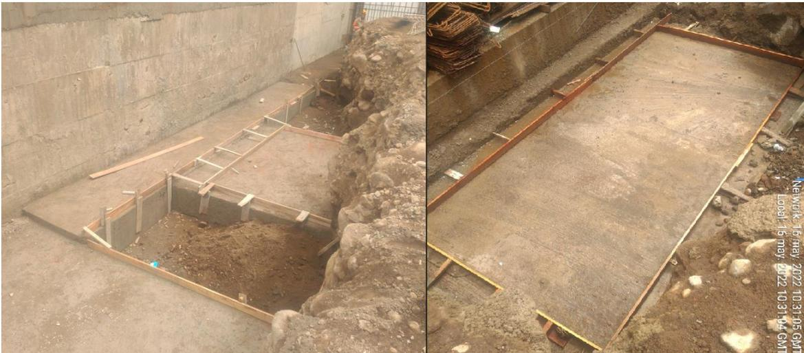
Fotografía 22. encofrado de solados de limpieza (fuente: elaboración propia)
