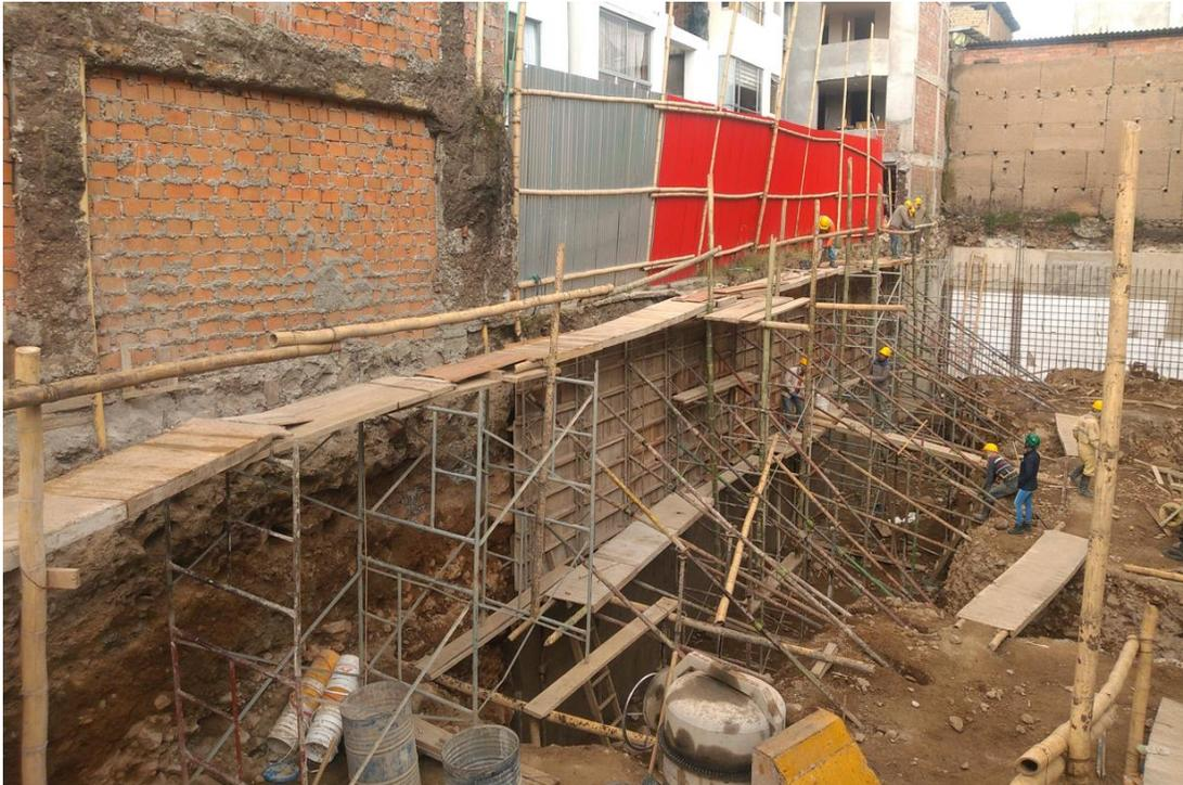
*Fotografía 16. trabajos de formaleta y plataformas para la fundición de recalces superiores (fuente: elaboración propia)*
