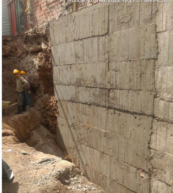
Fotografía 18. recalces secciones 20 y 21 fundidas en concreto (fuente: elaboración propia)
