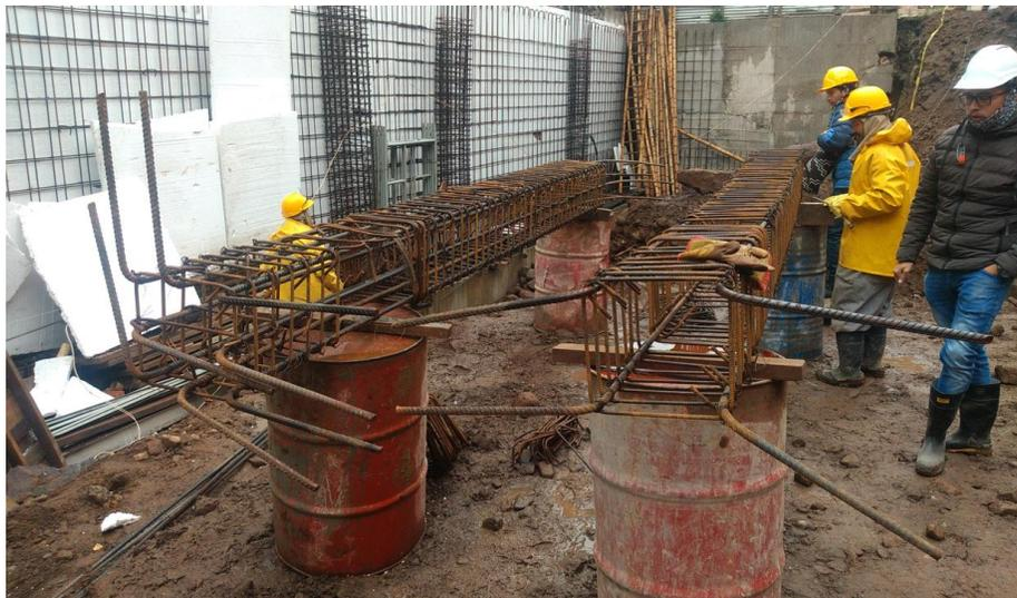
*Fotografía 27. armado de columnas sección pequeña (fuente: elaboración propia)*
