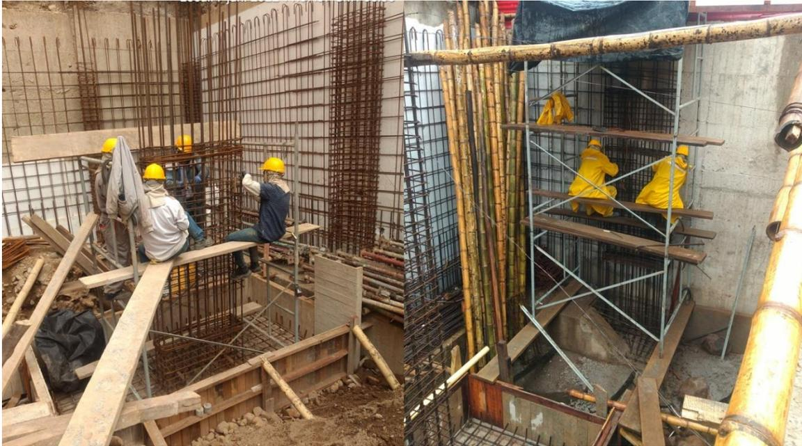
Fotografía 29. armado de columnas grandes (fuente: elaboración propia)
