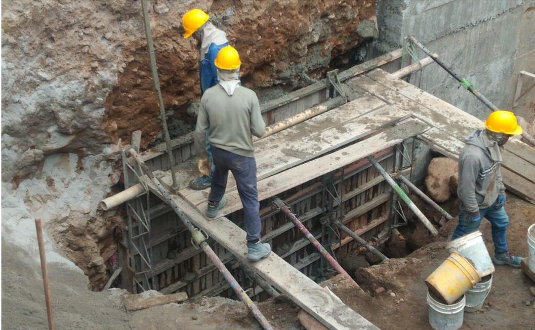
*Fotografía 12. Fundición de recalce inferior (fuente: elaboración propia)*
