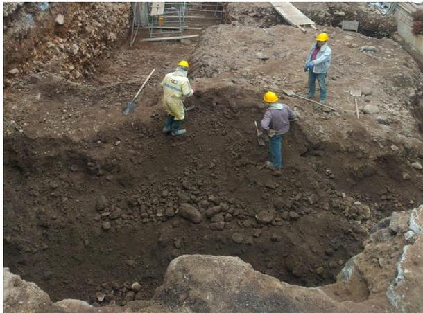
Fotografía 10. Excavación alcanzada a realizar con la maquina (fuente: elaboración propia)
