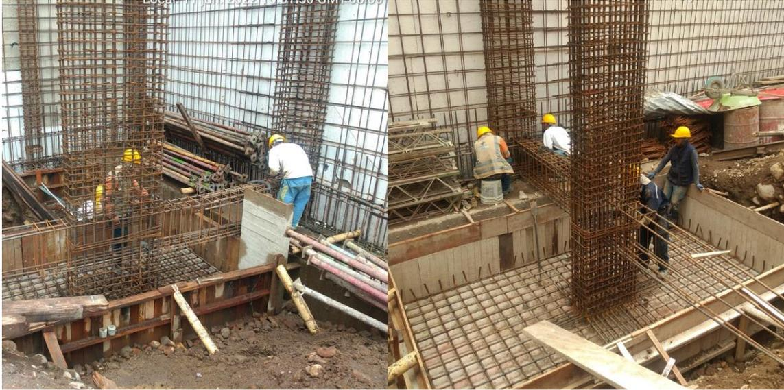
*Fotografía 30. armado de vigas de cimentación (fuente: elaboración propia)*
