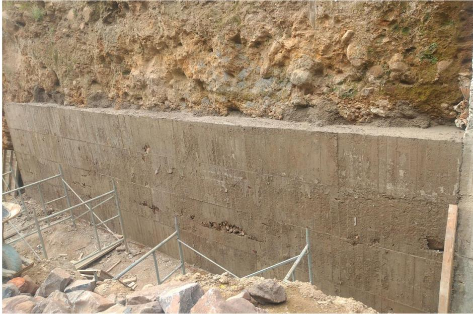
Fotografía 14. recalce inferior sección 18 fundido y sin formaleta (fuente: elaboración propia)
