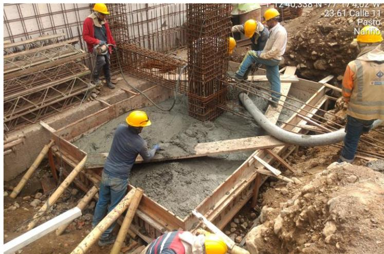
Fotografía 35. fundición de zapata (fuente: elaboración propia)
