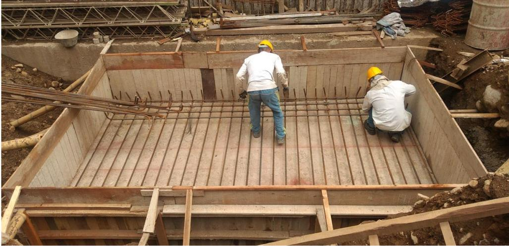
*Fotografía 26. armado de parrilla zapata aislada (fuente: elaboración propia)*
