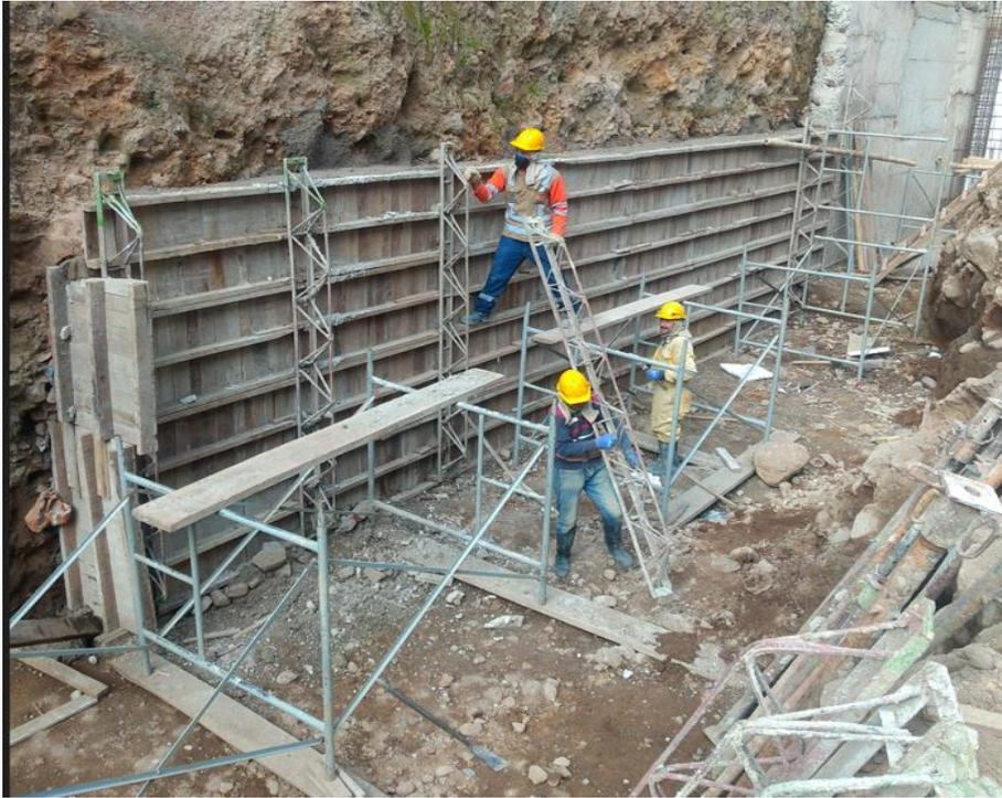
*Fotografía 13. formaleta recalce inferior sección 18 (fuente: elaboración propia)*
