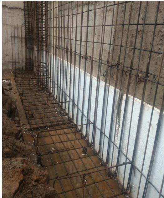
Fotografía 25. acero de zapata corrida y muro de contención (fuente: elaboración propia)
