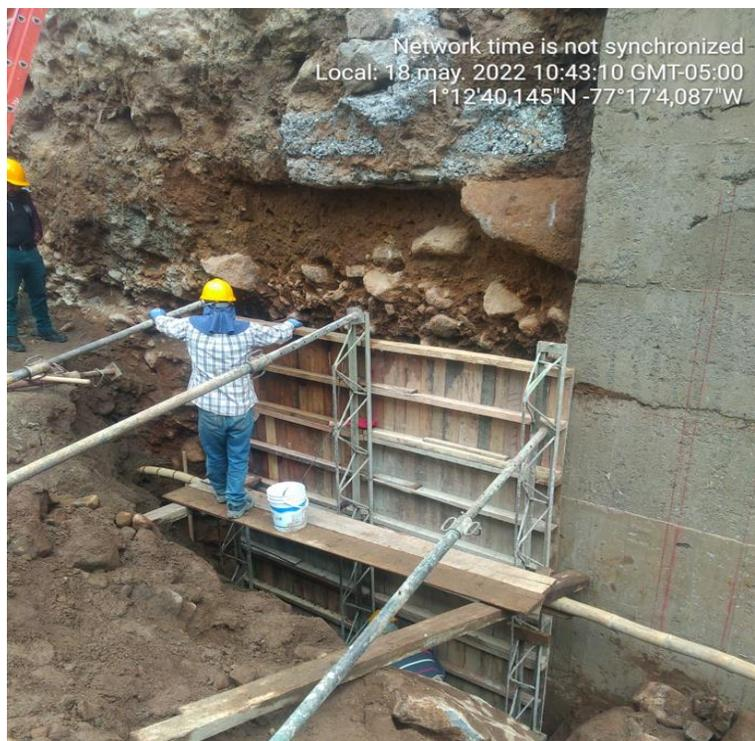
*Fotografía 17. recalce sección 20, zapata construcción vecina (fuente: elaboración propia)*
