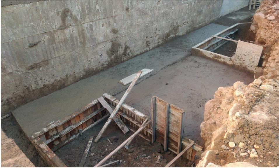
*Fotografía 20. Fundición de mejoramiento de suelo (fuente: elaboración propia)*
