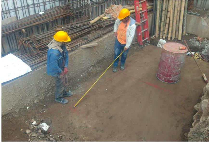
Fotografía 21. trazado de solado de limpieza (fuente: elaboración propia)
