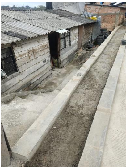
Figura 62. Bordillos instalados antes de fundir
