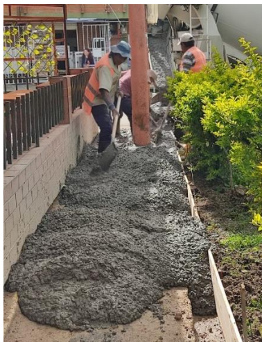
Figura 39. Vaciado de concreto
