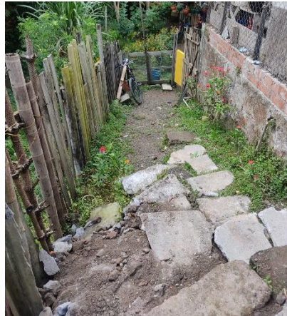
Figura 21. Entrada deteriorada a vivienda
