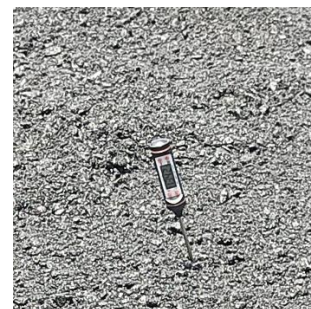
Figura 72. Temperatura de extensión de la mezcla (134.2° C)
