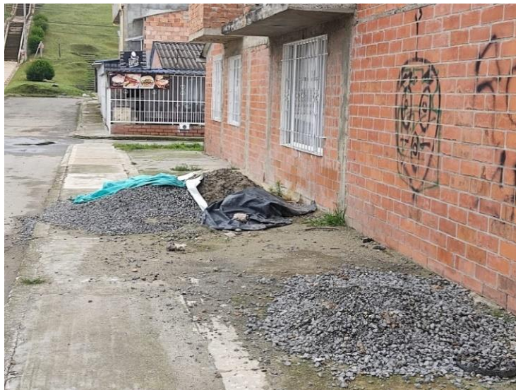
Figura 51. Escombros situados frente a la obra
