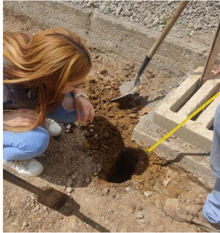
Figura 45. Apique para observar el material y su consistencia
