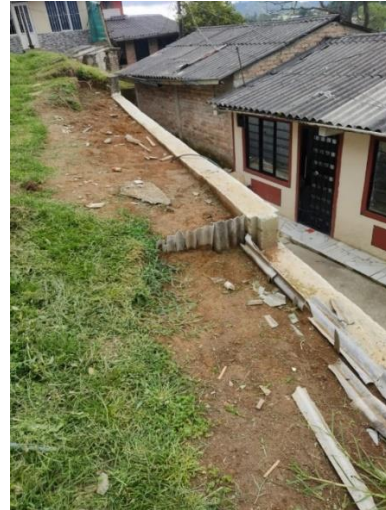
Figura 16. Vista del muro desde el nivel del terreno
