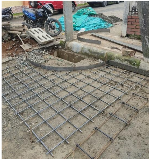
Figura 33. Refuerzo del sumidero y canastilla
