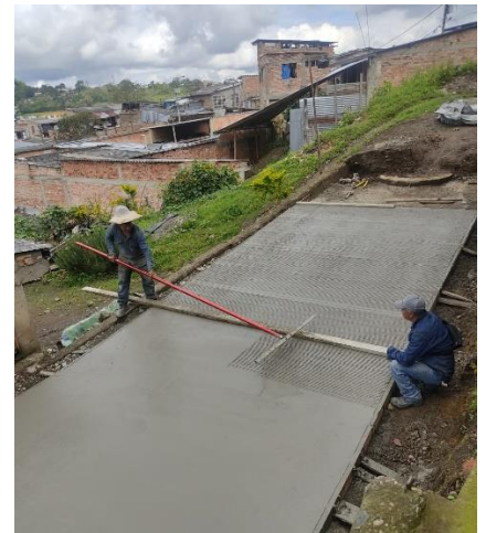
Figura 61. Acabado del concreto con rastrillo
