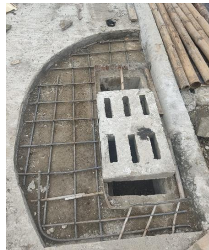
Figura 40. Refuerzo zona sumidero
