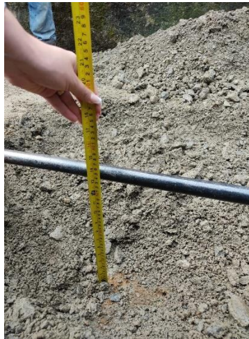
Figura 82. Medición espesor de subbase en apique No. 3
