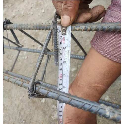
Figura 34. Medición flejes de la viga
