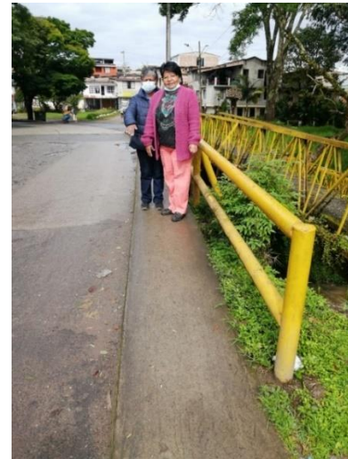
Figura 79. Andén existente con un ancho de 80 cm
