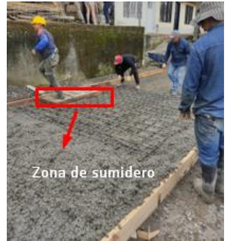
Figura 58. Colocación de parrillas de refuerzo
