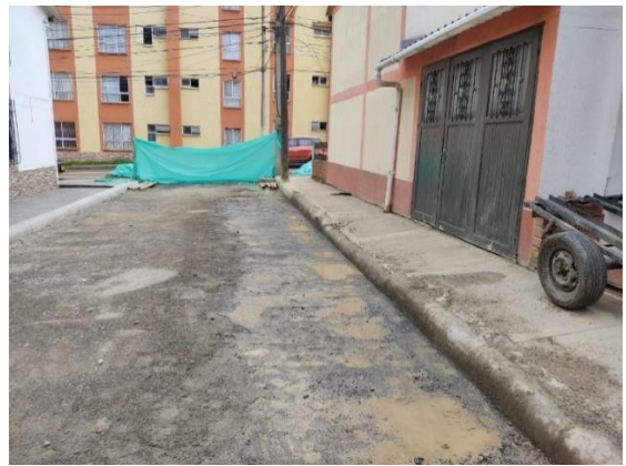
Figura 9. Capa de subbase y cerramiento
