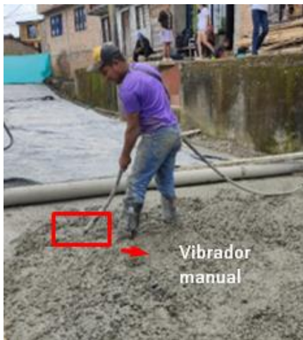
Figura 59. Vibrado manual de concreto
