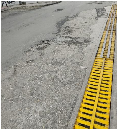
Figura 20. Re parcheo tramo vial existente
