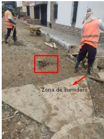
Figura 8. Excavación de apique cerca del sumidero
