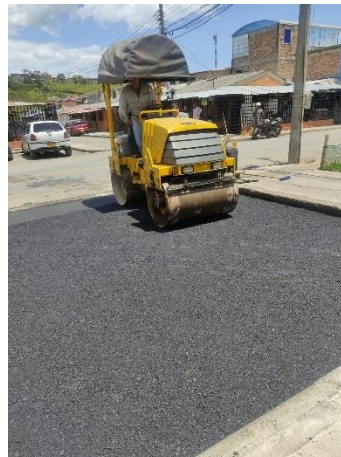
Figura 76. Compactación de la mezcla
