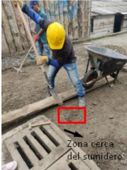
Figura 48. Apique No. 1 cerca del sumidero
