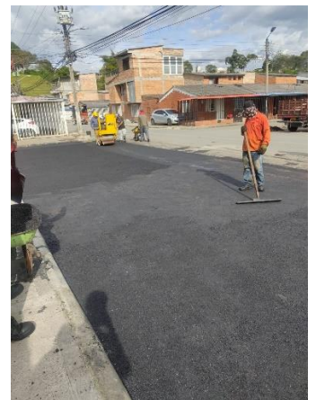
Figura 77. Mejoramiento del acabado de la mezcla
