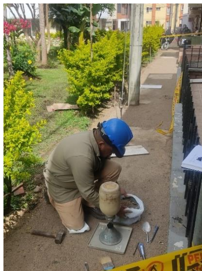
Figura 35. Toma de densidades para subbase
