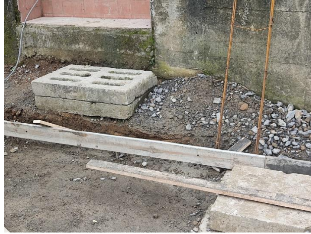
Figura 52. Formaleta con espesor menor al de diseño
