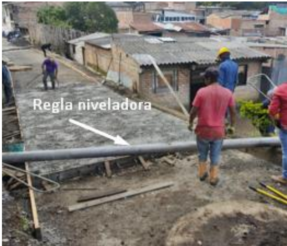
Figura 57. Nivelación del concreto extendido
