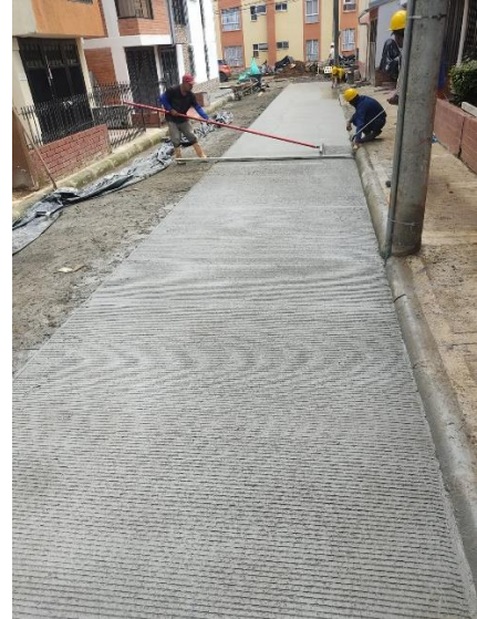
Figura 38. Acabado del concreto carril izquierdo
