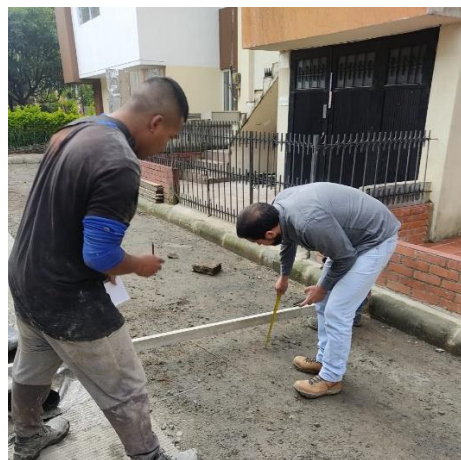
Figura 32. Medición espesor de la formaleta
