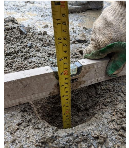
Figura 31. Medición de espesor en el apique No.2
