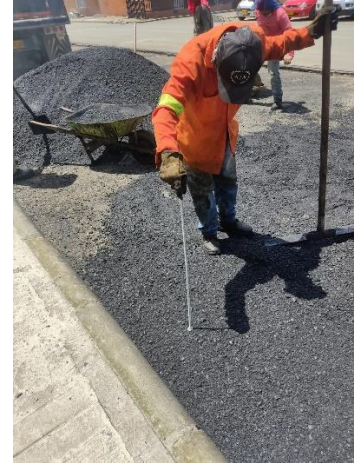
Figura 74. Verificación de espesor en la mezcla asfáltica
