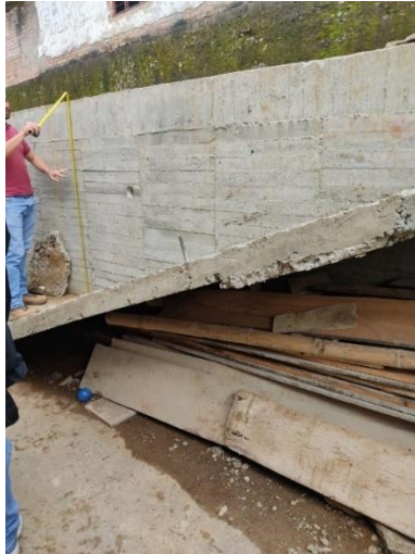
Figura 15. Medición de la altura del muro
