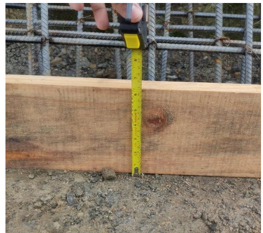
Figura 56. Medida del espesor de la nueva formaleta
