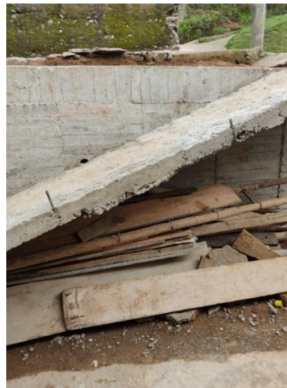
Figura 17. Rampa de acceso en concreto
