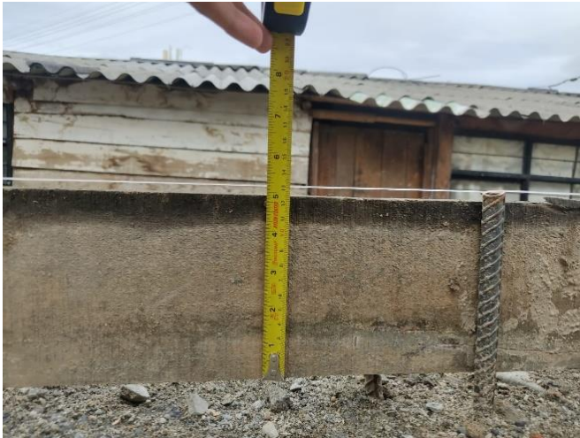
Figura 53. Medida de formaleta con espesor menor al de diseño
