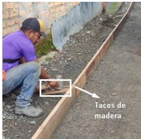
Figura 55. Colocación de tacos en la nueva formaleta
