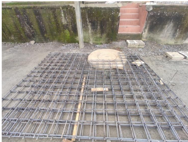
Figura 50. Parrilla de refuerzo para las losas de concreto
