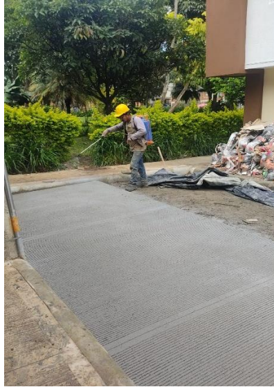
Figura 37. Curado de la losa en concreto con SIKA
