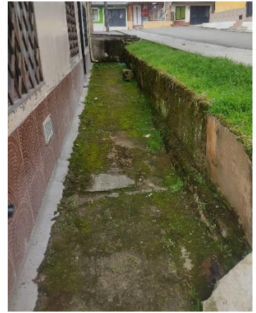
Figura 22. Muro de contención de 1 metro de alto
