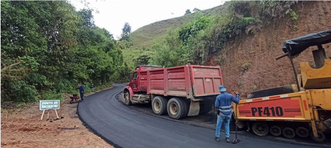
*Ilustración 16. Instalación de carpeta asfáltica. Fuente: El autor*
