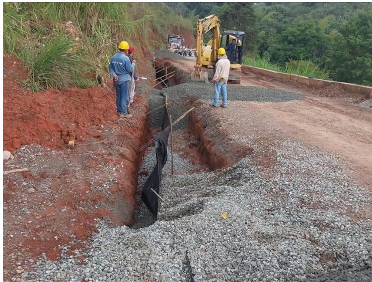
Ilustración 9. Construcción filtro longitudinal. Fuente: El autor.
