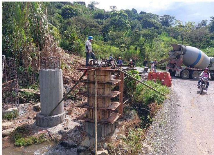
*Ilustración 12. Construcción de pilotes para el puente. Fuente: El autor.*
