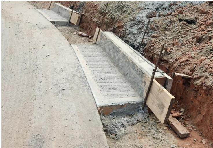
*Ilustración 13. construcción de cunetas. Fuente: El autor.*
