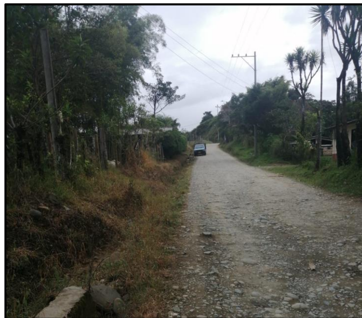
Figura 42. Cerramiento Pisoje Alto, Municipio de Popayán
