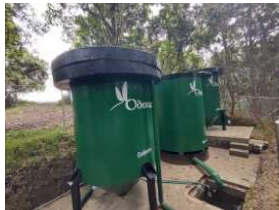
Ilustración 23 A) Clarificador o sedimentador secundario. B) Evidencia del trayecto del agua proveniente del filtro percolador hacia estación de bombeo 2 continuando al clarificador. Fuente: Propia
