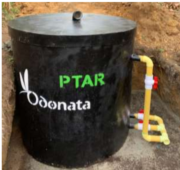
Ilustración 33. Sistema séptico individual Odonata en las instalaciones de un cliente listo para conectarse. Fuente Propia
