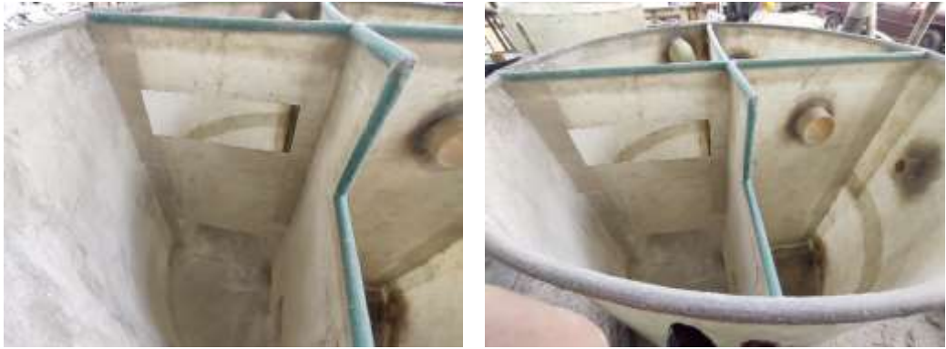
Ilustración 31. Compartimientos internos Sistema individual. Fuente: Propia.
