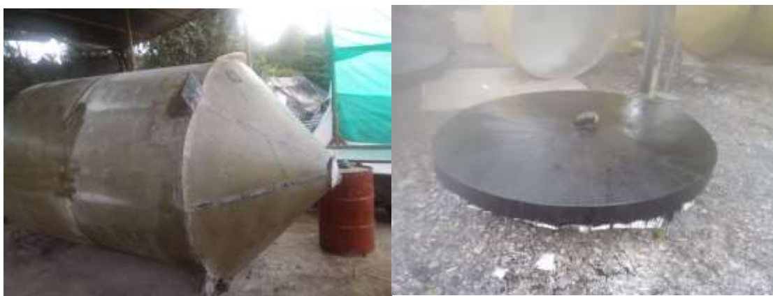
Ilustración 11. Fabricación de tolva sedimentador primario y en paralelo las tapas de los tanques. Fuente: Propia
