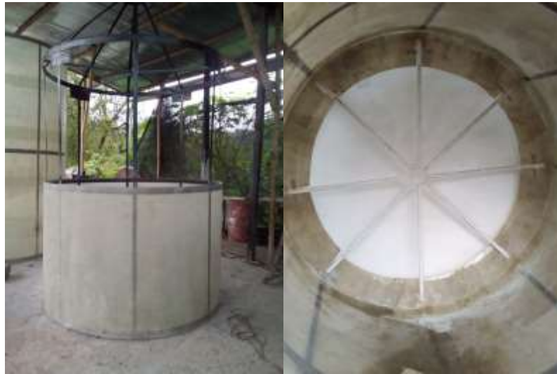
Ilustración 9 Capa de amarre con la estructura metálica para sedimentador primario y filtro percolador. Fuente Propia
