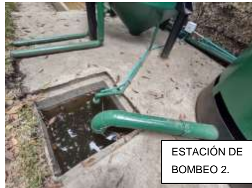
Ilustración 22 a) Vista de trayecto del fluido desde el filtro percolador hacia la estación de bombeo 2 para continuar al clarificador. b) Estación de bombeo 2. Fuente: Propia
