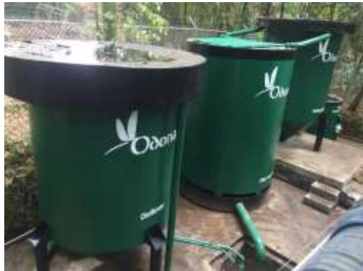
Ilustración 22 a) Vista de trayecto del fluido desde el filtro percolador hacia la estación de bombeo 2 para continuar al clarificador. b) Estación de bombeo 2. Fuente: Propia
