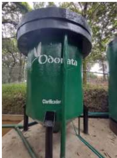
Ilustración 23 A) Clarificador o sedimentador secundario. B) Evidencia del trayecto del agua proveniente del filtro percolador hacia estación de bombeo 2 continuando al clarificador. Fuente: Propia
