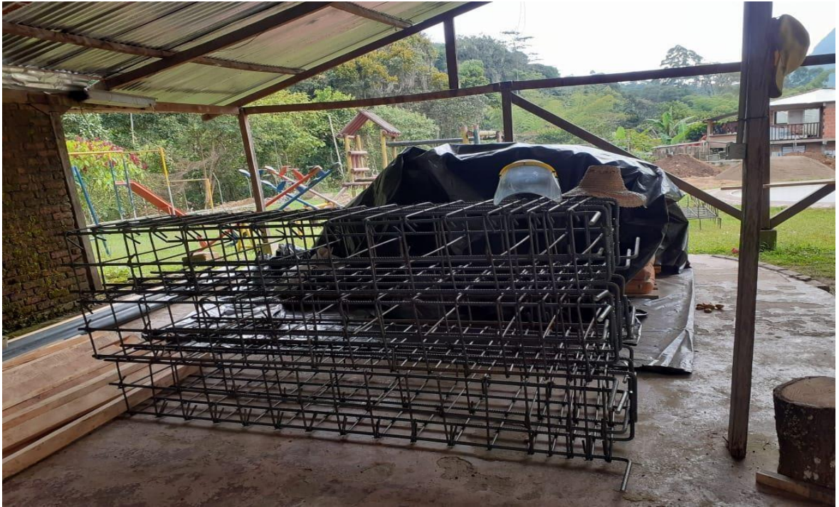
Imagen 50. Amarre de acero para castillos Escenario Deportivo La Mina. Fuente: propia
