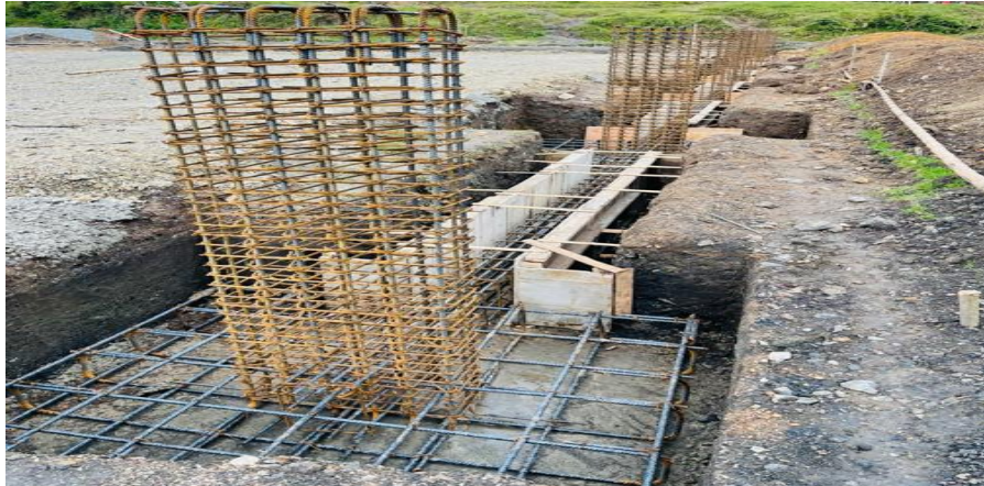
Imagen 23. Instalación de formaletas en vigas de cimentación. Fuente: propia
