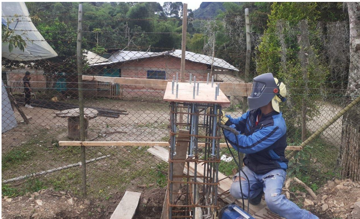
Imagen 54. Instalación de pernos de anclaje Escenario Deportivo La Mina. Fuente: propia
