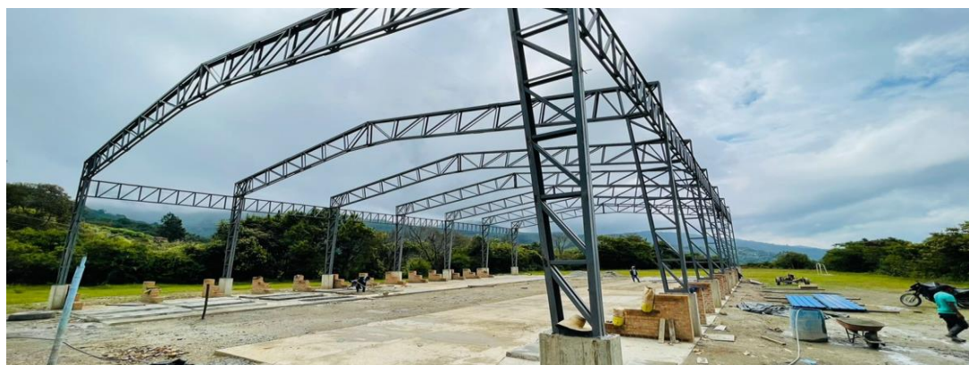
Imagen 27. Instalación estructura metálica Escenario Deportivo Chamicueto. Fuente: propia
