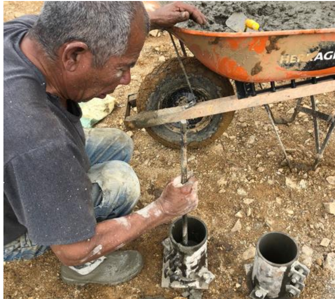
Imagen 37. Toma de muestras para ensayos de resistencia del concreto estructural. Fuente: propia
