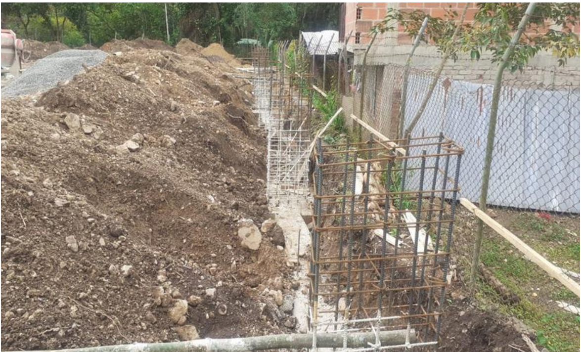
Imagen 53. Castillo de acero para pedestales Escenario Deportivo La Mina. Fuente: propia
