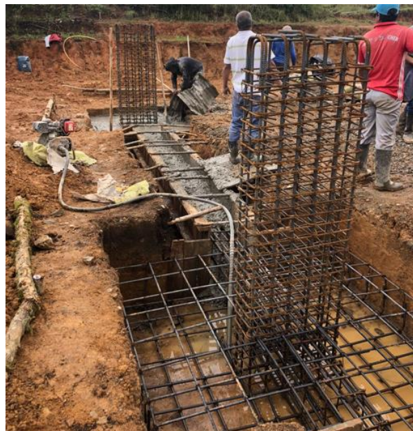
Imagen 34. Fundición elementos de cimentación Escenario Deportivo San Antonio. Fuente: propia
