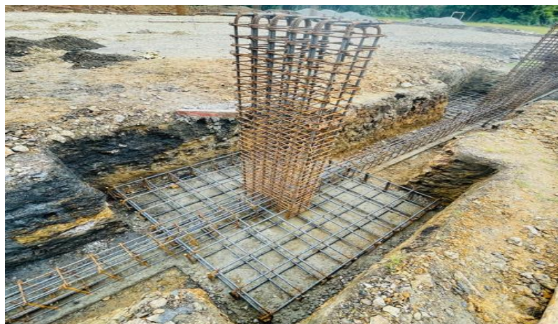
Imagen 22. Corrección de posición de acero de cimentación. Fuente: Propia
