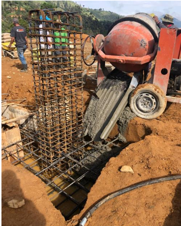
Imagen 35. Fundición Zapatas Escenario Deportivo San Antonio. Fuente: propia
