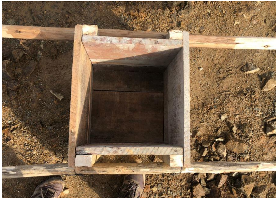
Imagen 36. Rectificación de medidas de cajones para dosificación de concreto. Fuente: propia
