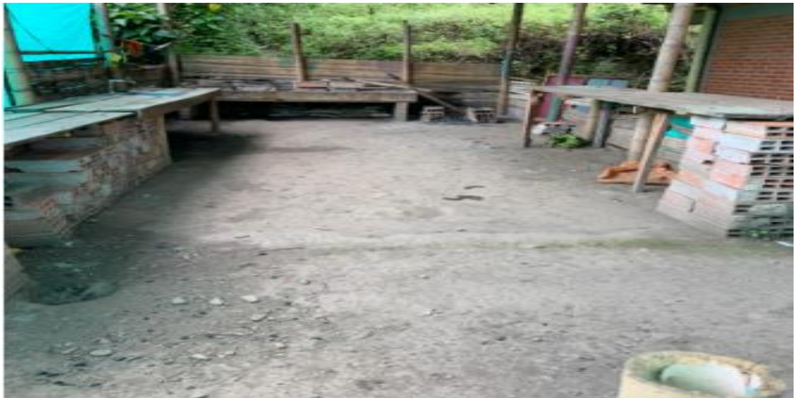
Imagen 2. Casa de la cultura vereda El Porvenir. Fuente propia
