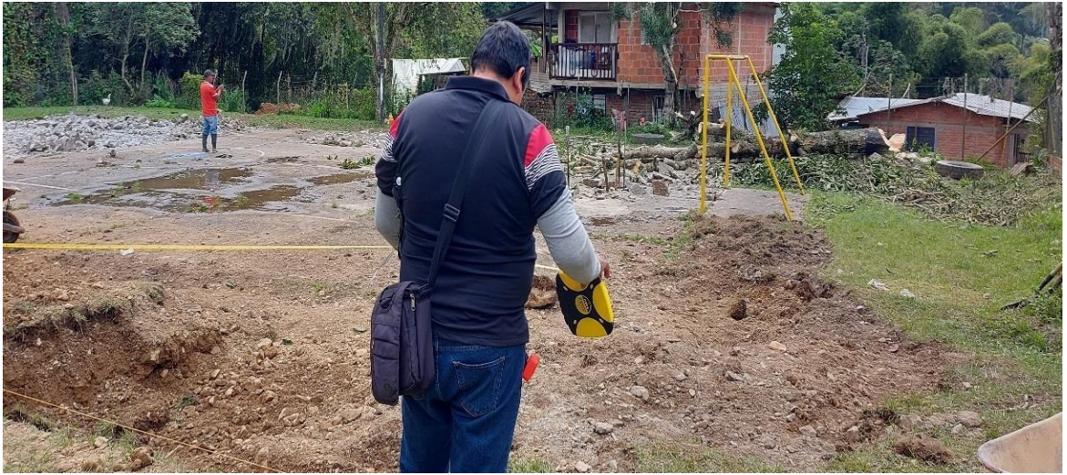
Imagen 44. Localización y replanteo Escenario Deportivo La Mina.. Fuente: propia
