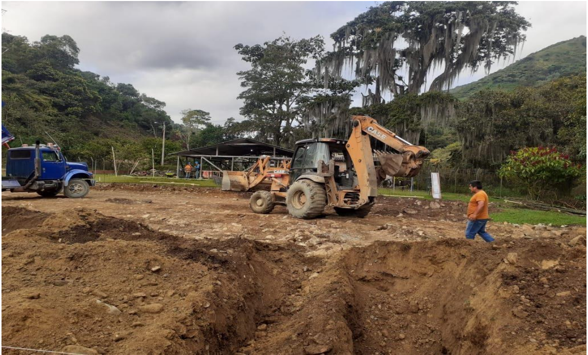
Imagen 46. Excavación mecánica material común Escenario Deportivo La Mina. Fuente: propia
