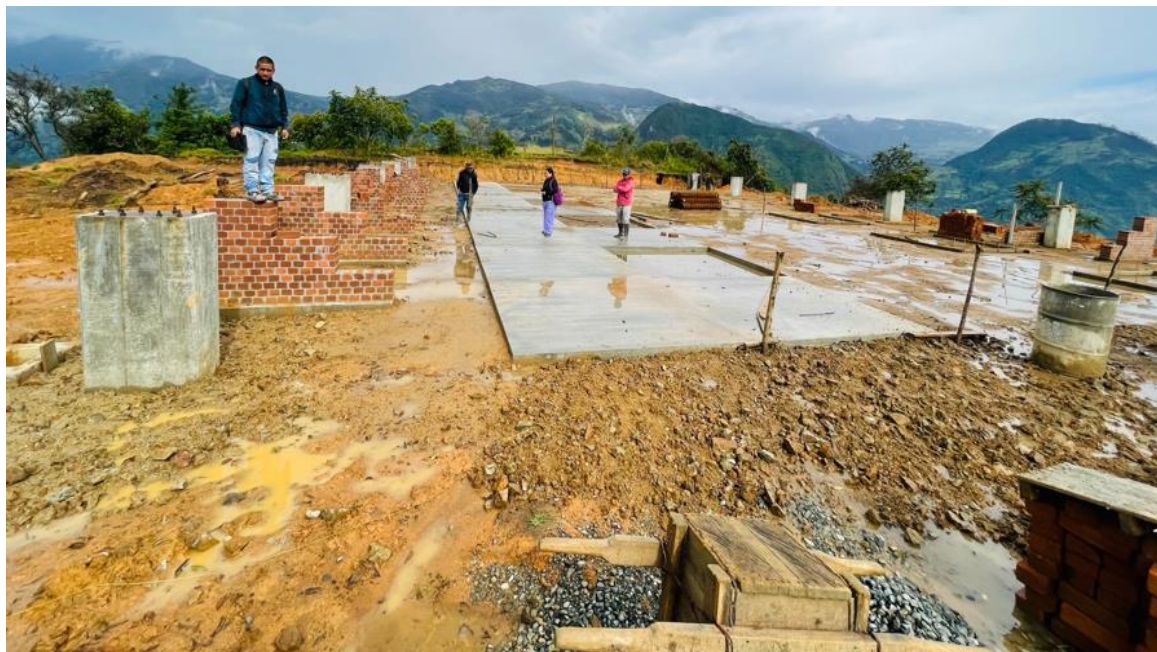
Imagen 41. Construcción de graderías en mampostería Escenario Deportivo San Antonio. Fuente: propia
