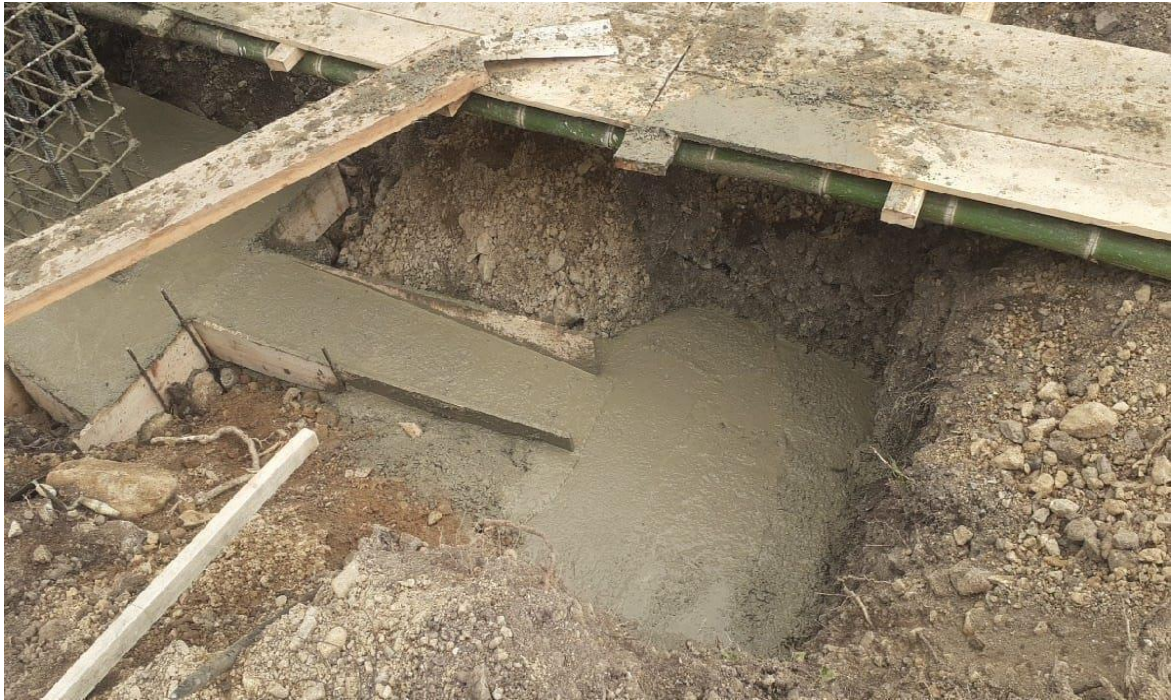
Imagen 52. Fundición de Zapatas Escenario Deportivo La Mina. Fuente: propia
