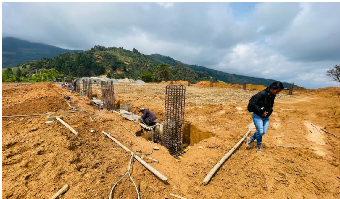
Imagen 32. Instalación formaletas en cimentación Escenario Deportivo San Antonio. Fuente: propia
