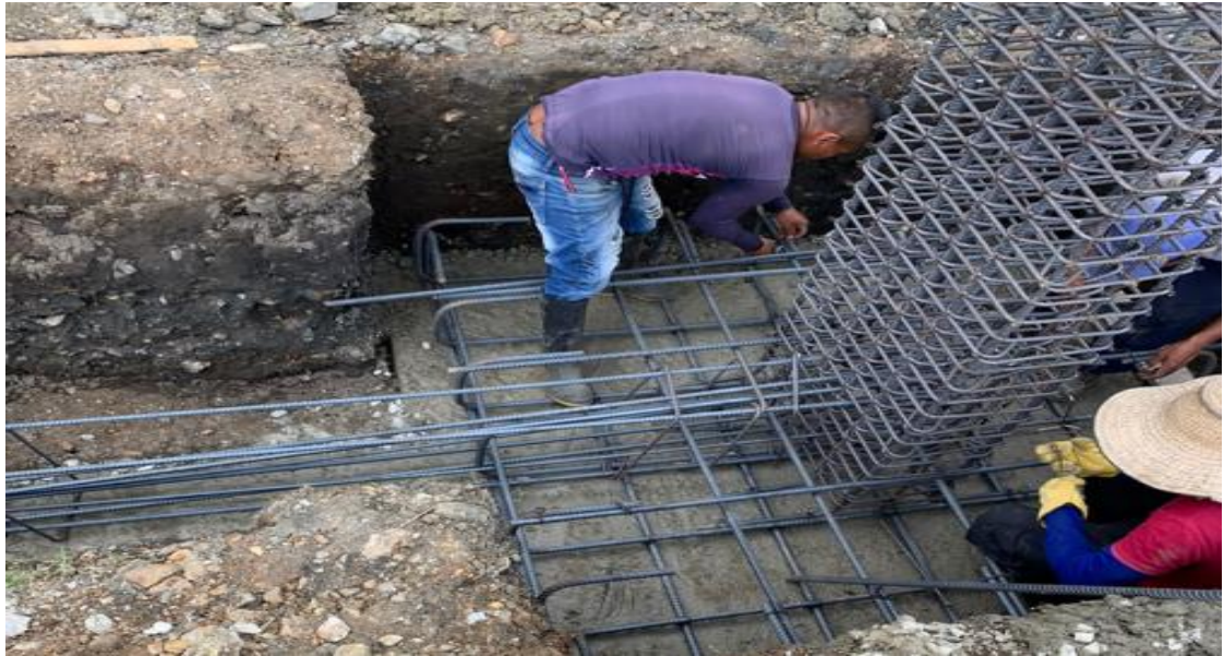
Imagen 21. Instalación de acero de cimentación. Fuente: Propia
