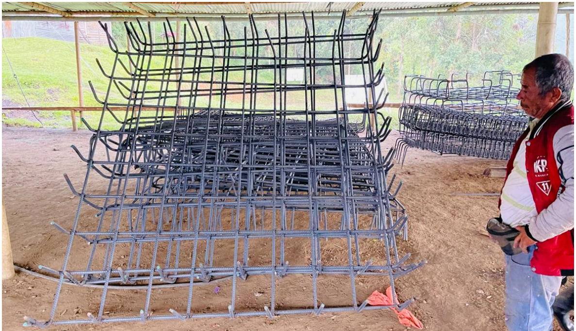
Imagen 20. Corte y figuración de acero de zapatas. Fuente: propia
