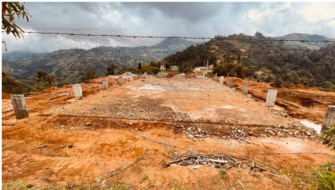
Imagen 39. Pedestales fundidos Escenario Deportivo San Antonio. Fuente: propia
