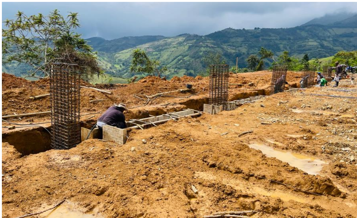
Imagen 31. Instalación acero de cimentación en el eje 2. Fuente: propia
