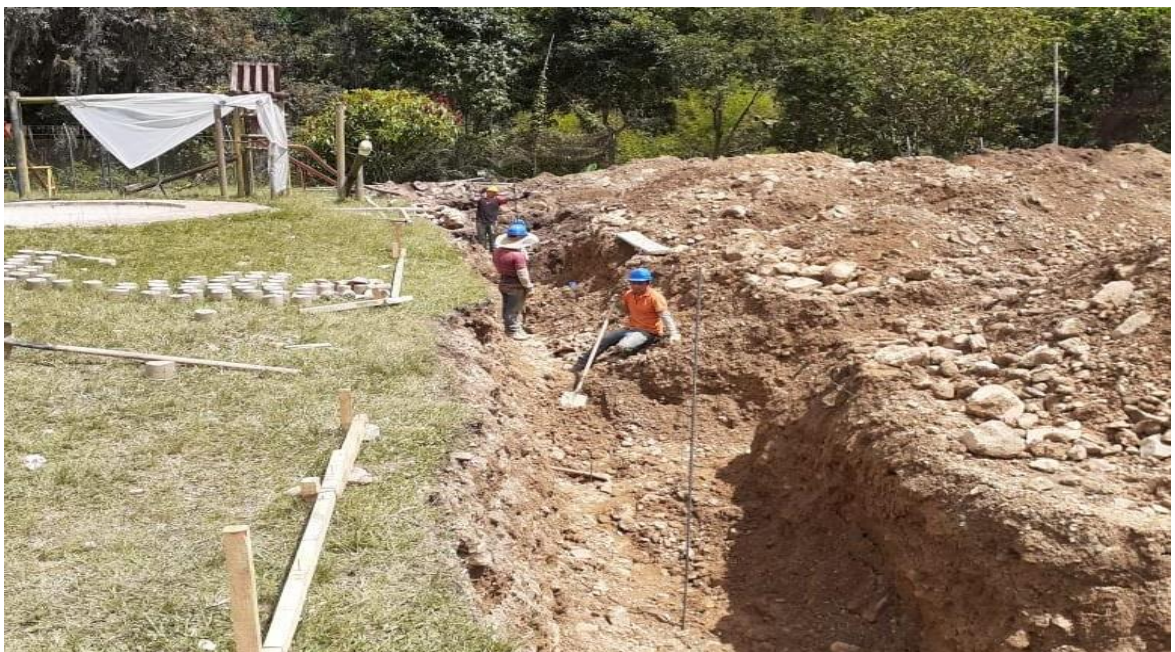
Imagen 47. Excavación manual material común Escenario Deportivo La Mina. Fuente: propia
