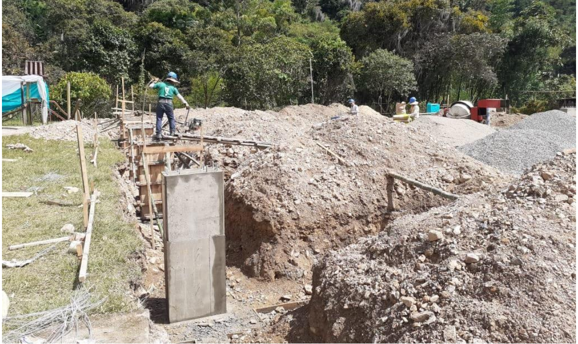
Imagen 56. Desencofrado de pedestales Escenario Deportivo La Mina. Fuente: propia
