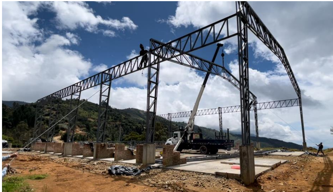
Imagen 42. Instalación estructura metálica Escenario Deportivo San Antonio. Fuente: propia
