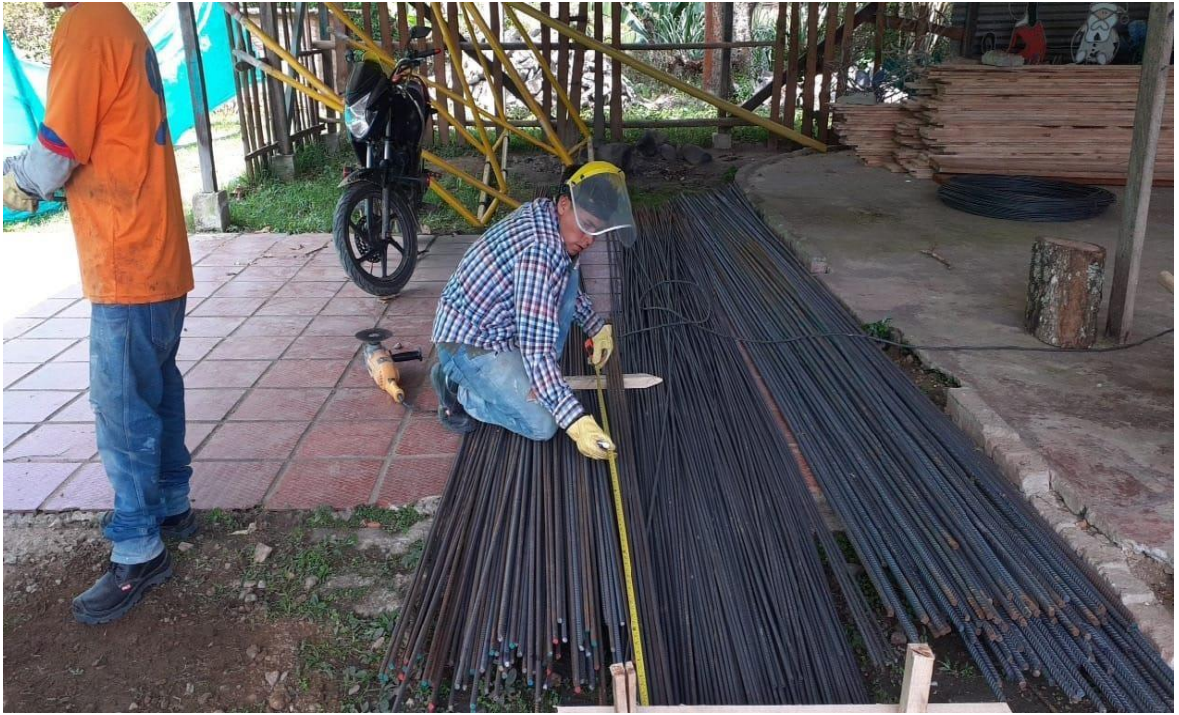
Imagen 48. Corte y figuración de acero Escenario Deportivo La Mina. Fuente: propia
