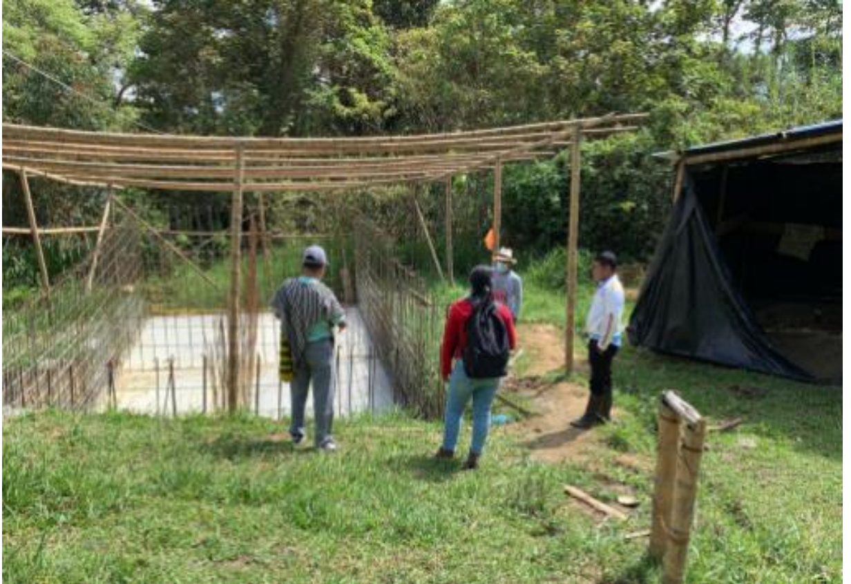
Imagen 8. Alcantarillado sanitario vereda El Trapiche. Fuente propia
