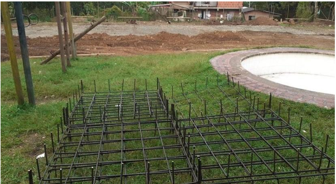
Imagen 49. Corte y figuración de acero de Zapatas Escenario Deportivo La Mina. Fuente: propia
