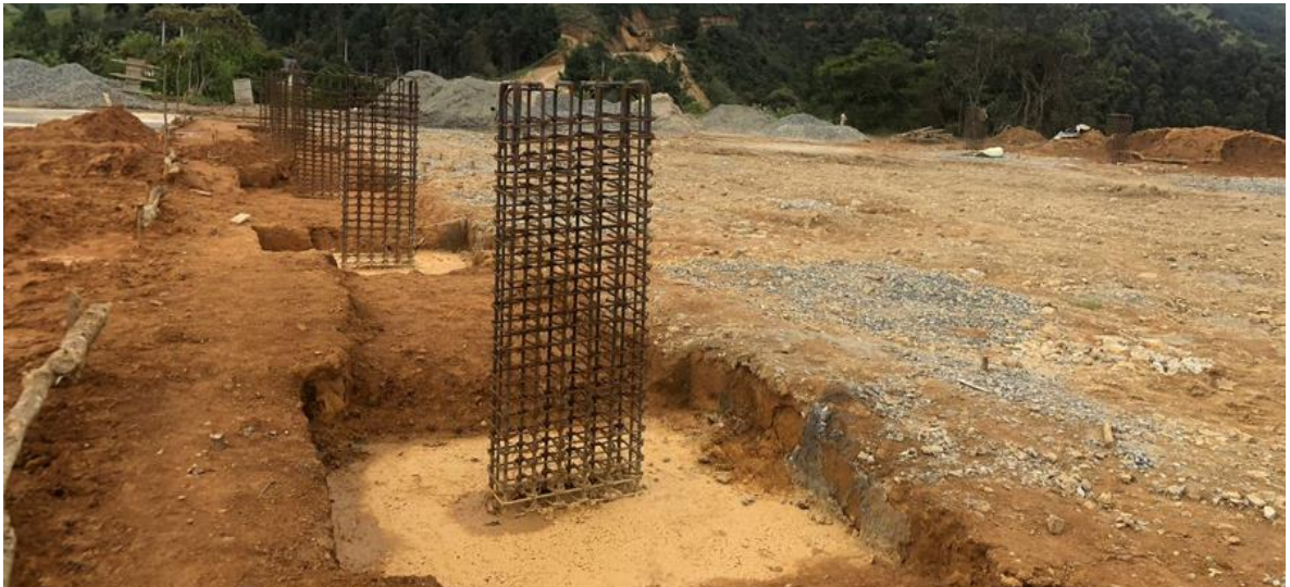
Imagen 38. Zapatas y vigas centradas fundidas. Fuente: propia
