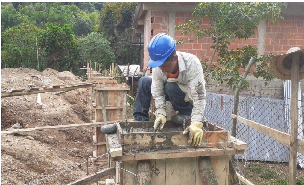
Imagen 55. Fundición de pedestales Escenario Deportivo La Mina. Fuente: propia
