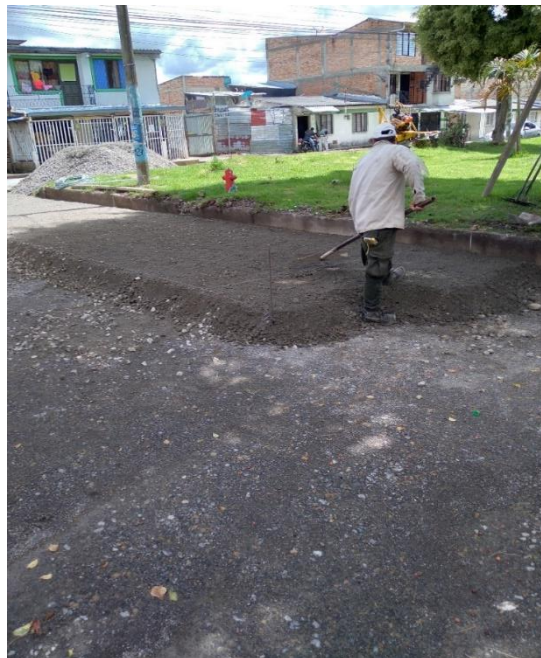
Ilustración 26 riego y compactación obra Santiago de Cali
