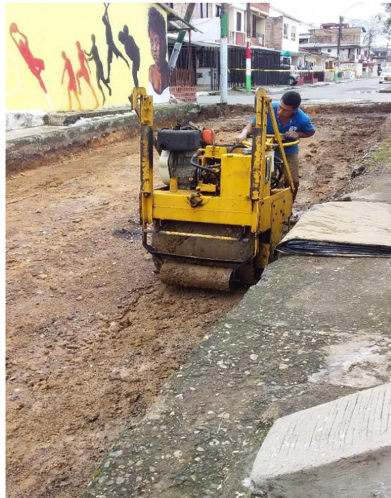
Ilustración 5 compactación subrasante obra El triunfo
