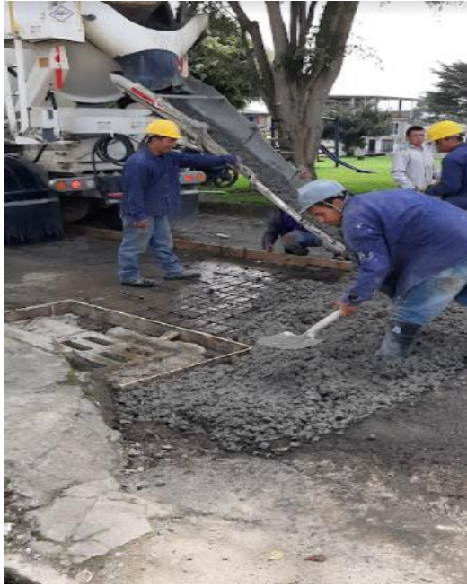
Ilustración 31 fundición obra Santiago de Cali
