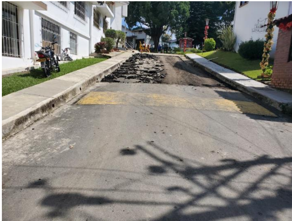
Ilustración 45 remoción pavimento obra Lomalinda
