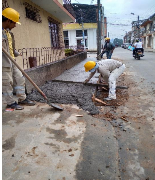
Ilustración 20 vibrado obra Belalcázar
