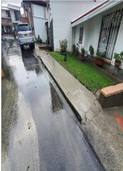
Ilustración 40 vibrado y acabados obra Lomalinda
