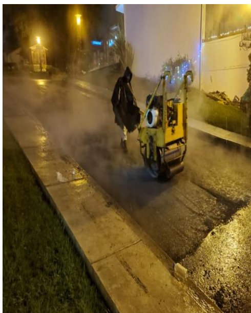
Ilustración 49 compactación final obra Lomalinda
