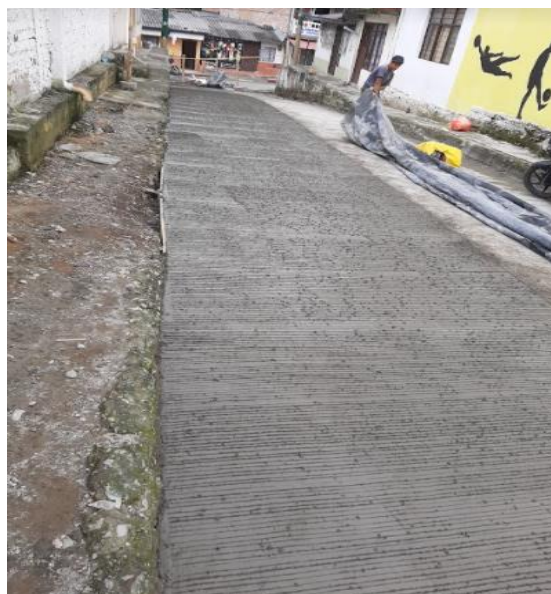
Ilustración 15 texturizado final obra El triunfo
