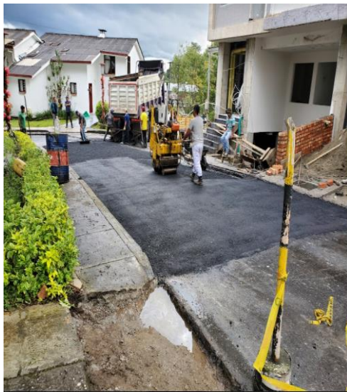
Ilustración 48 compactación mezcla asfáltica obra Lomalinda
