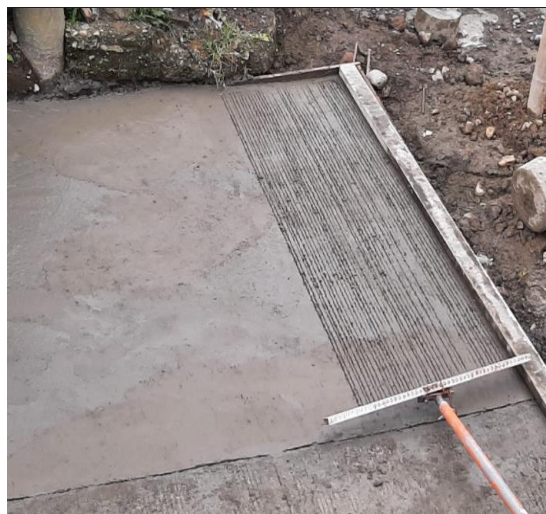
Ilustración 14 texturizado parcial obra El triunfo
