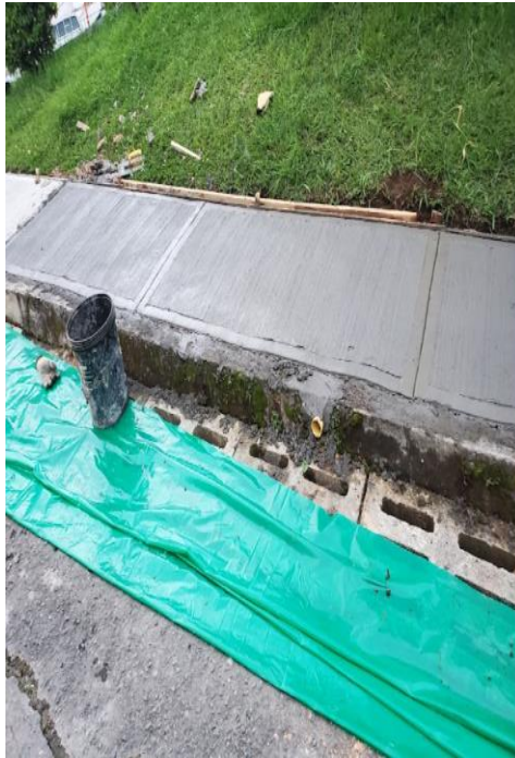
Ilustración 41 texturizado obra Lomalinda
