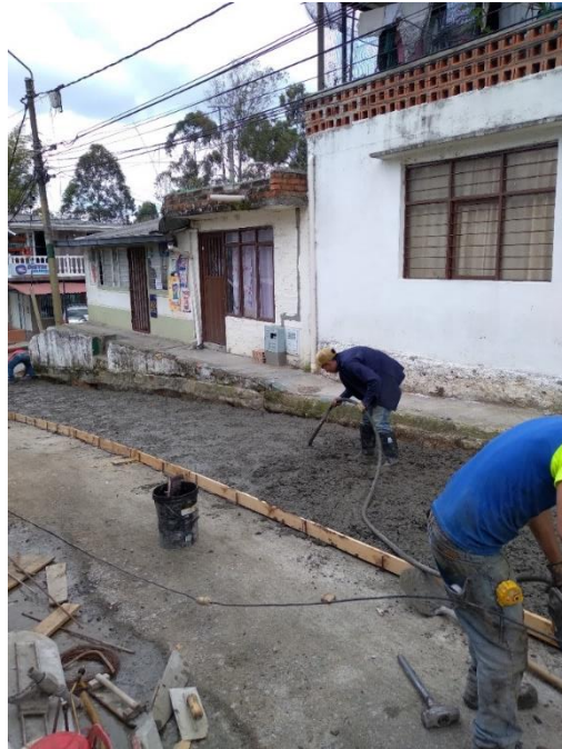
Ilustración 12 vibrado obra El triunfo
