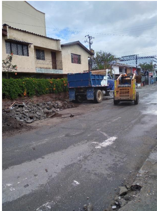
Ilustración 17 descapote obra Belalcázar
