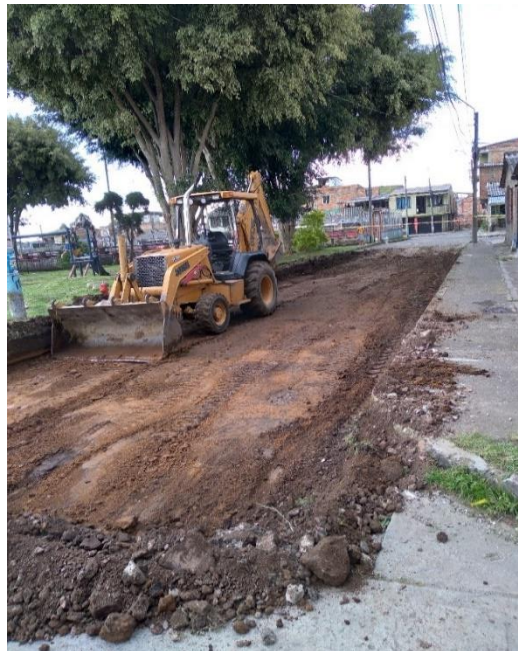
Ilustración 25 nivelación y perfilación obra Santiago de Cali
