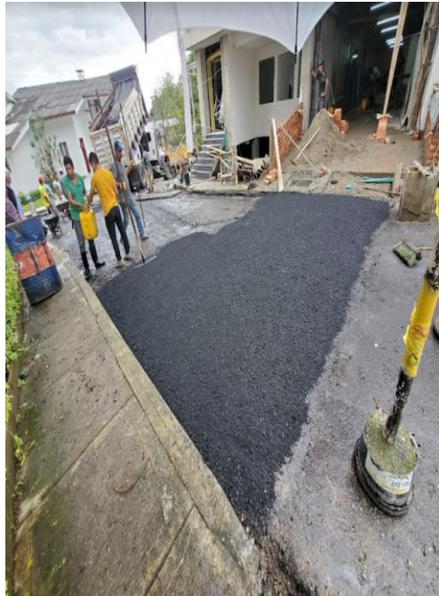
Ilustración 47 colocación mezcla asfáltica obra Lomalinda
