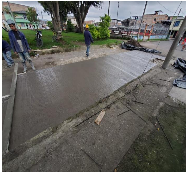
Ilustración 34 texturizado obra Santiago de Cali
