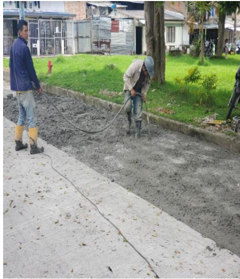
Ilustración 32 vibrado obra Santiago de Cali
