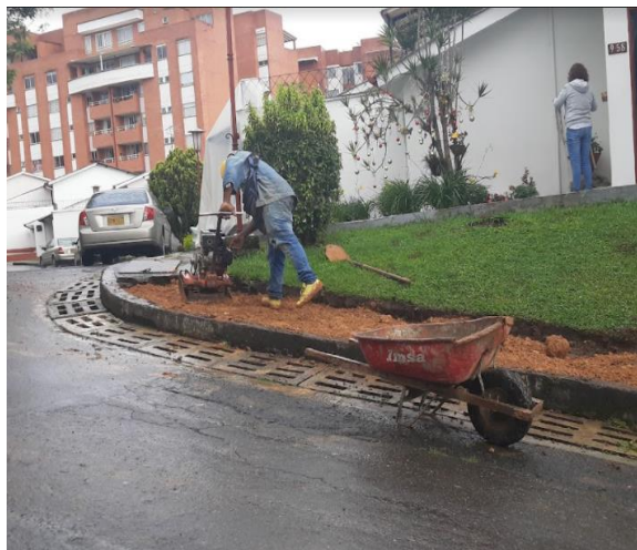
Ilustración 37 compactación obra Lomalinda
