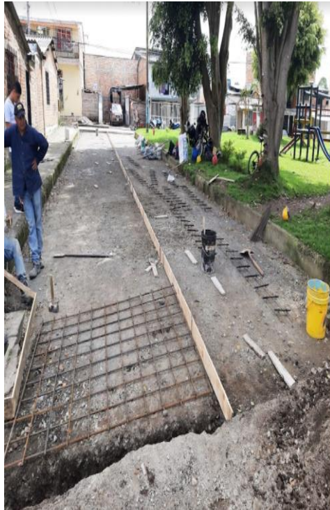
Ilustración 30 acero refuerzo obra Santiago de Cali
