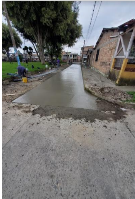
Ilustración 33 acabados obra Santiago de Cali
