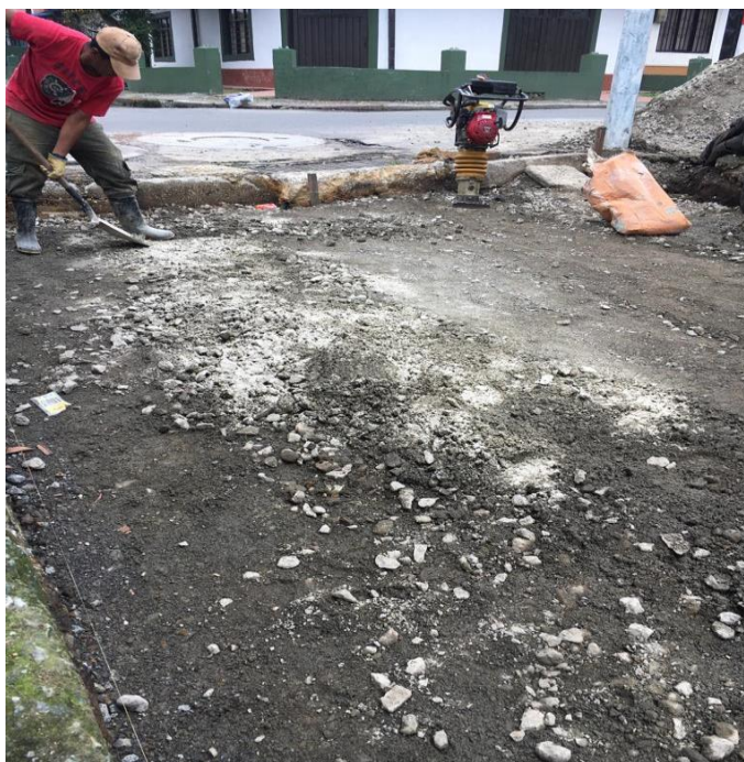
Ilustración 7 mejoramiento sub base obra El triunfo
