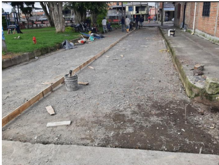
Ilustración 27 formaleta obra Santiago de Cali
