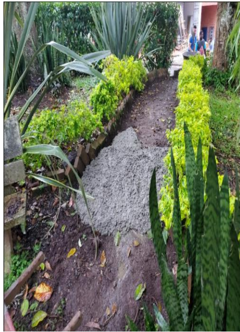
Ilustración 42 concreto de caminos obra Lomalinda
