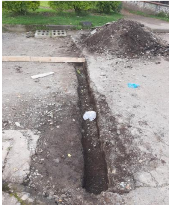
Ilustración 29 viga refuerzo obra Santiago de Cali
