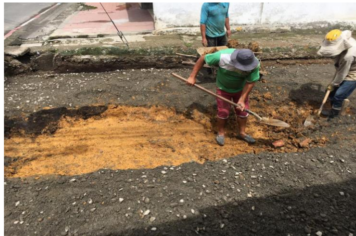
Ilustración 6 reparación obra El triunfo
