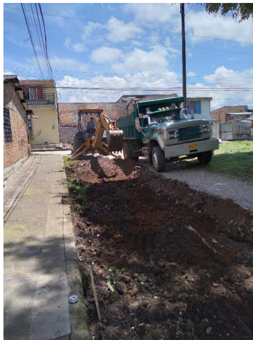
Ilustración 24 excavación obra Santiago de Cal
