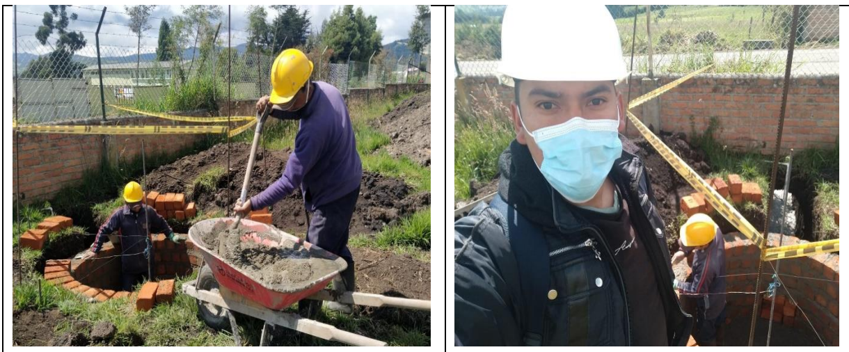
Figura 24. Verificación cajas de inspección
