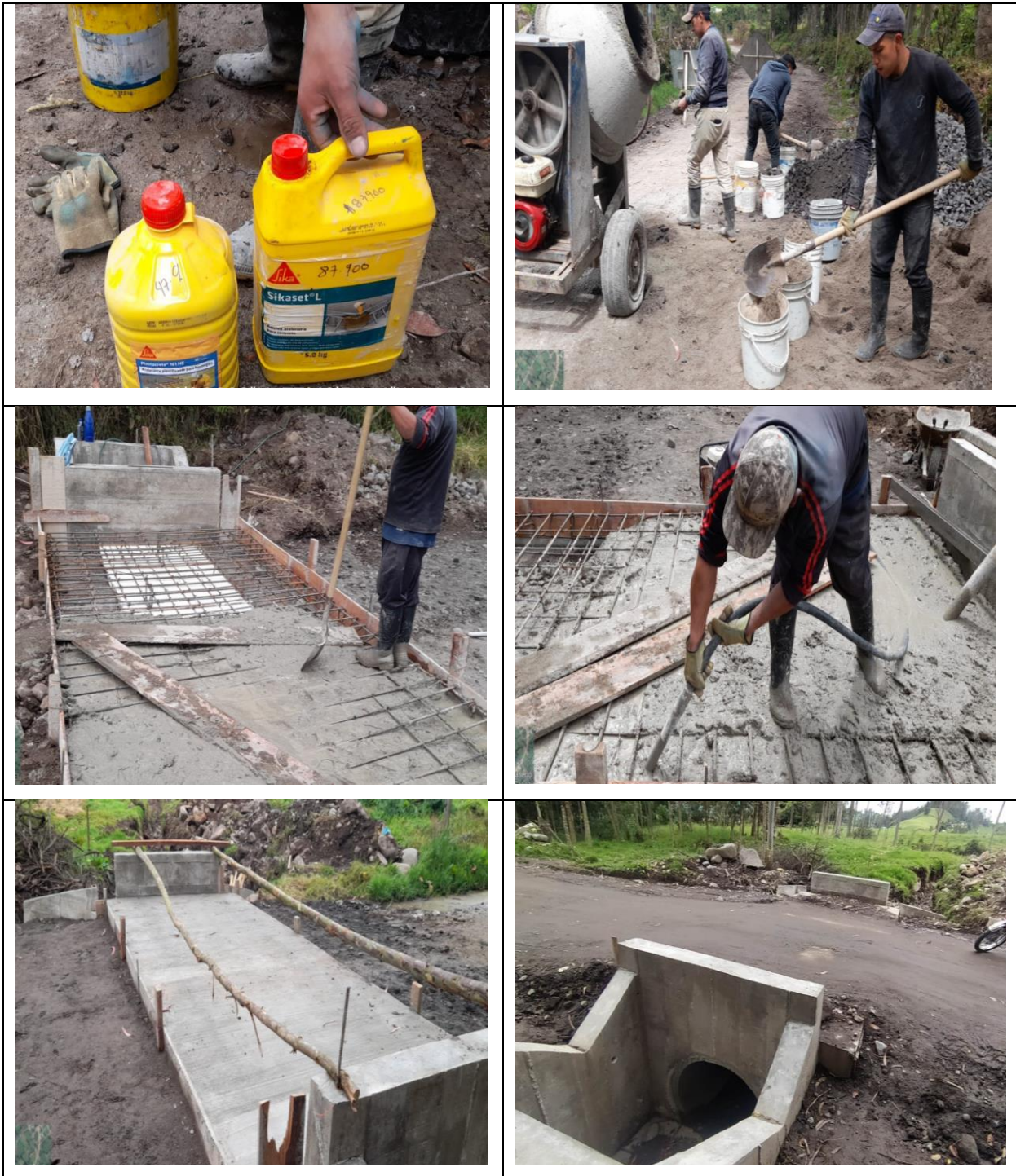
Figura 53. Fundición y vibrado boxculvert
