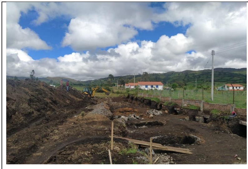
Figura 8. Visita a obra mejoramiento estadio de Chiles
