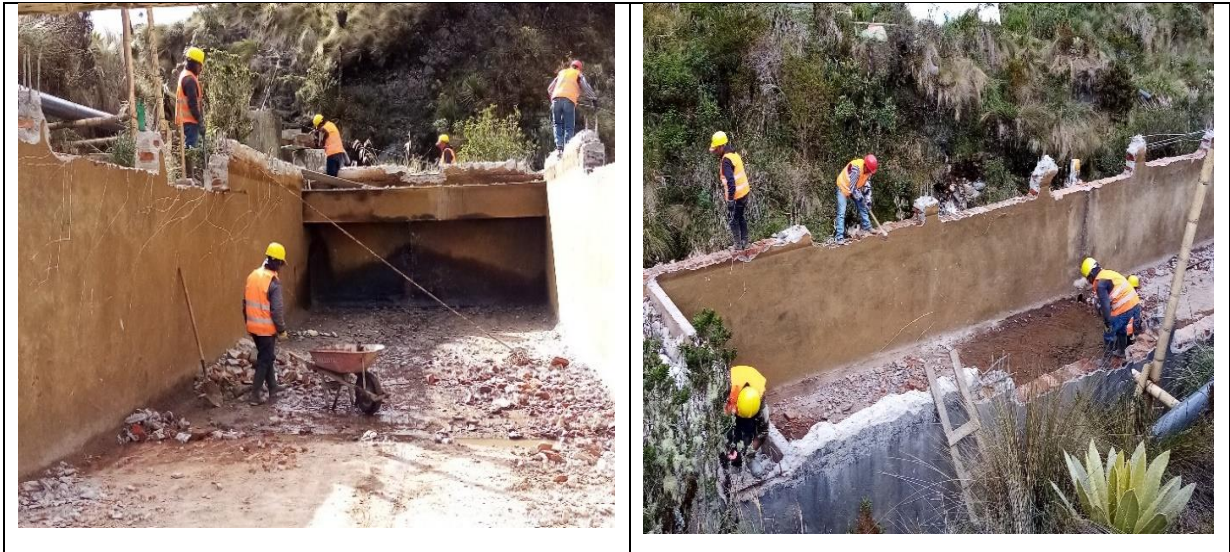
Figura 25. Demolición de estructuras existentes en concreto
