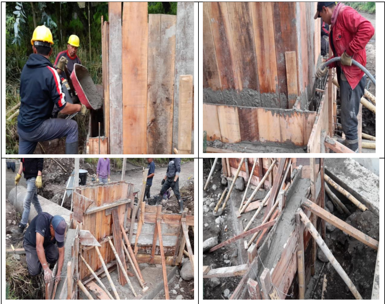
Figura 52. Fundición y vibrado del concreto en aletas y cajilla
