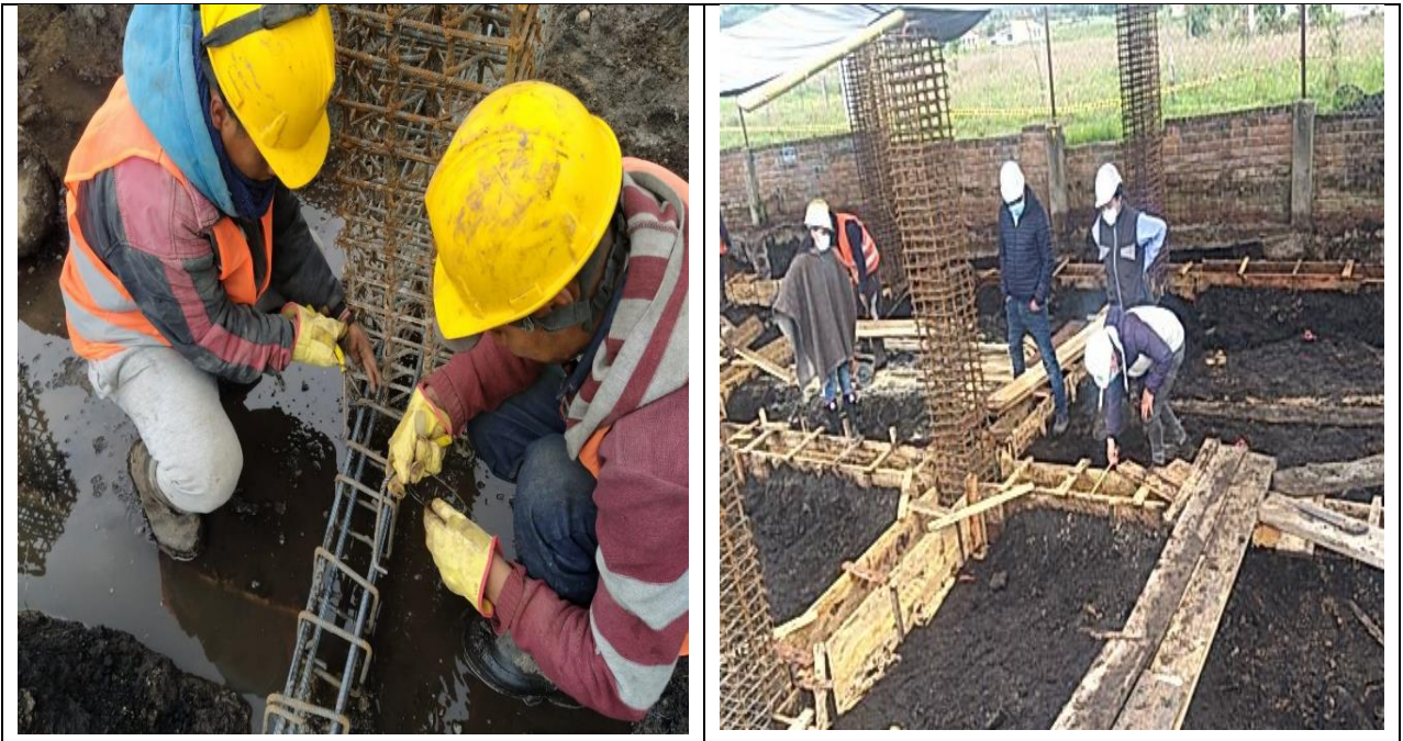
Figura 17. Verificación armado vigas de cimentación
