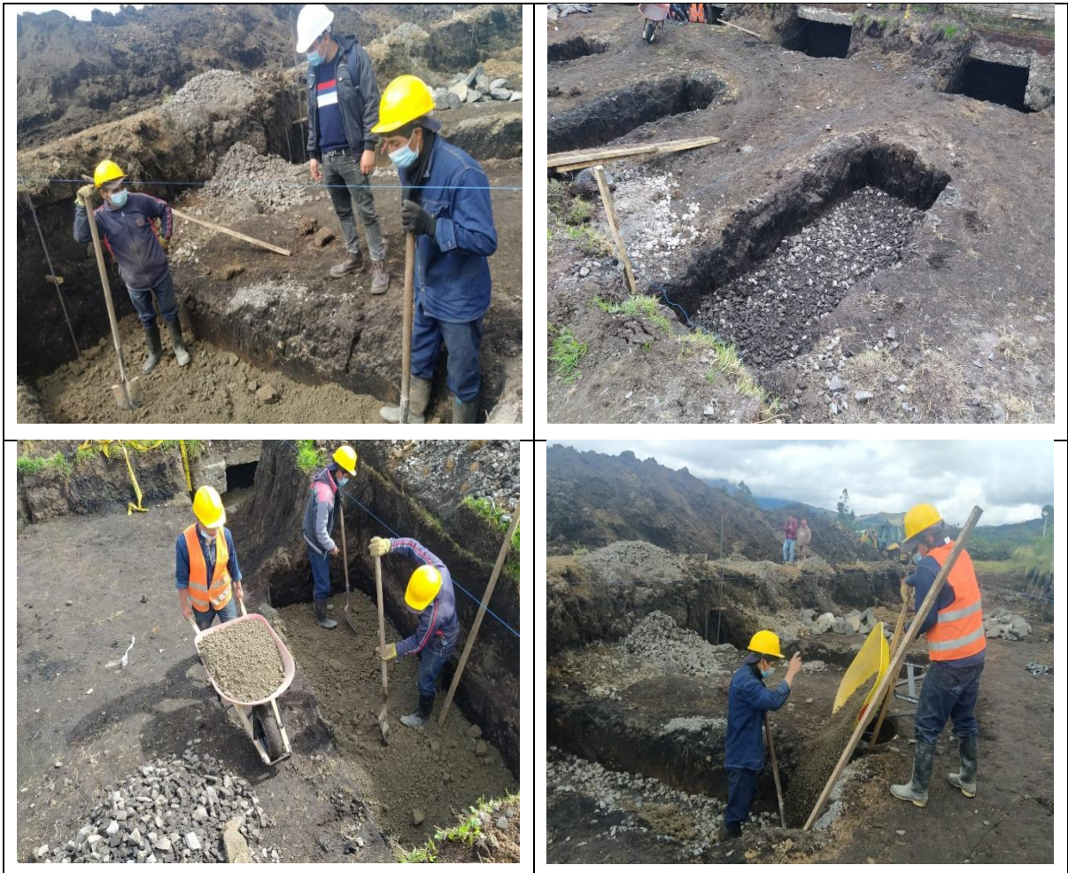
Figura 9. Mejoramiento de suelo cemento para zapatas
