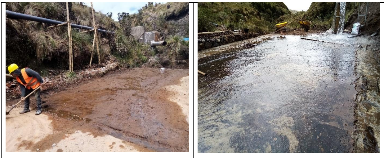
Figura 28. Mejoramiento con concreto ciclópeo
