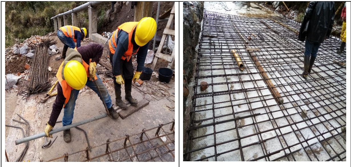
Figura 32. Verificación armado de acero piso
