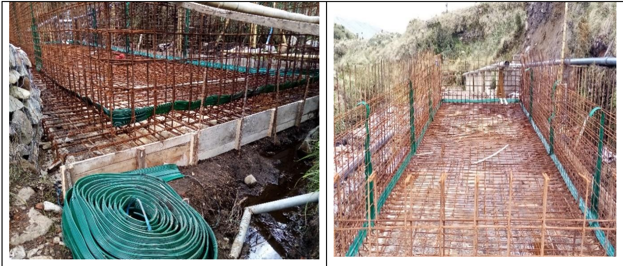
Figura 35. Verificación e instalación de cinta PVC
