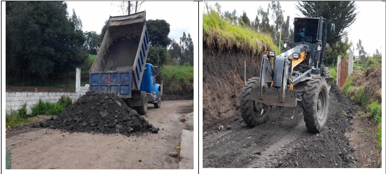
Figura 44. Verificación de riego y nivelación de material de recebo
