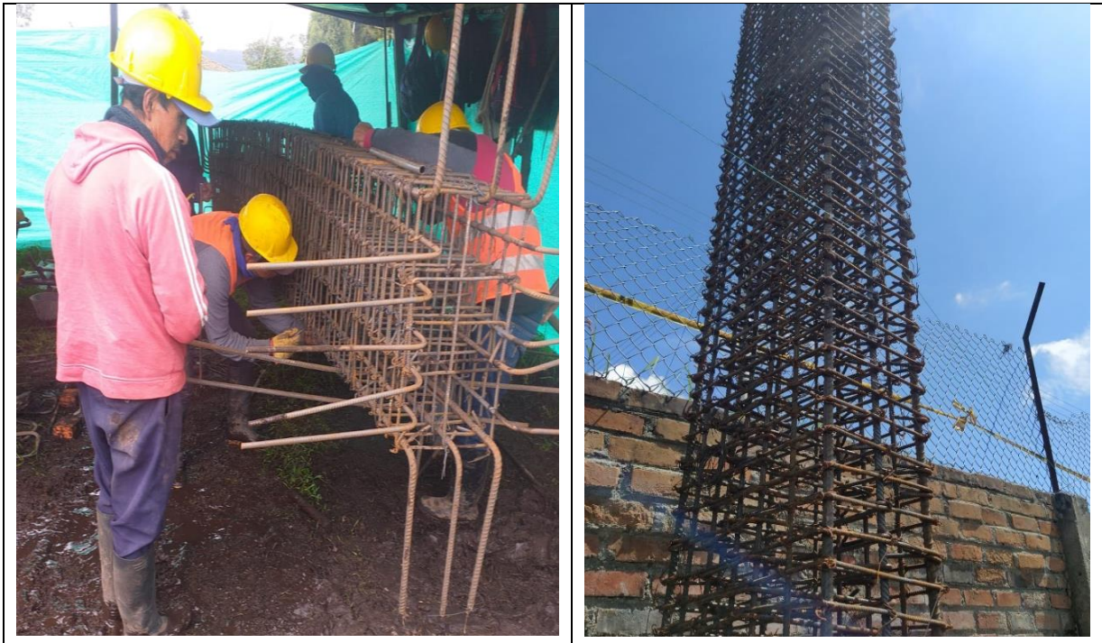
Figura 15. Verificación armado de acero columnas
