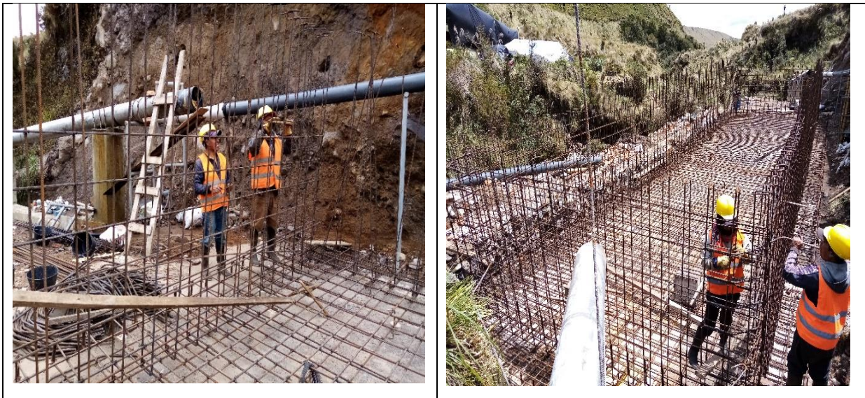
Figura 34. Verificación de armado y amarre de acero muros
