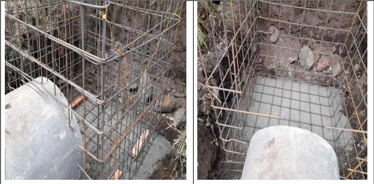
Figura 49. Armado de acero para cajilla
