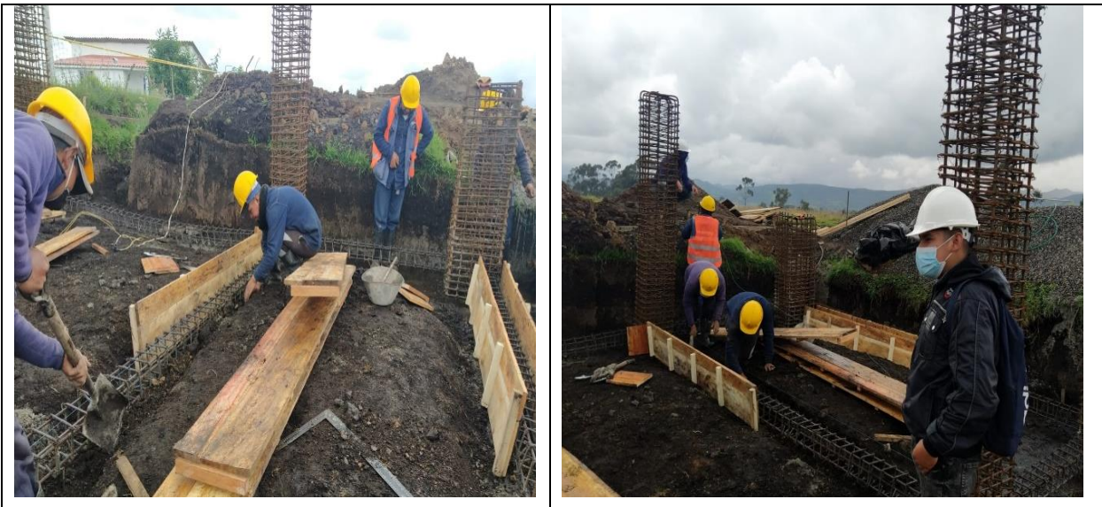
Figura 18. Verificación encofrado vigas de cimentación
