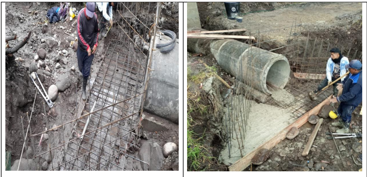
Figura 48. Armado de acero para aletas
