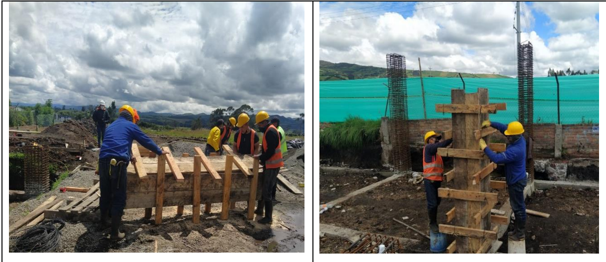
Figura 23. Verificación encofrado en columnas
