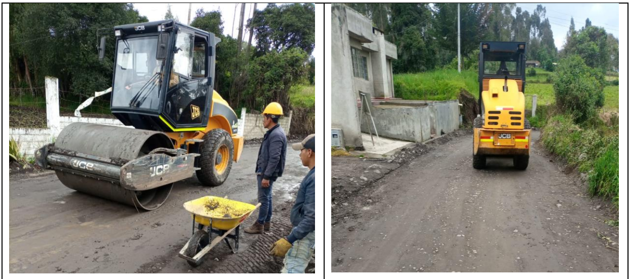
Figura 45. Verificación de compactación material de recebo
