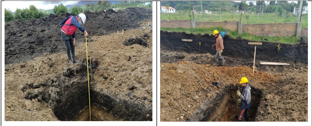
Figura 10. Verificación profundidad de excavación de zapatas
