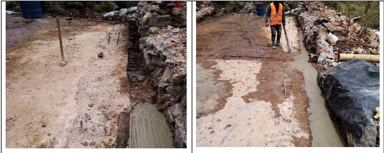
Figura 27. Solado en concreto pobre
