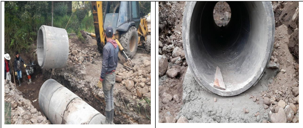
Figura 47. Verificación de tubos puestos en sitio
