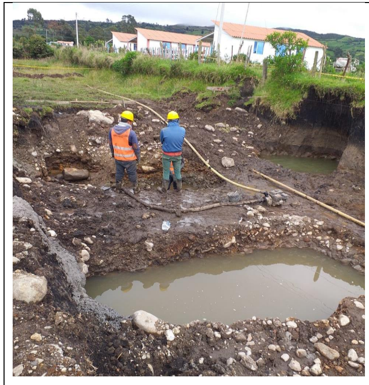
Figura 61. Extracción de agua con motobomba
