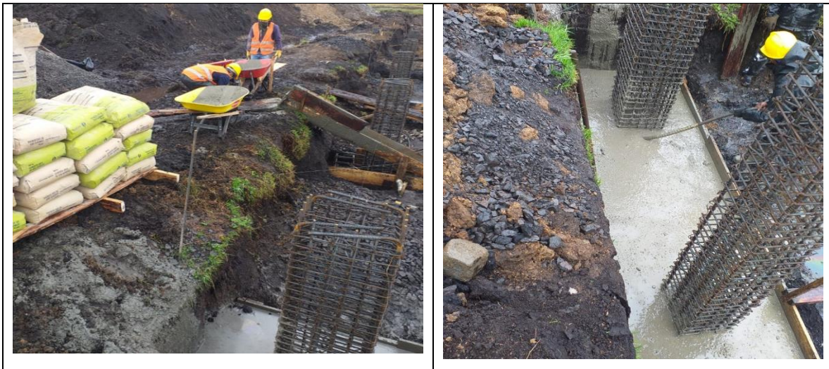
Figura 21. Fundición y vibrado de concreto
