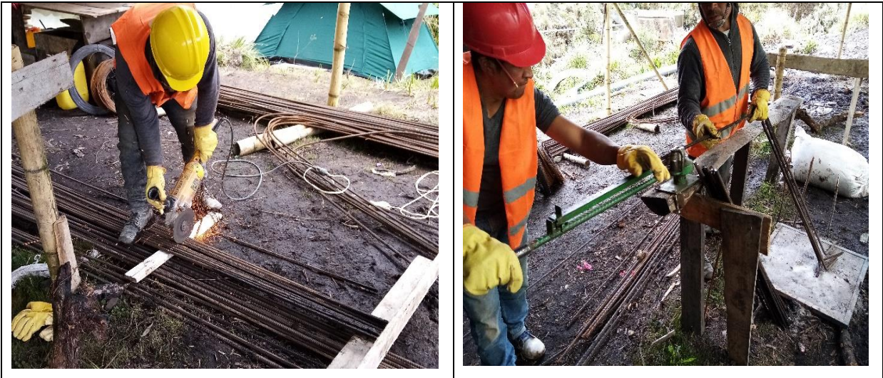
Figura 29. Corte y armado de acero
