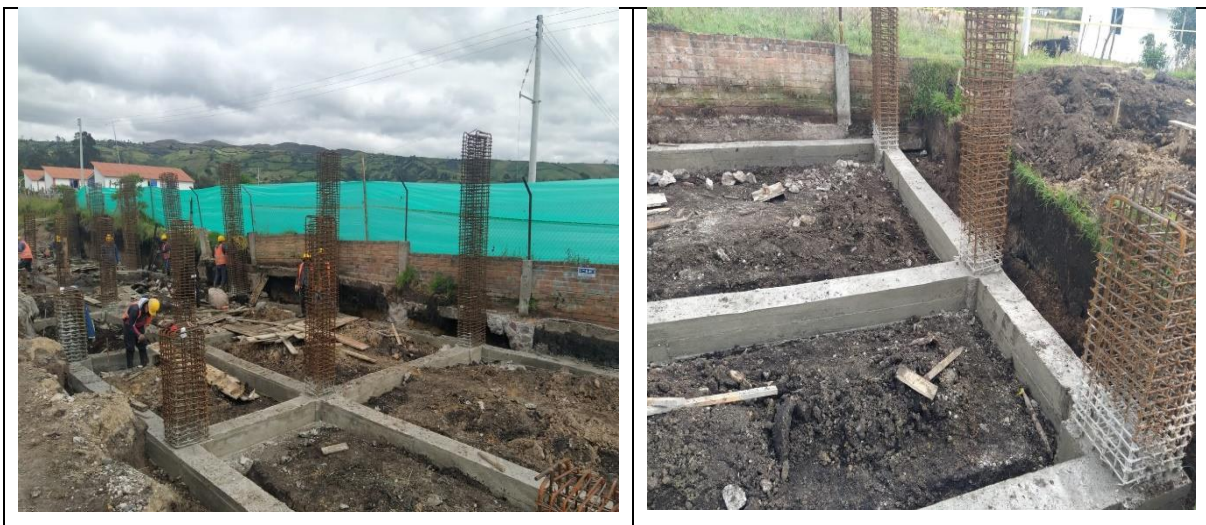
Figura 22. Desencofrado y resultado vigas de cimentación
