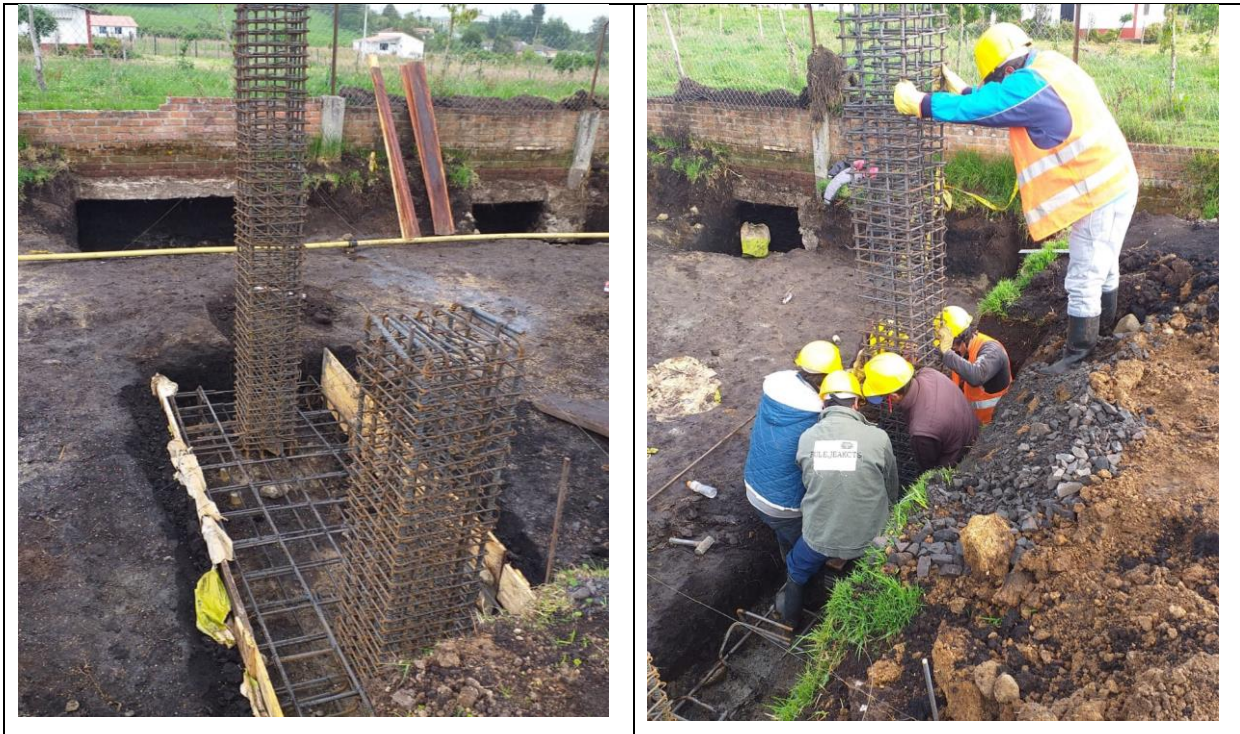
Figura 13. Armado de acero zapatas
