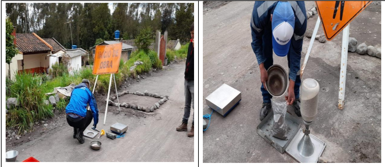
Figura 46. Verificación toma de muestras de suelo
