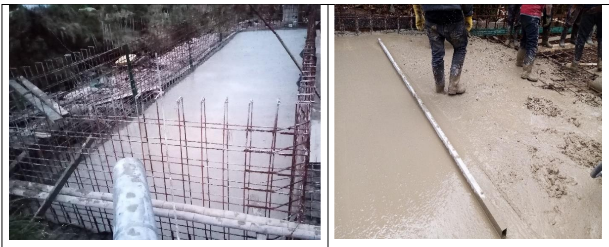
Figura 36. Verificación de fundición losa concreto piso (4000 PSI)
