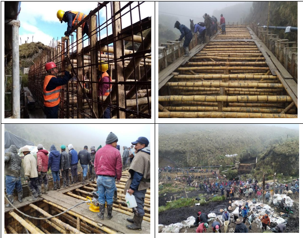
Figura 37. Verificación de fundición de concreto muros estructurales. (4000 PSI)
