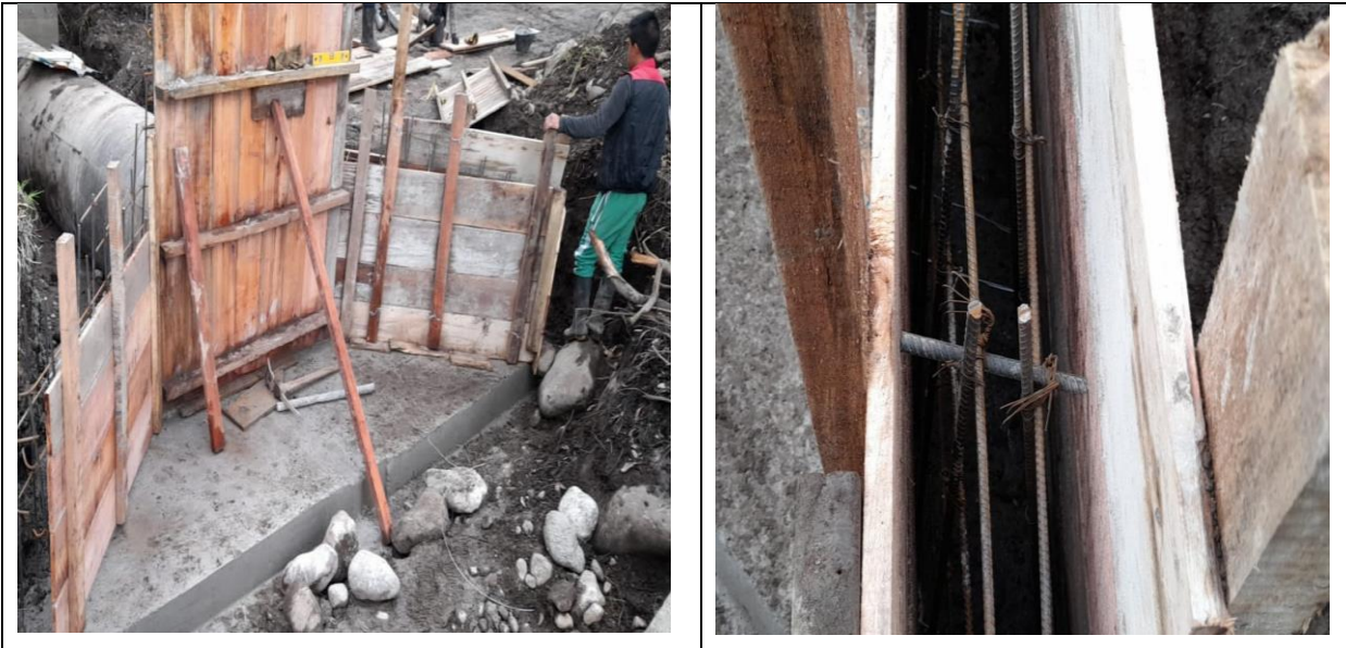
Figura 50. Encofrado para aletas y cajilla
