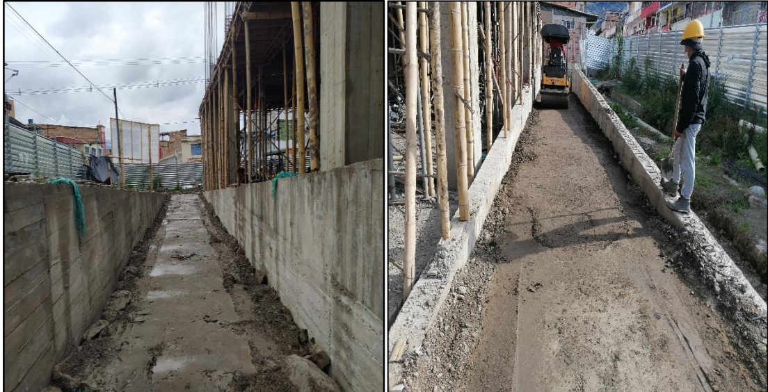
Ilustración 36. Foto tomada en obra, muros laterales de contención para rampa de acceso.
