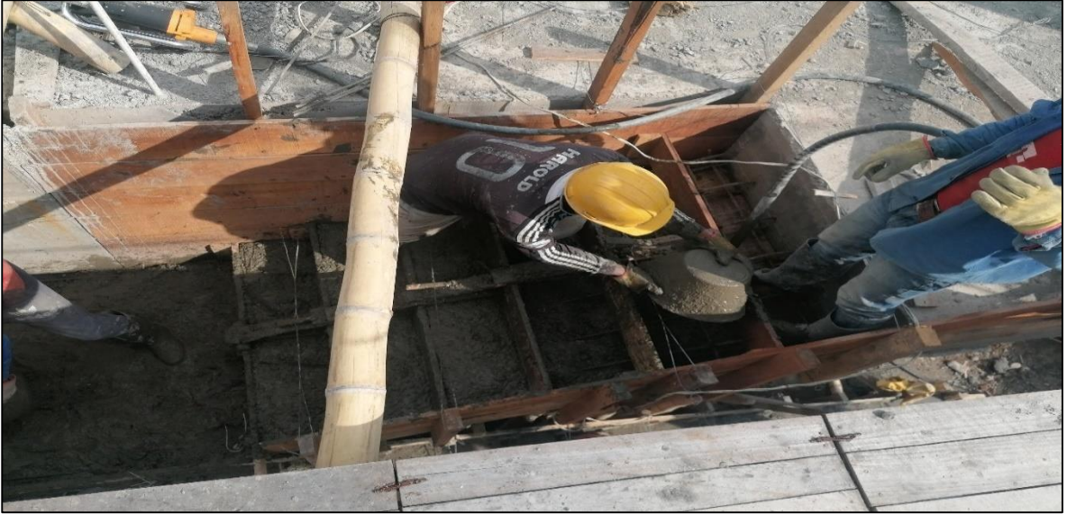
Ilustración 19. Foto tomada en obra, fundición y vibrado de escalera.
