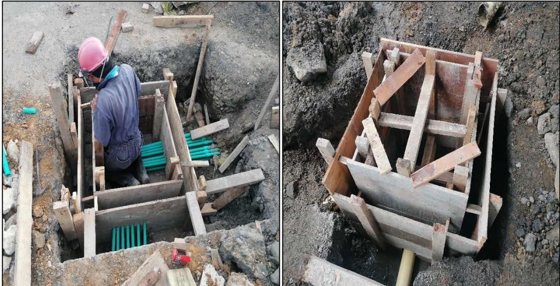
Ilustración 44. Foto tomada en obra, formaleta para caja de inspección.
