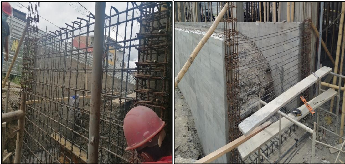
Ilustración 39. Foto tomada en obra, armado de acero para muro de contención.
