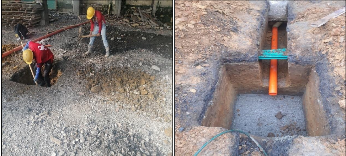
Ilustración 43. Foto tomada en obra, excavación y solado de limpieza para caja de inspección.
