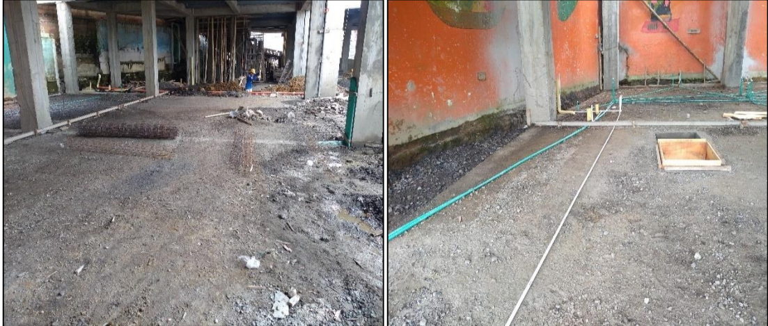
Ilustración 55. Foto tomada en obra, área de fundición para losa de contrapiso.
