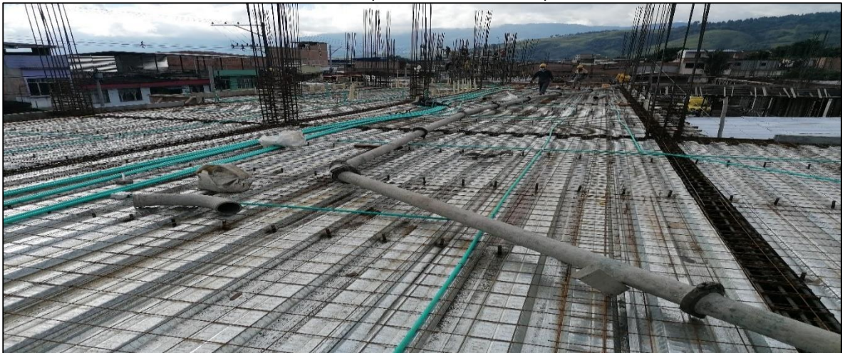
Ilustración 22. Foto tomada en obra, tubería transportadora de concreto para fundición.
