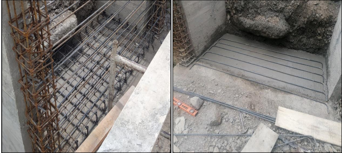
Ilustración 37. Foto tomada en obra, cimentación para muro de contención.
