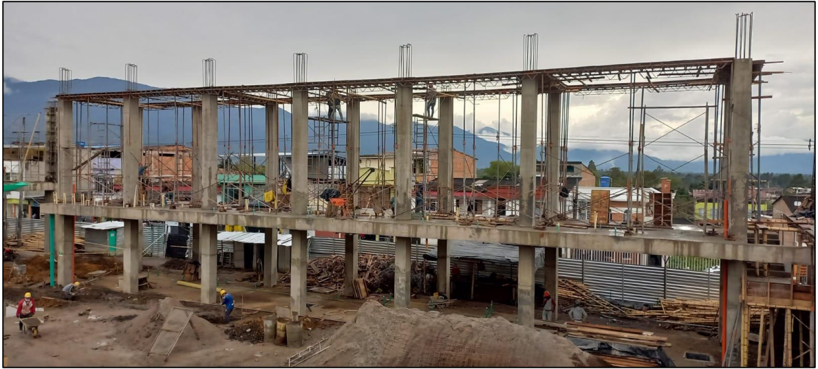
Ilustración 29. Foto tomada en obra, formaleta inferior para vigas aéreas.
