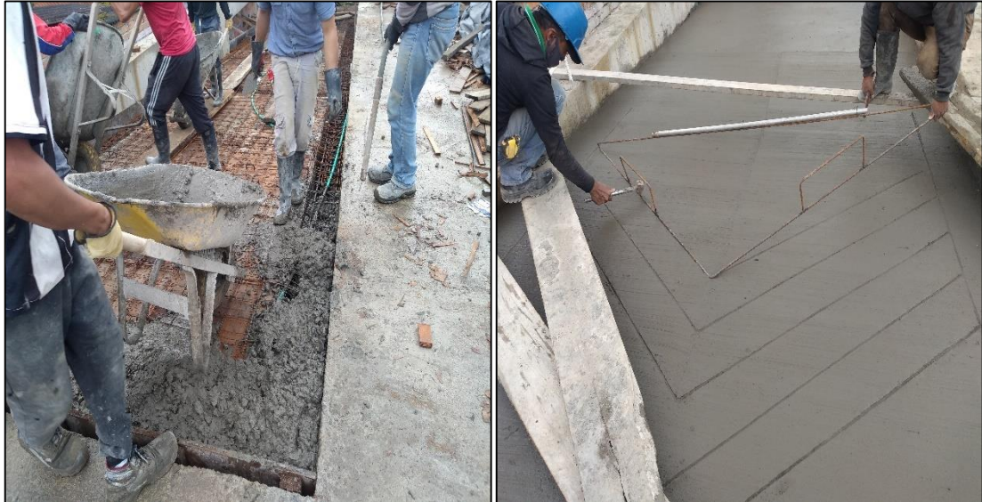
Ilustración 54. Foto tomada en obra, fundición de rampa de acceso en concreto 3000 PSI.
