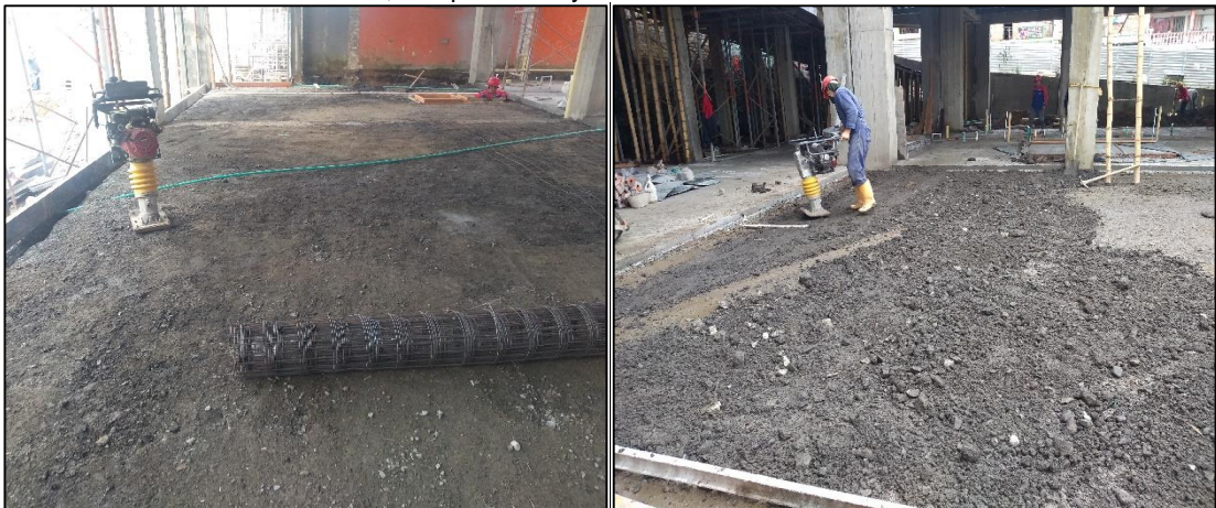
Ilustración 56. Foto tomada en obra, compactación y nivelación del suelo.
