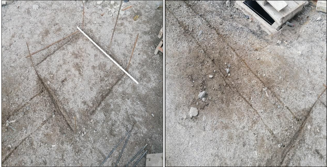
Ilustración 42. Foto tomada en obra, demarcación de lugar de construcción, para caja de inspección.
