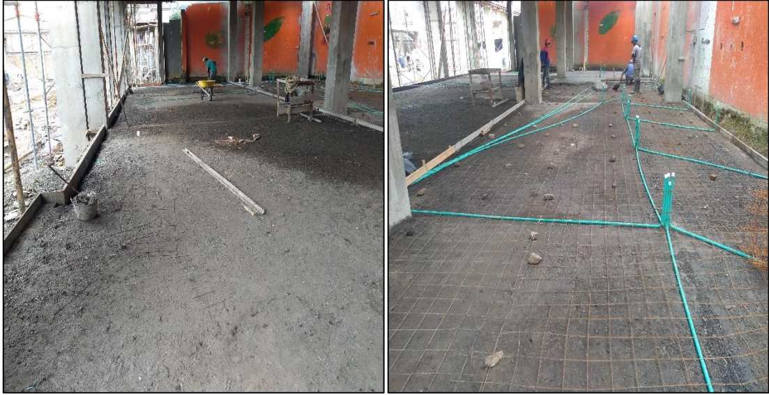
Ilustración 58. Foto tomada en obra, instalación de conexiones y malla electrosoldada.
