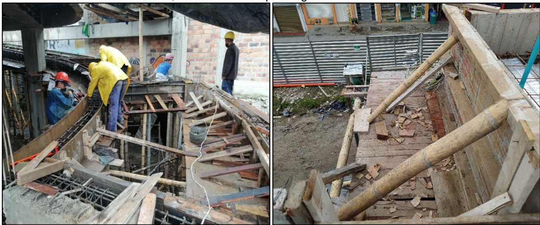
Ilustración 32. Foto tomada en obra, formaleta lateral para vigas.
