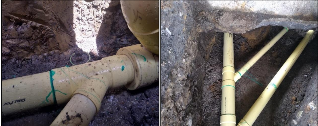
Ilustración 49. Foto tomada en obra, unión de la tubería PVC.
