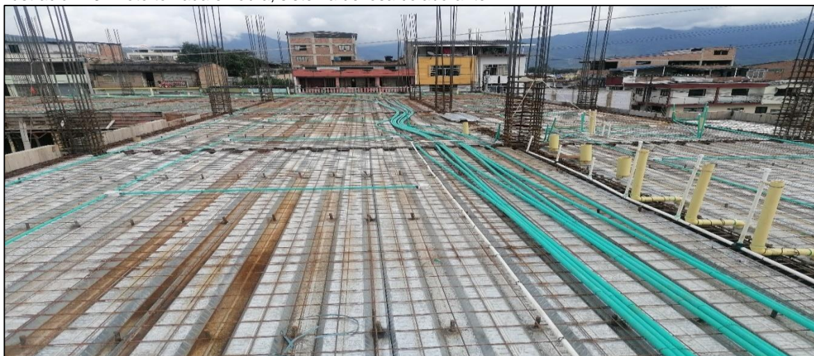
Ilustración 23. Foto tomada en obra, sistema de losa colaborante.
