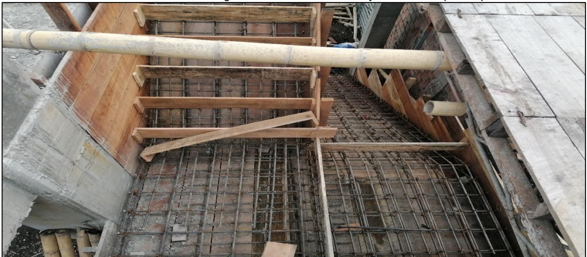
Ilustración 18. Foto tomada en obra, configuración acero de refuerzo y formaleta superior, para escalera.
