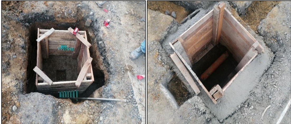
Ilustración 45. Foto tomada en obra, fundición caja de inspección.
