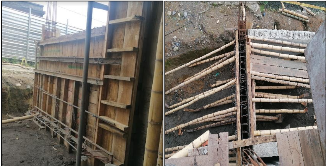
Ilustración 40. Foto tomada en obra, formaleta para muro de contención.
