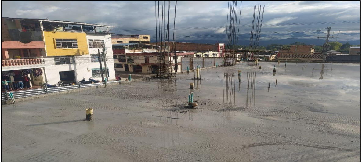
Ilustración 27. Foto tomada en obra, losa de entrepiso fundida, bloque 2 (dos).
