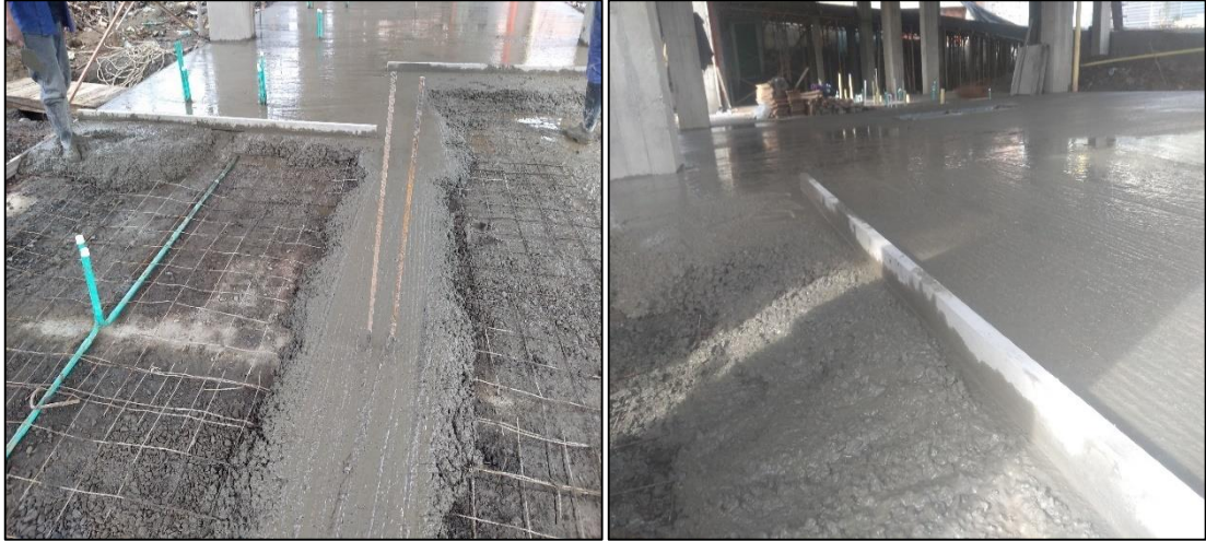
Ilustración 59. Foto tomada en obra, fundición y nivelación de placa de contrapiso.
