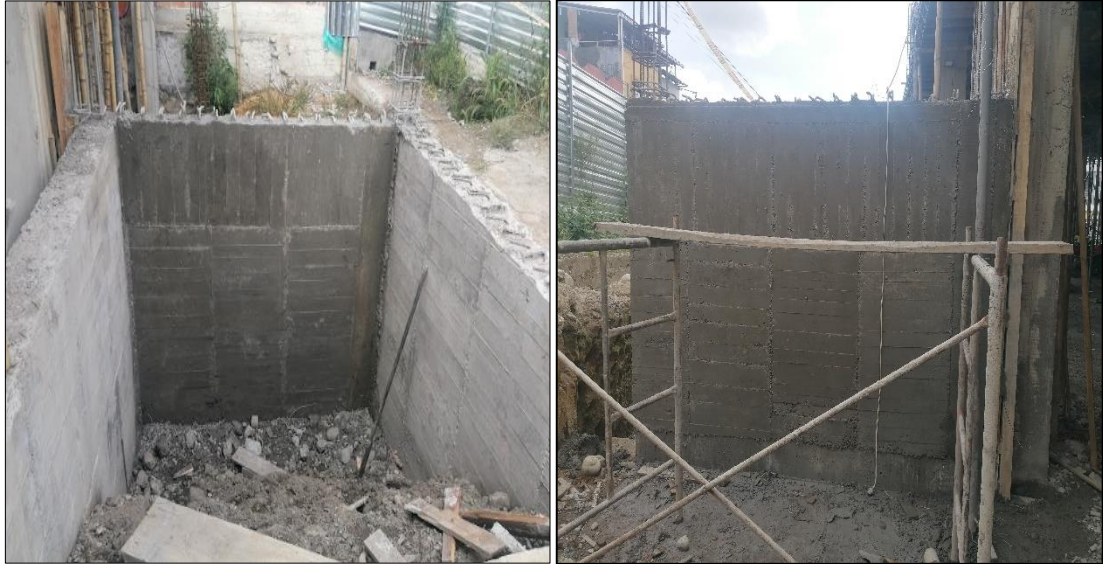
Ilustración 41. Foto tomada en obra, muro fundido para rampa de acceso.
