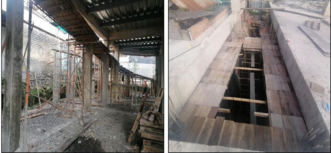
Ilustración 50. Foto tomada en obra, sistema de apoyo, rampa de acceso.
