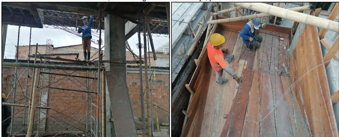
Ilustración 17. Foto tomada en obra, acero longitudinal de anclaje, para escalera.
