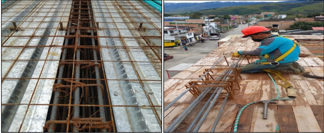
Ilustración 31. Foto tomada en obra, configuración de aceros, viga área.
