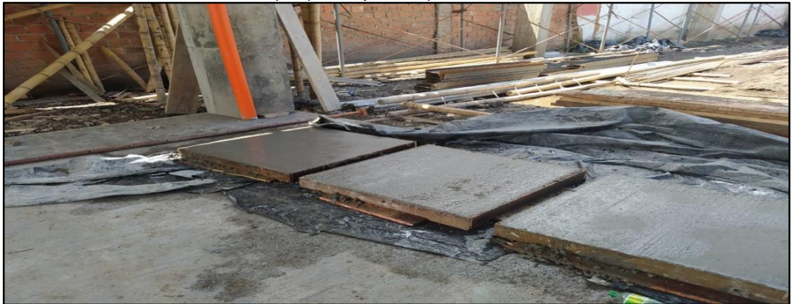
Ilustración 48. Foto tomada en obra, tapas para caja de inspección.
