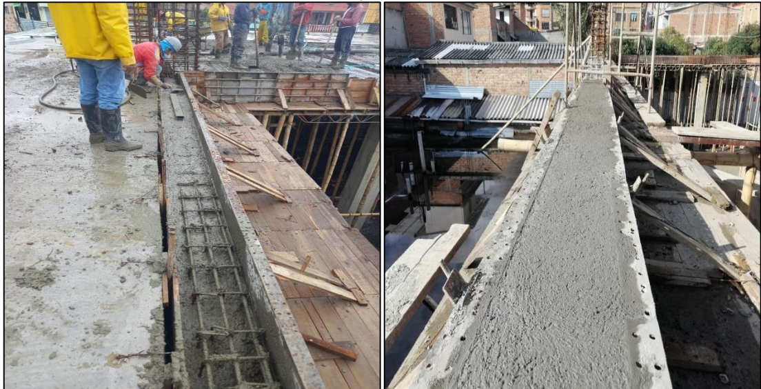
Ilustración 33. Foto tomada en obra, fundición de vigas áreas en concreto 3000 PSI.
