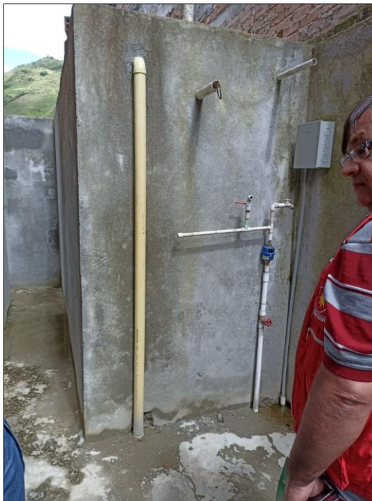
Imagen 44. Tanque proyecto La Torre Páez, Cauca Fuente: Propia
