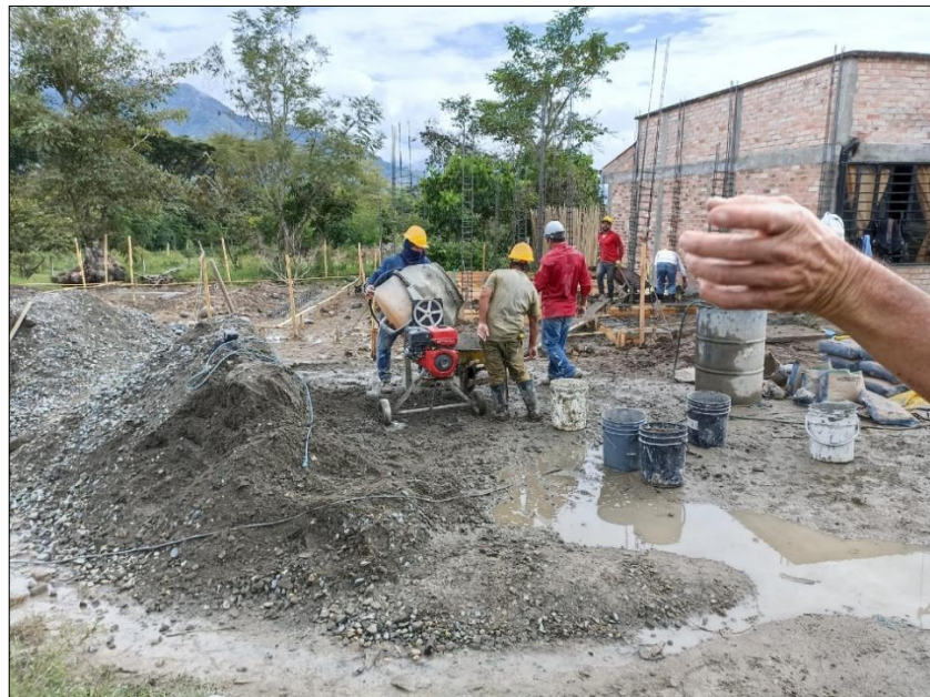
Imagen 18. Fundición cimentación, Tablón II Fuente: Propia
