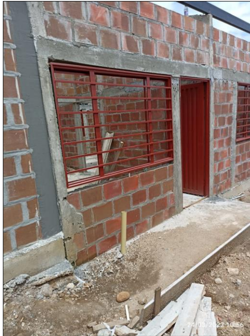
Imagen 5. Fachada vivienda proyecto Gigante, Huila Fuente: Propia
