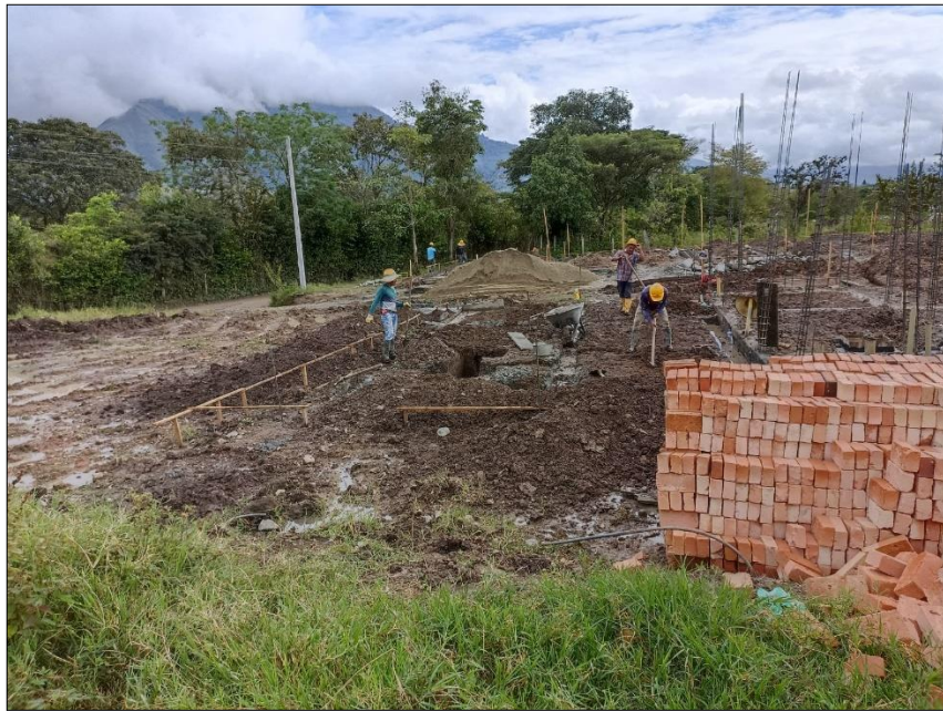
Imagen 17. Excavación para cimentación, Tablón II Fuente: Propia
