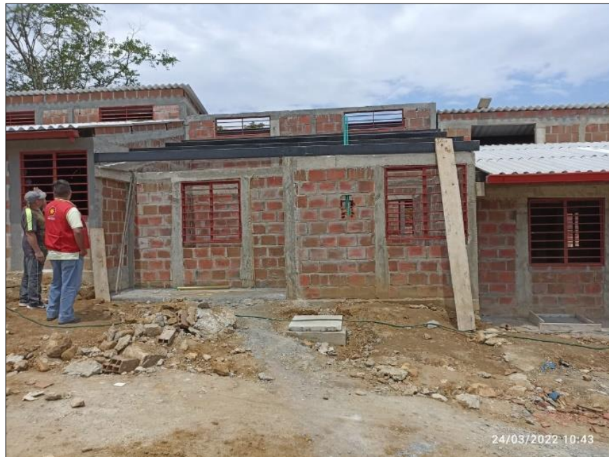
Imagen 4. Instalación de cubierta proyecto Gigante, Huila Fuente: Propia
