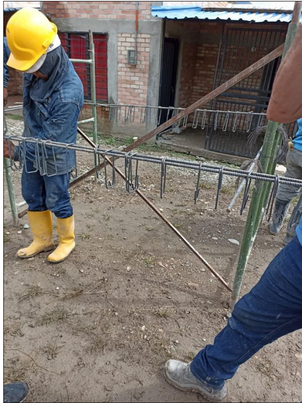
Imagen 19. Armado de acero de refuerzo, Tablón II Fuente: Propia
