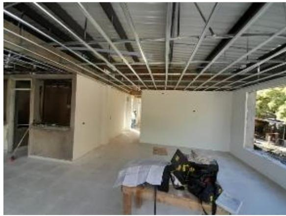
Figura 18 Instalación Cielo Falso
