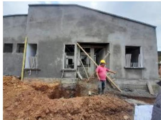
Figura 80 Excavación Cuneta y caja de inspección.
