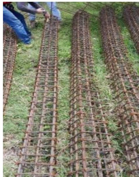
Figura 36 Verificación medidas flejes de columnas.
