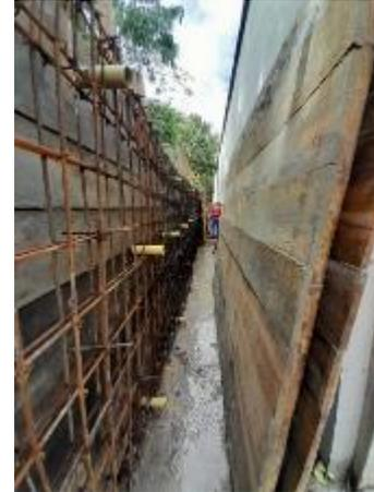
Figura 23 Lagrimales Muro de contención
