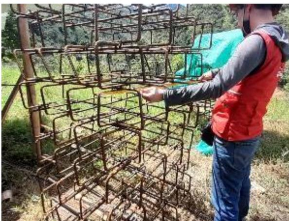
Figura 41 Verificación flejes zapatas
