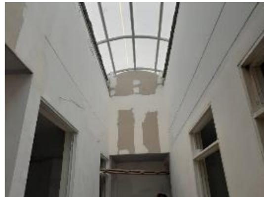
Figura 64 Cubierta de policarbonato.
