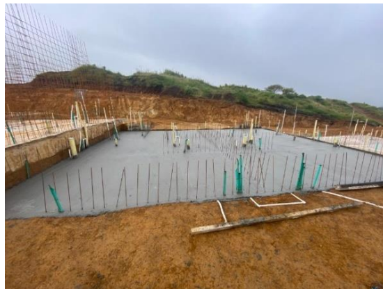
Ilustración 32. Losa de cimentación fundida pacha de 2 casas Fuente: Elaboración propia
