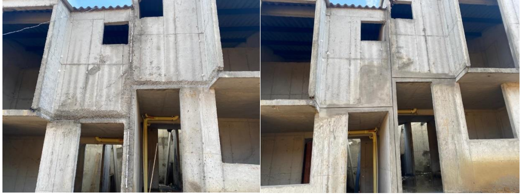
Ilustración 56. Juntas entre casas por cambio de nivel Fuente: Elaboración propia
