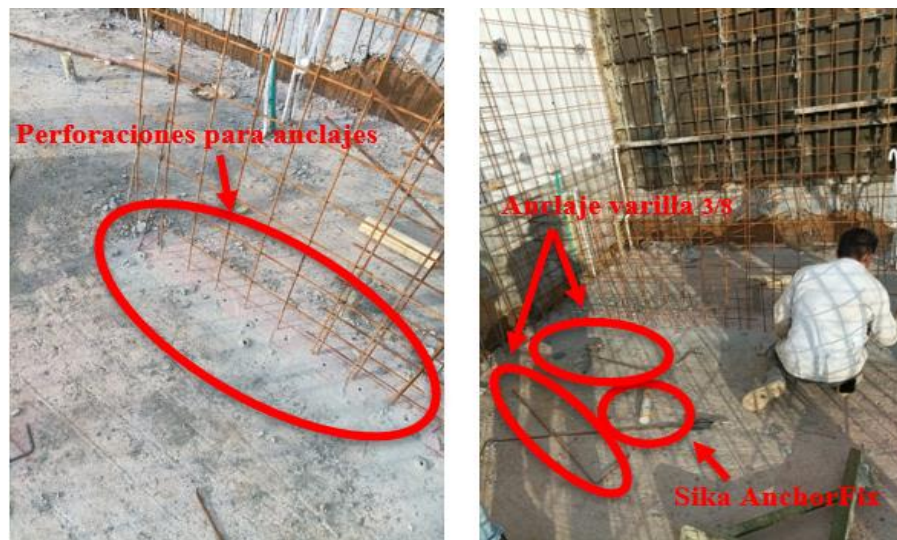
Ilustración 18. Instalación de Anclajes con Sikadur AnchorFix-4 Fuente: Elaboración propia
