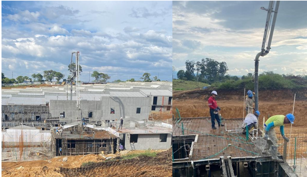
Ilustración 47. Fundición primer nivel Fuente: Elaboración propia
