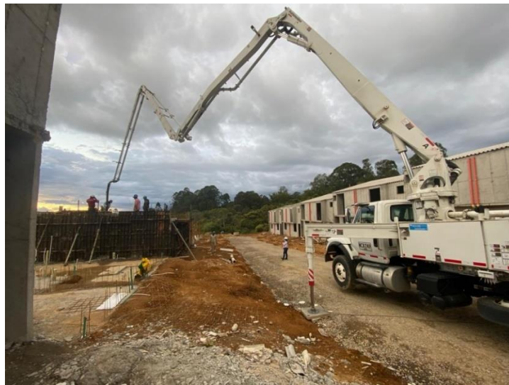
Ilustración 43. Autobomba anclada y lista para fundición Fuente: Elaboración propia
