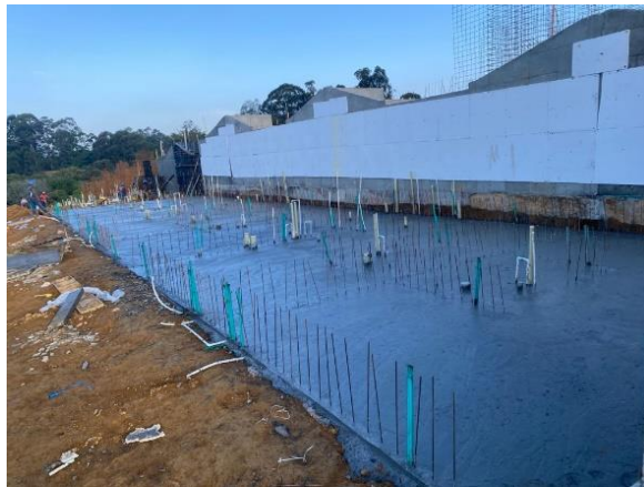
Ilustración 31. Losa de cimentación fundida pacha de 6 casas Fuente: Elaboración propia
