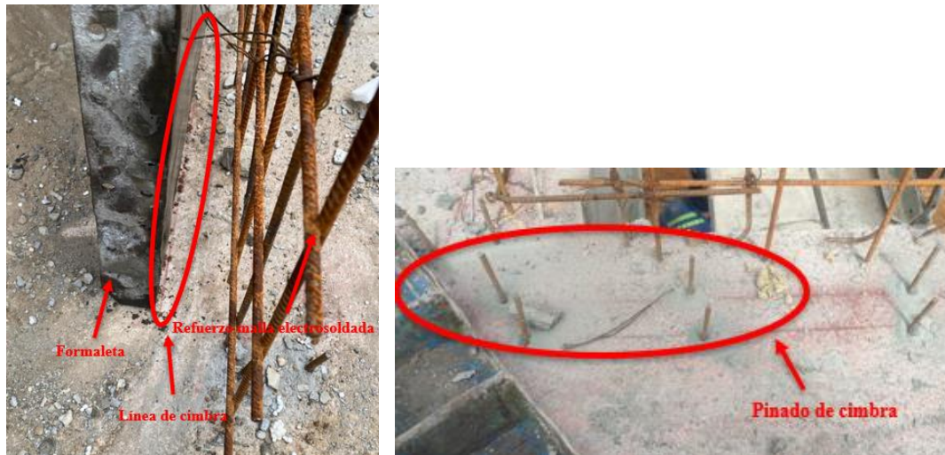
Ilustración 35. Inspección de ubicación de formaleta Fuente: Elaboración propia
