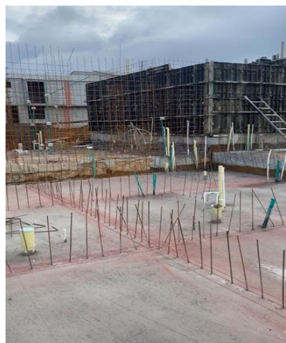
Ilustración 15. Cimbrado en losa de cimentación Fuente: Elaboración propia
