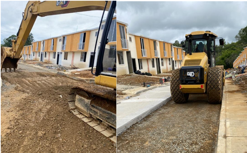
Ilustración 57. Cereo de vías Fuente: Elaboración propia
