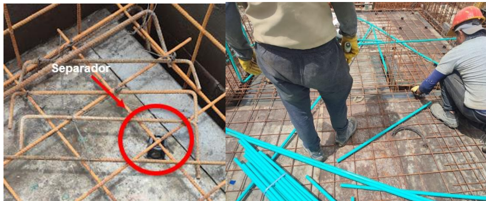
Ilustración 39. Refuerzo de acero en losa de entrepiso Fuente: Elaboración propia
