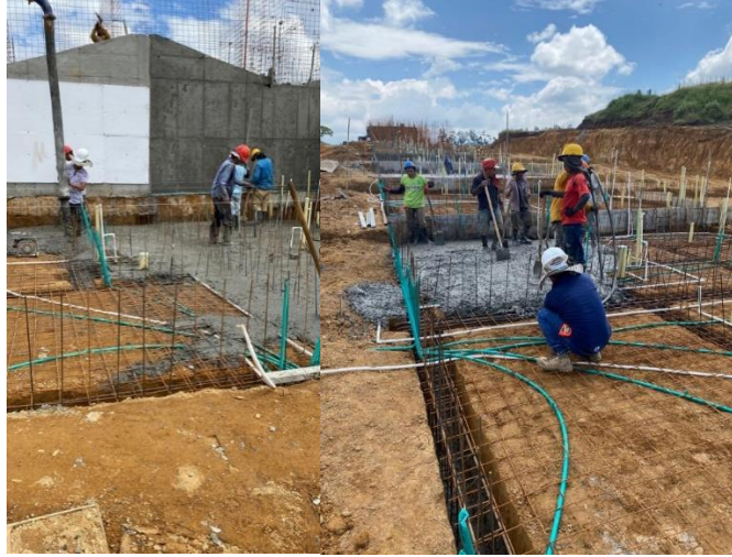
Ilustración 30. Fundición de cimentación Fuente: Elaboración propia
