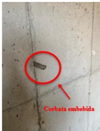
Ilustración 54. Corbata embebida Fuente: Elaboración propia
