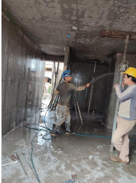
Ilustración 49. Proceso de curado de elementos fundidos Fuente: Elaboración propia
