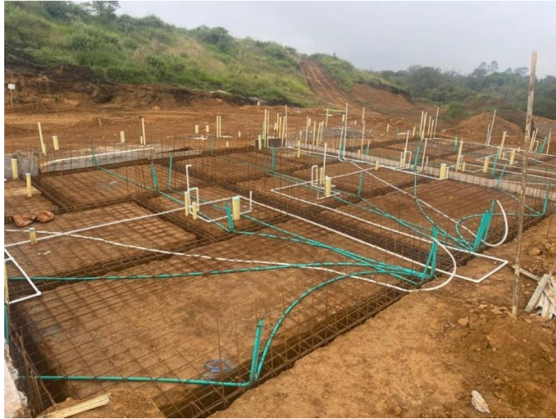
Ilustración 29. Cimentación apta antes del proceso de fundición Fuente: Elaboración propia
