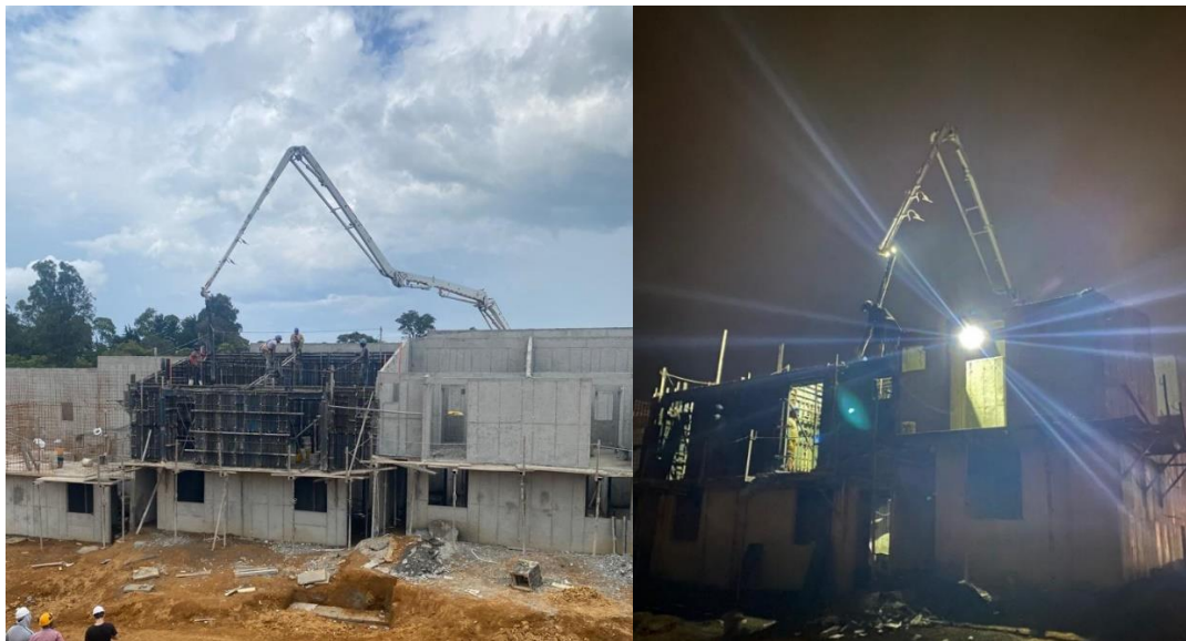
Ilustración 48. Fundición diurna y nocturna segundo nivel Fuente: Elaboración propia
