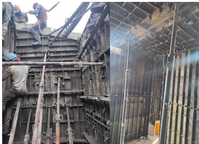
Ilustración 37. Atrancado de muros y losa con ayuda de gatos tensores Fuente: Elaboración propia
