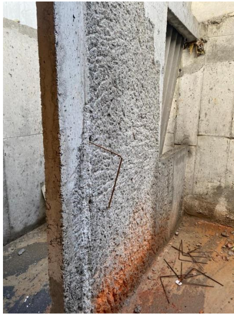
Ilustración 53. Muro picado Fuente: Elaboración propia
