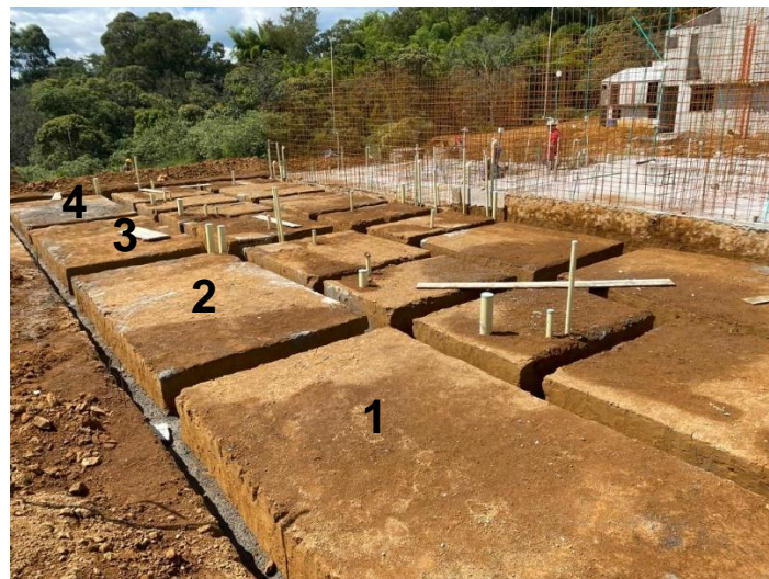
Ilustración 21. Excavación para cimentación en pacha de 4 casas Fuente: Elaboración propia.
