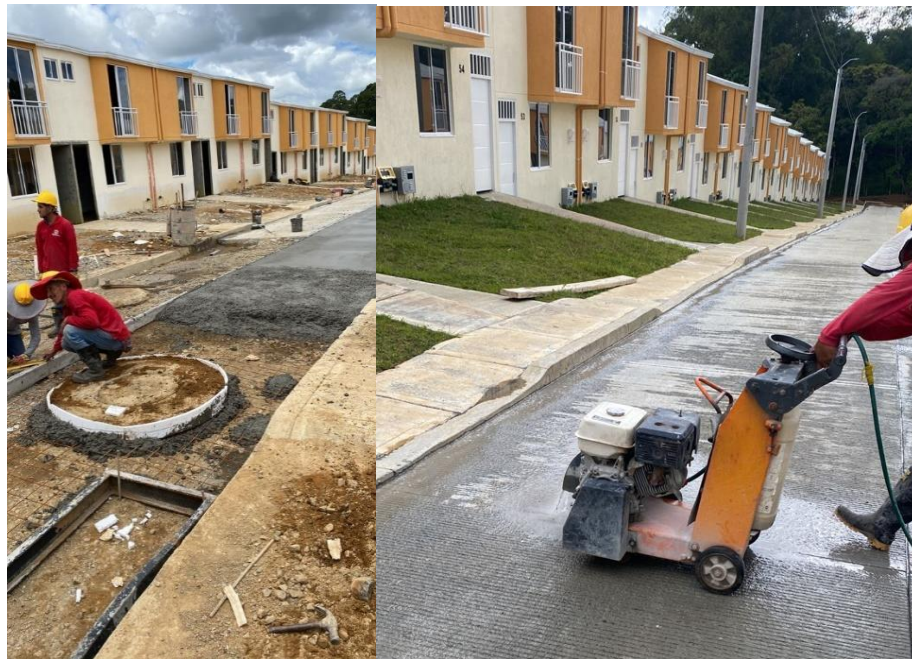
Ilustración 59. Pavimentación de vías y corte de juntas Fuente: Elaboración propia
